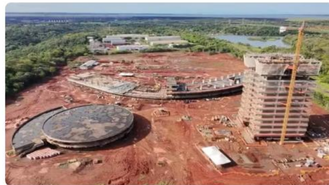
Obras do campus Arandu — Foto: Unops
