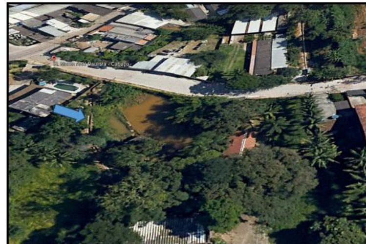
Figura 19: Canaleta de drenagem implantada no imóvel do autor, Google janeiro/2020
