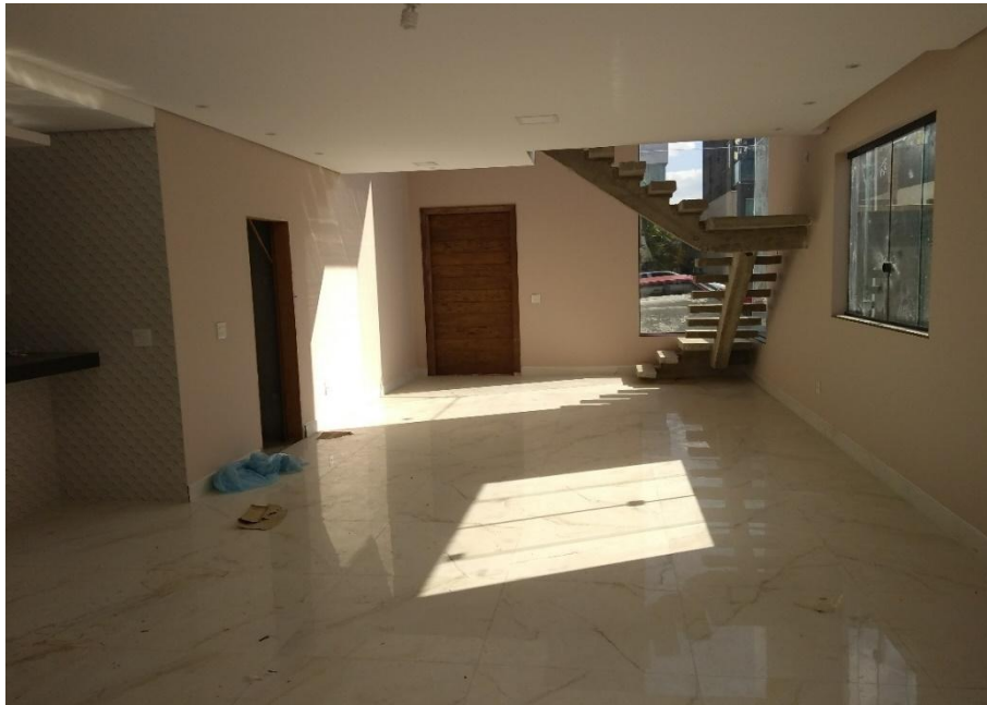
Imagem 2 – Vista geral da sala de estar/jantar do imóvel periciado
