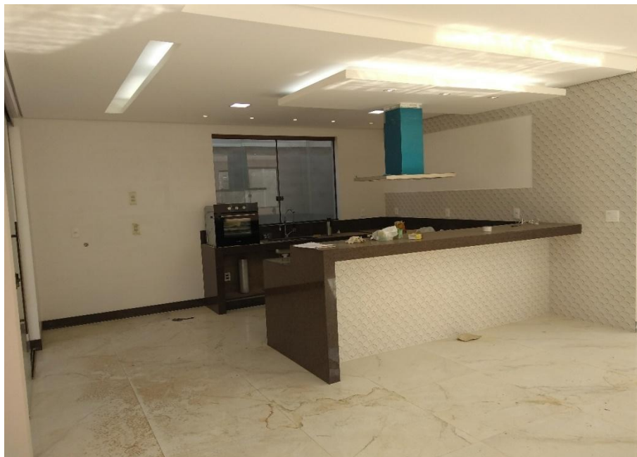
Imagem 1 – Vista geral da cozinha do imóvel periciado
