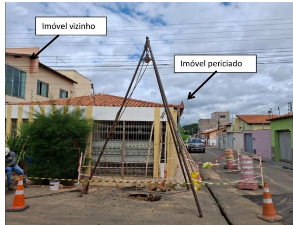
Figura 10 - Registro do teste de percolação em campo.
