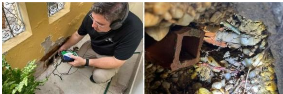
Figura 5 – Esquerda: execução de sondagem com geofone, para identificação de vazamento oculto (direita).
