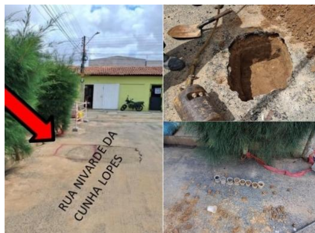
Figura 9 – Esquerda: marcação do ponto de execução da sondagem SPT. Direita: execução dos ensaios SPT (superior) e coleta de amostras de solo (inferior).
