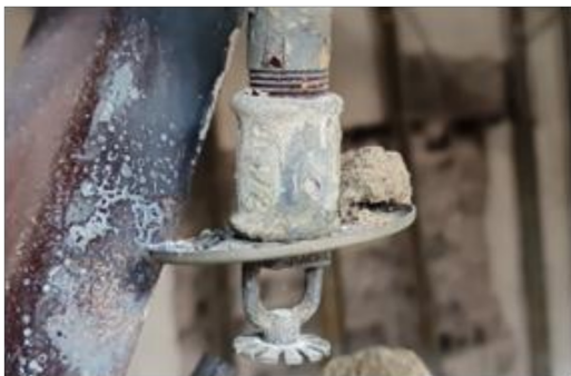
Figura 8 - Acionamento do bulbo do sprinkler
