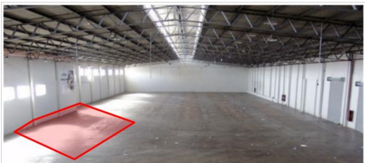
Figura 22 - Edificação anterior as modificações e acréscimos de cargas – Fonte Internet: André Rebouças – link: https://mapio.net/pic/p-16534382/
