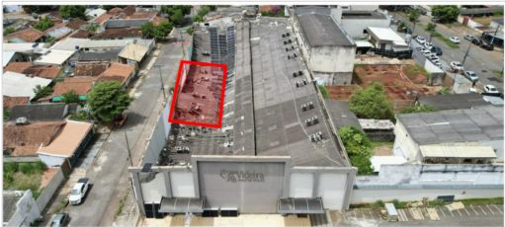
Figura 21 - Foto aérea após colapso estrutural – Arquivo Próprio
