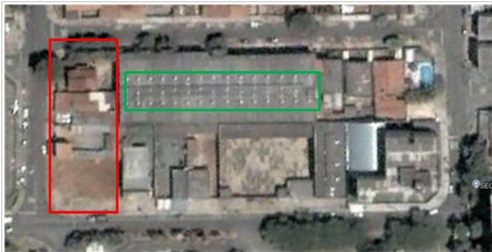
Figura 4 - Imóvel em 11/2003: Anterior a locação pela Igreja - Fonte: Google Earth
