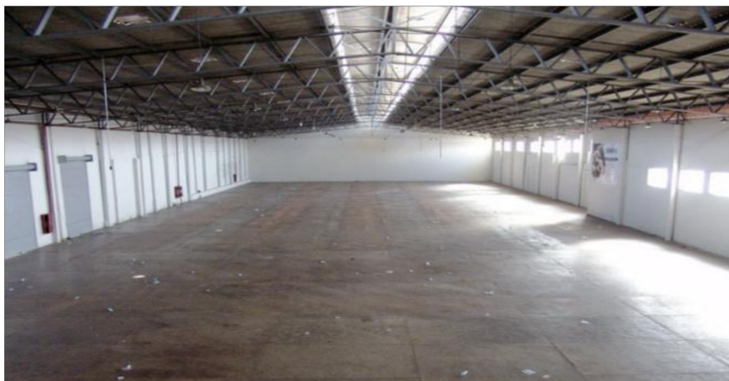
Figura 16 - Edificação original, anterior a modificação para igreja – Fonte Internet: André Rebouças – link: https://mapio.net/pic/p-16534382/
