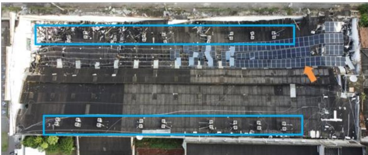
Figura 7 - Imóvel em 24/03/2025 - Fonte: Arquivo próprio
