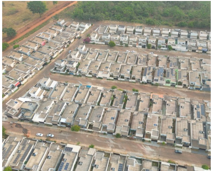
Figura 1: Imagem área de drone do condomínio onde se encontram os imóveis vistoriados. Fonte: Autores, 2024.
