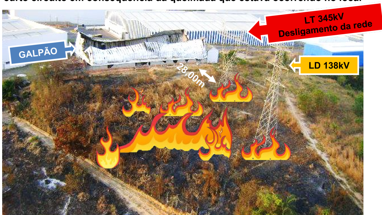
Figura 17 – ÀS 19:13 a Linha de Transmissão 345 kv foi desligada devido a um curto circuito em consequência da queimada que estava ocorrendo no local
