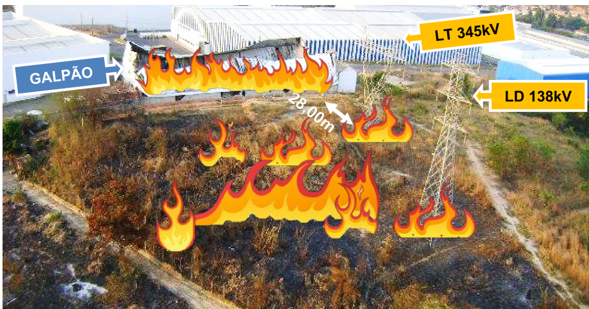
Figura 20 – ÀS 19:40 a câmera de segurança do galpão vizinho registrou que o galpão objeto desse estudo estava completamente tomado pelo incêndio
