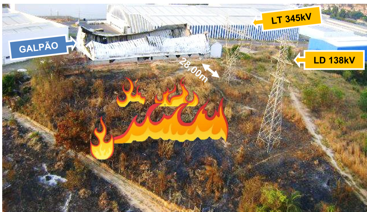
Figura 16 – Fogo intenso na faixa de servidão por volta das 19:00
