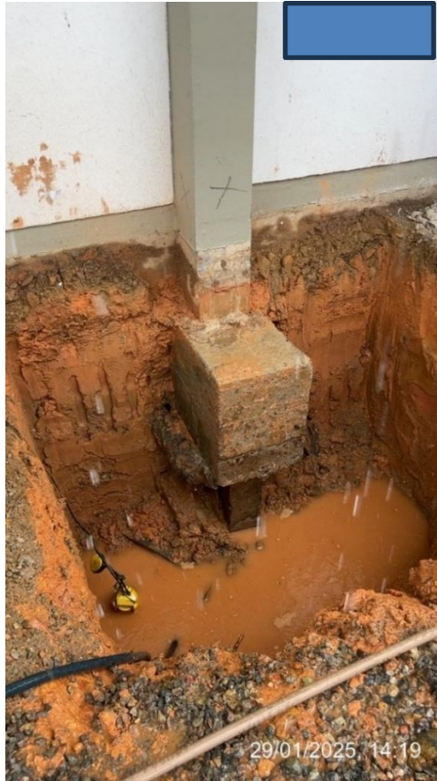
Figura 7 – Inspeção de fundações
