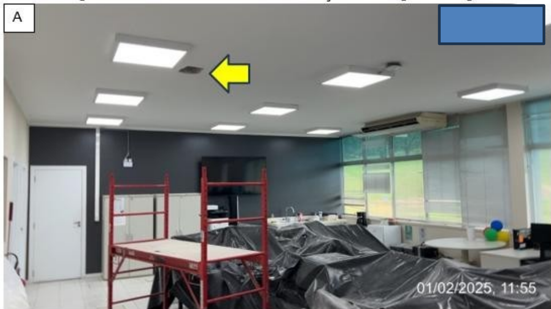
Figura 8 – Caracterização de armaduras principais nas vigas do sistema de cobertura
