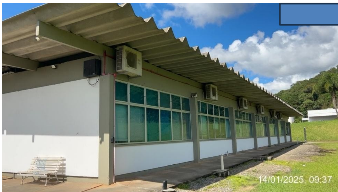
Figura 4 – Vista lateral do prédio e demarcação dos pilares a serem analisados
