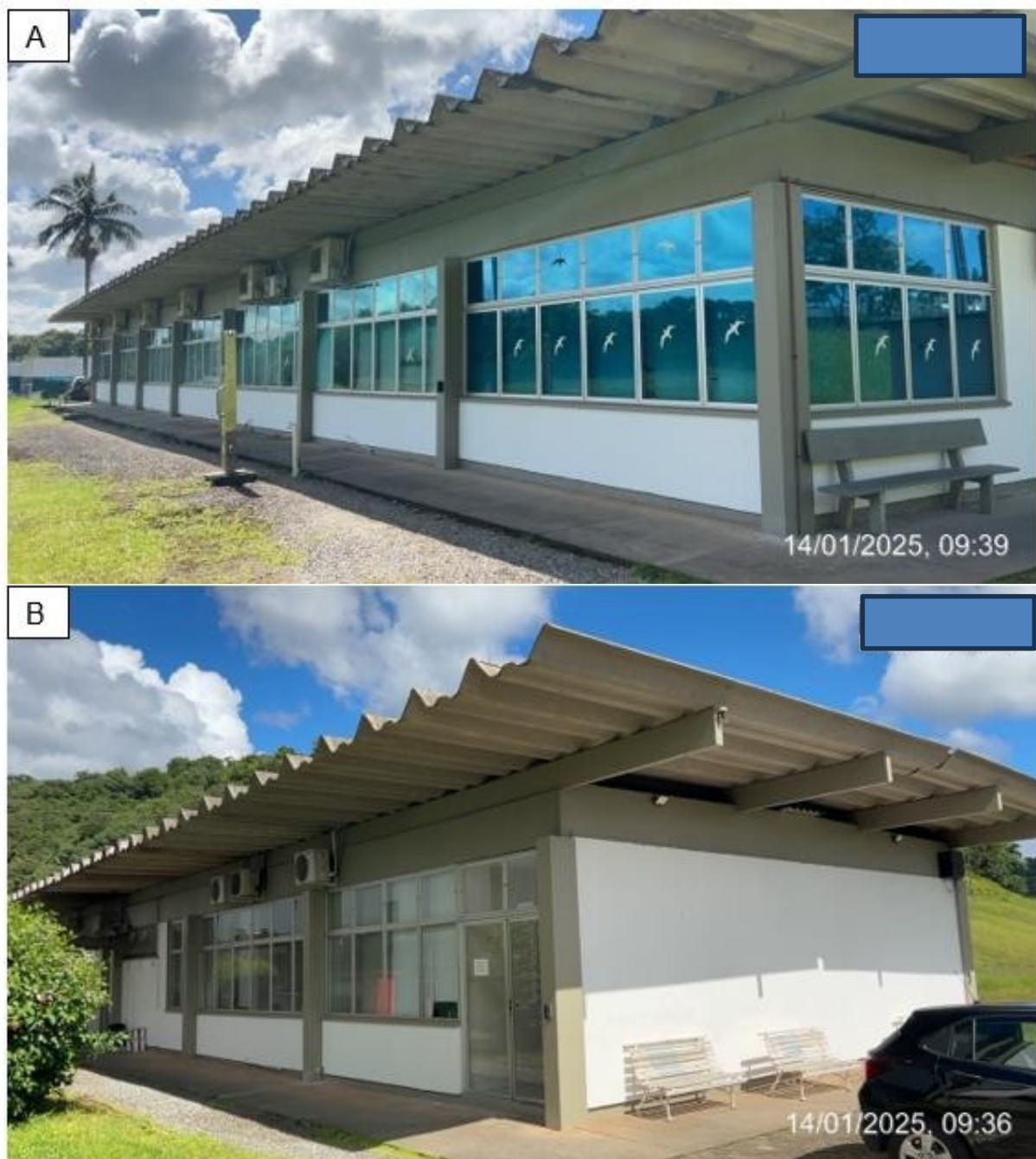
Figura 1 – PRÉDIO TECNOLOGIA. Configuração atual (A e B)
