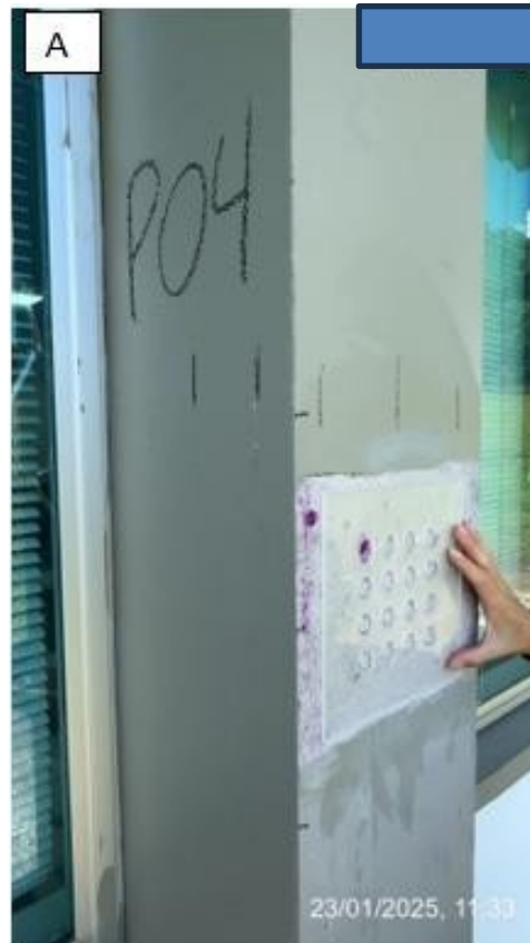
Figura 6 – Realização de Ensaio esclerométrico em pilar
