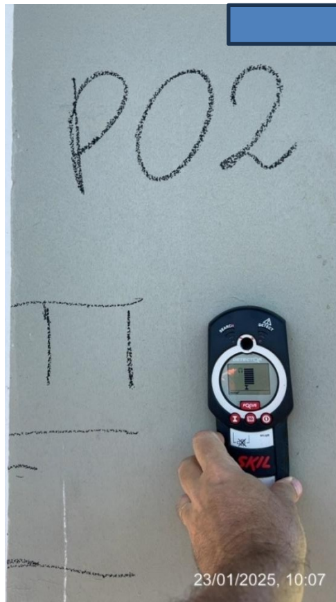
Figura 5 – Pacometria para identificar posição das armaduras e teste de pH do concreto
