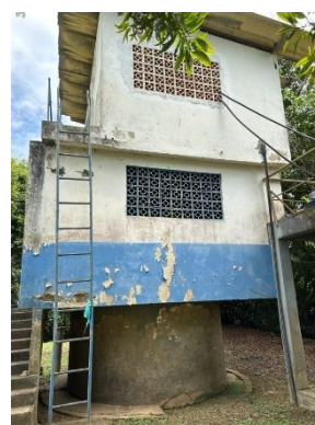
Abrigo dos Painéis
