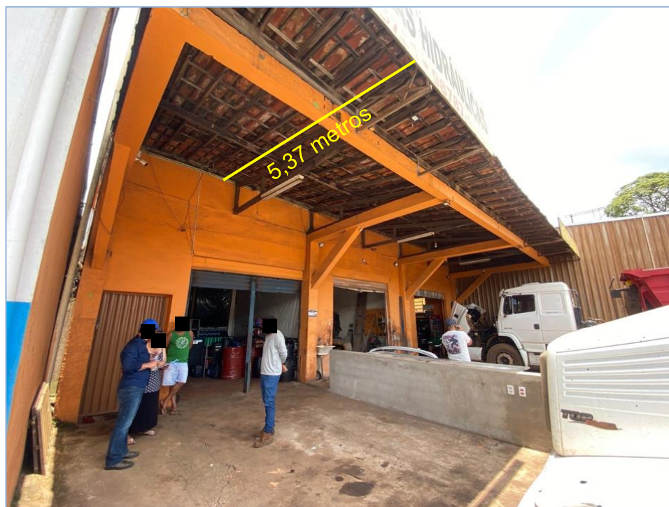
Figura 7: Foto do telhado frontal do imóvel, tomada em vistoria, com indicação de sua profundidade de 5,37 metros (Fonte: autoria própria).
