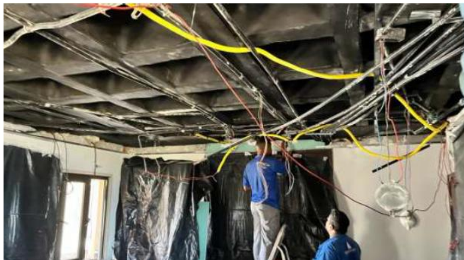
Figura 2 – Instalação da manta de isolamento na laje. Fonte: Elaborado pelos autores
