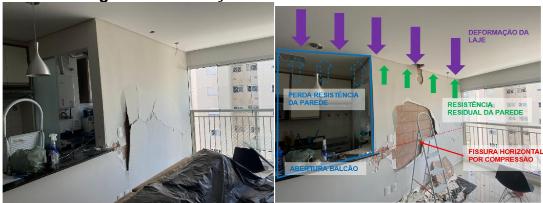
Figura 5 – Ilustração das anomalias construtivas
