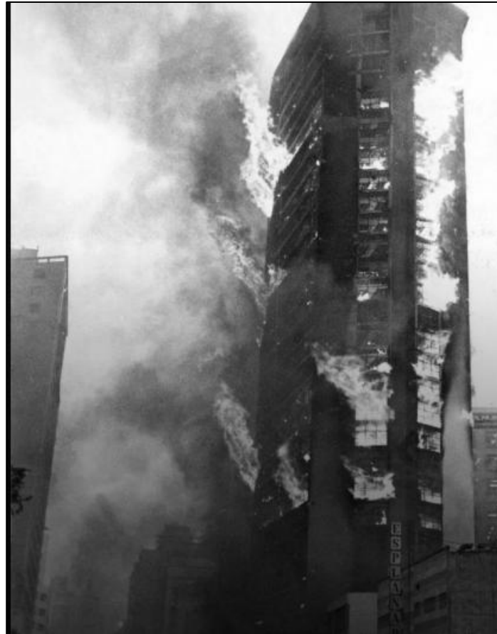
Figura 1: Imagem do Edifício Andraus em chamas, em 1972. Fonte: https://www.cnnbrasil.com.br/nacional/relembre-grandes-incendios-que-ja-ocorreram-no-centro-de-sao-paulo/embre-grandes-incendios-ocorridos-em-Sao-Paulo | CNN Brasil
