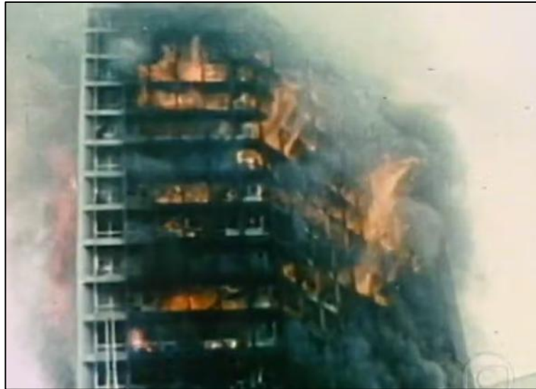
Figura 2: Imagem do Edifício Joelma em chamas, em 1974. Fonte: Edifício Joelma: relembre tragédia que há 50 anos deixava 187 mortos e centenas de feridos em incêndio | São Paulo | G1
