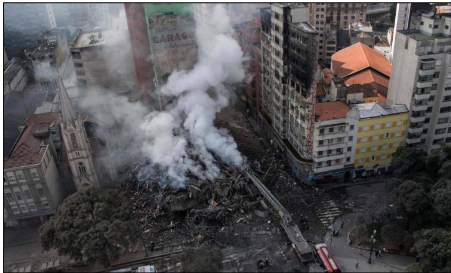
Figura 15: Desabamento em São Paulo. Fonte: https://oglobo.globo.com/politica/igreja-oferece-tres-locais-para-desabrigados-de-predio-que-desabou-apos-incendio-22642979
