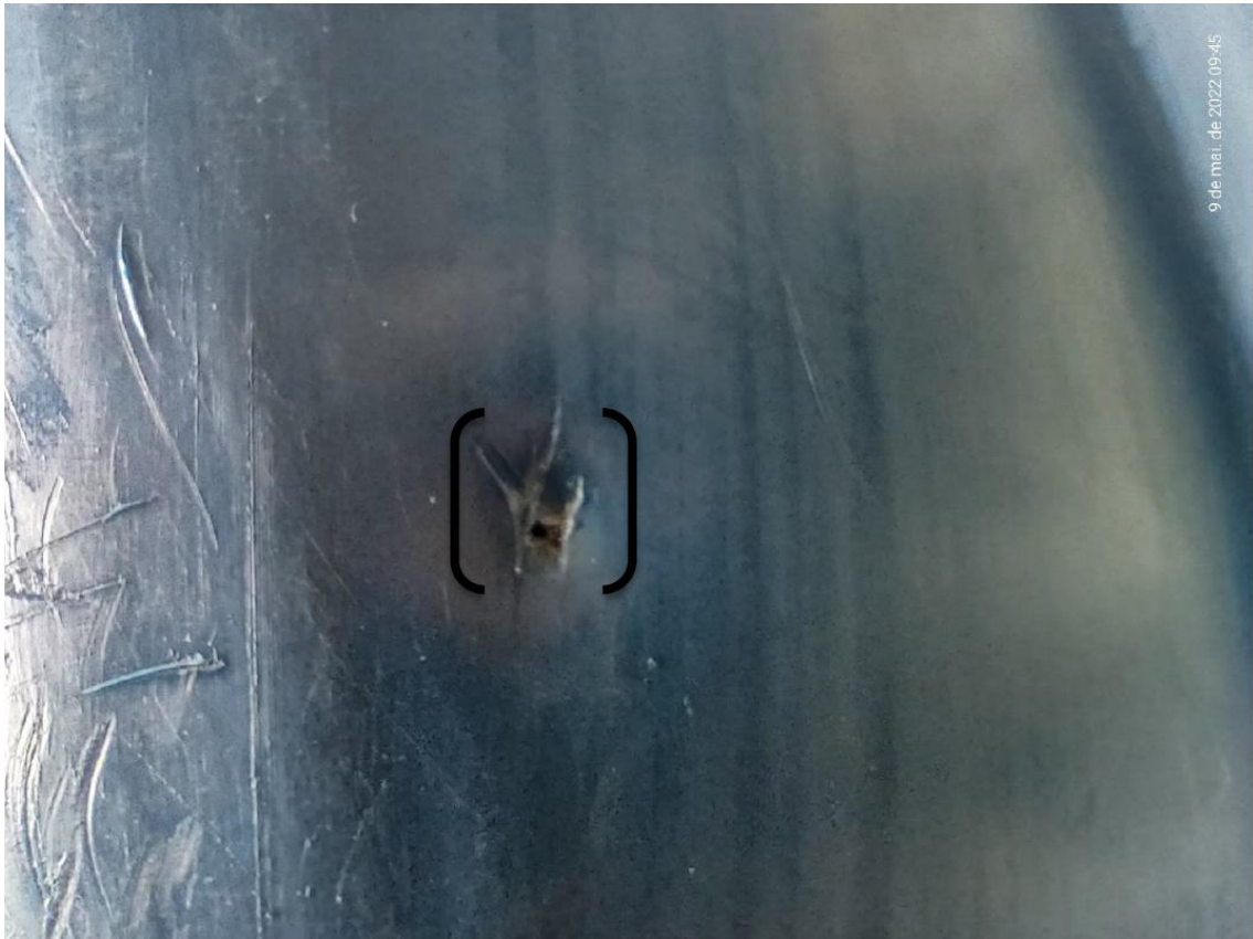
Figura 13 – Ponto de escoamento da água.
