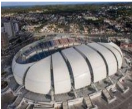
Figura 8: Fotografia externa da Arena das Dunas
