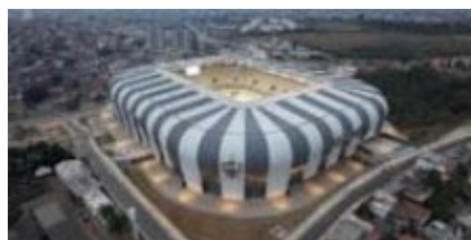
Figura 13: Fotografia externa da Arena MRV
