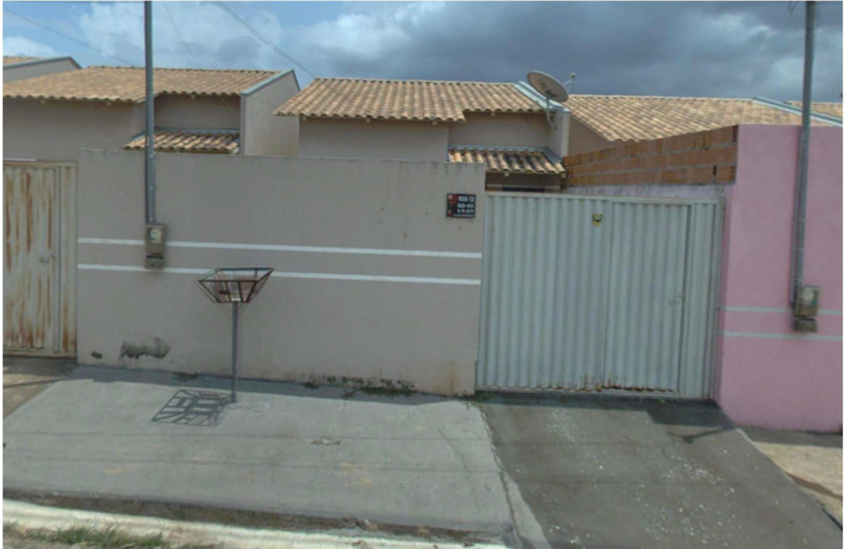
Figura 9: Exemplo de tipologia de edificação afetada (autoria própria).
