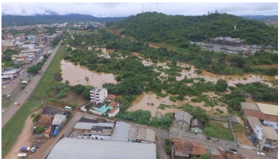
Figura 24: Área do Complexo Turístico, antes das obras do Programa (2019) (autoria própria).
