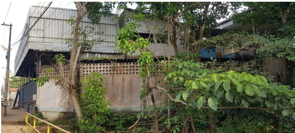
Figura 15: Divisa de fundo da edificação afetada (autoria própria).
