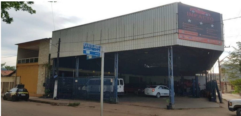
Figura 13: Edificações residencial e comercial afetadas (autoría própria).
