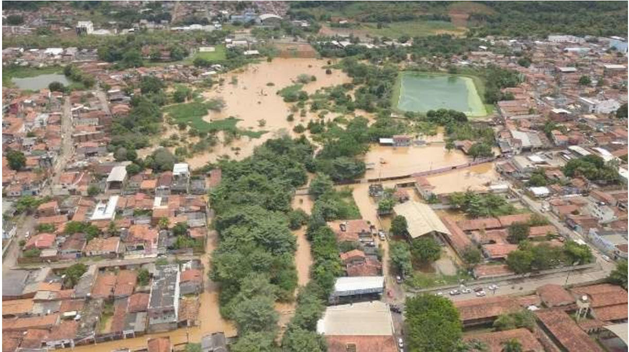
Figura 26: Área do canal do igarapé, antes das obras do Programa (2019) (autoria própria).
