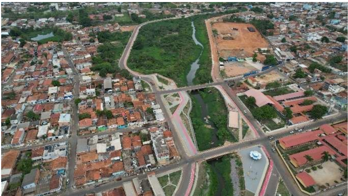
Figura 27: Área do canal do igarapé, depois das obras do Programa (2024) (autoria própria).
