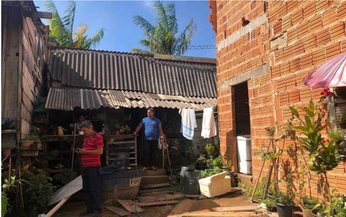
Figura 10: Exemplo de tipologia de edificação afetada (autoria própria).
