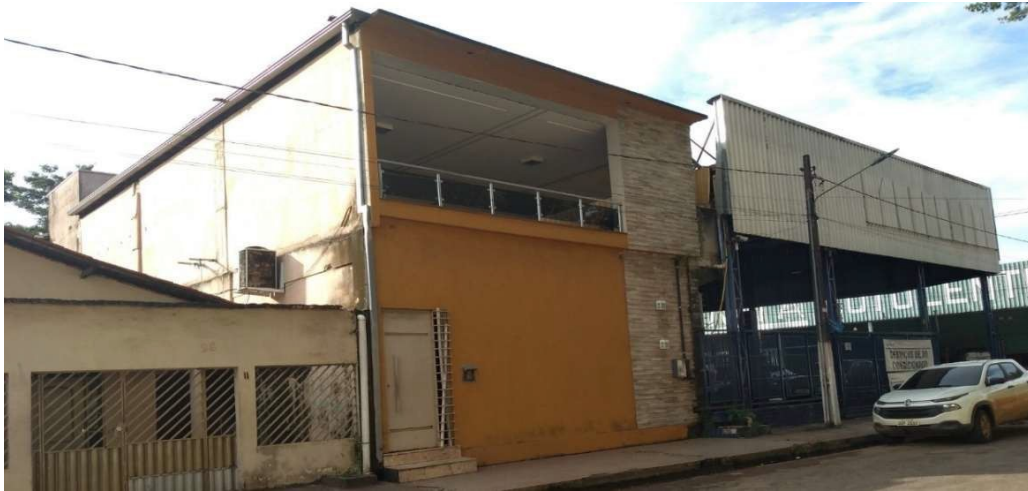
Figura 14: Divisa lateral da edificação afetada (autoria própria).
