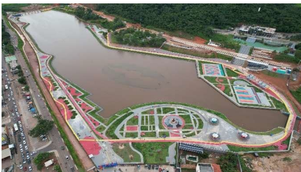
Figura 25: Área do Complexo Turístico, depois das obras do Programa (2024) (autoria própria).
