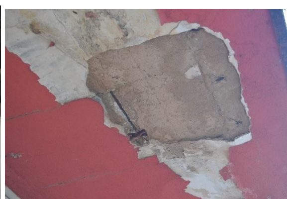
Foto 18 e 19: Ferragem exposta.
