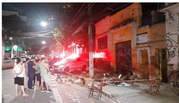
Foto 5: Marquise colapsada em São Paulo Fonte: g1.globo.com
