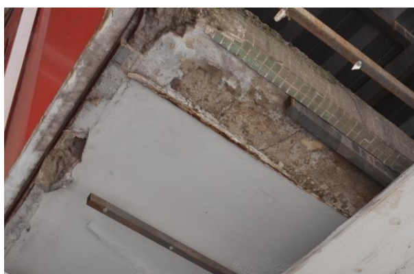
Foto 18 e 19: Ferragem exposta.
