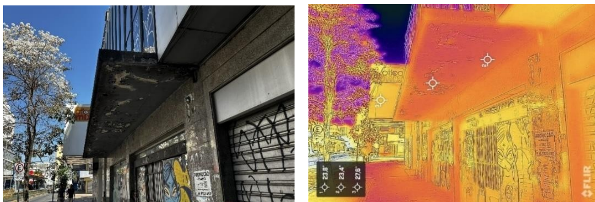
Foto 14 e 15: Marquise com pontos de umidade evidenciada nas imagens termográficas onde apresenta pontos de maior e menor temperatura
