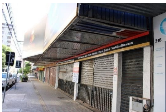
Foto 23 e 24 : Acabamentos “camuflando” a situação de degradação das marquises
