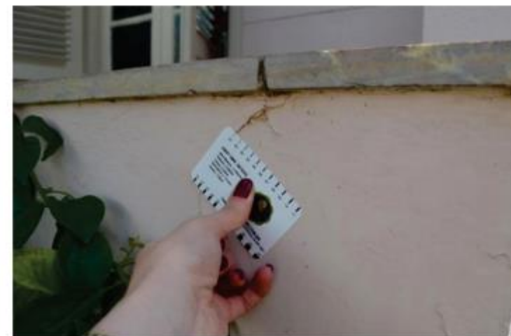
Figura 3: Constatação da espessura
