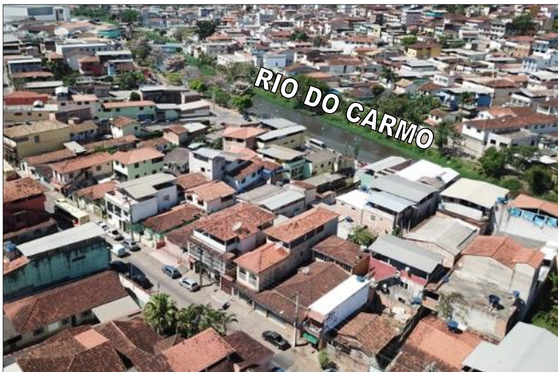
Figura 23– Região onde se encontra a edificação vistoriada e aos fundos o Rio do Carmo
