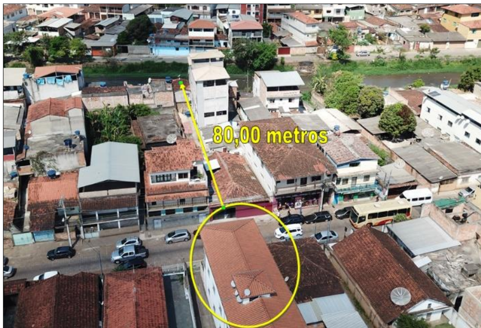
Figura 24 – Edifício vistoriado e nos fundos o Rio do Carmo.
