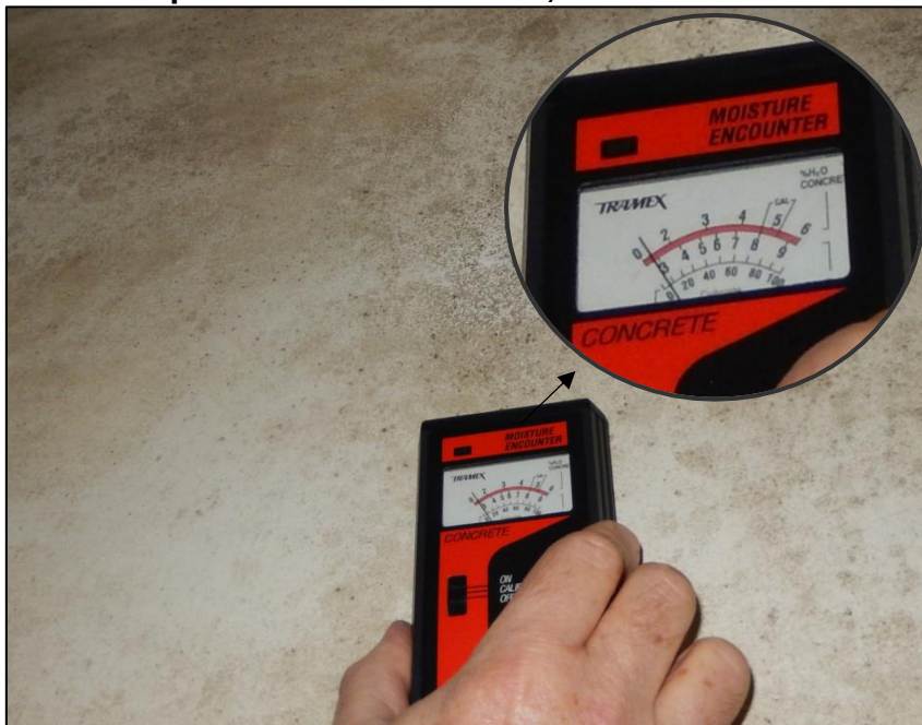
Figura 12: Índice quase nulo de umidade, indicando inexistir infiltrações
