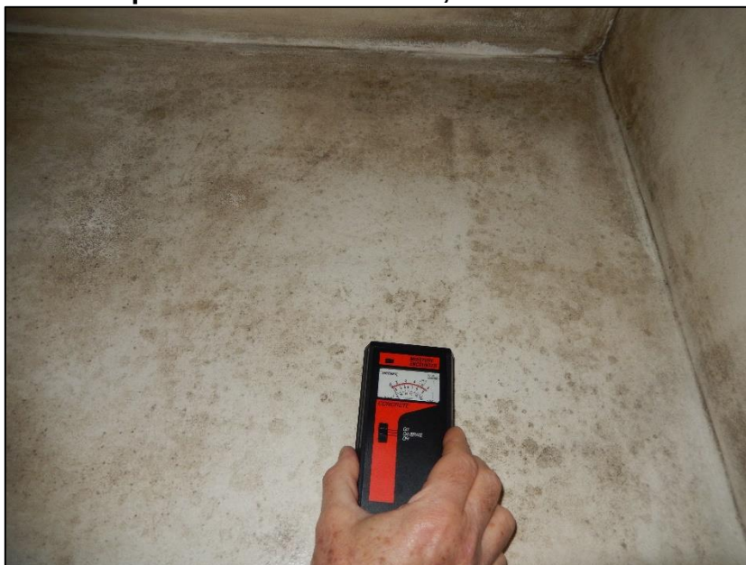
Figura 13: Índice quase nulo de umidade, indicando inexistir infiltrações
