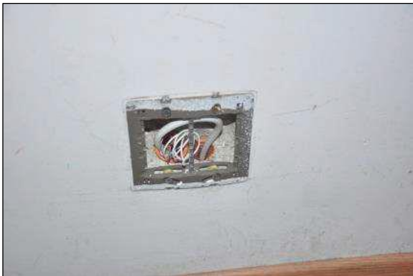
Figura 32: Inspeção no interior da tomada da parede com manchas, não sendo detectado nenhuma umidade interna.
