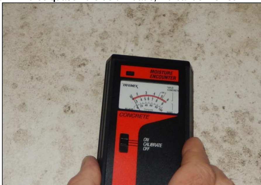
Figura 14: Índice quase nulo de umidade, indicando inexistir infiltrações
