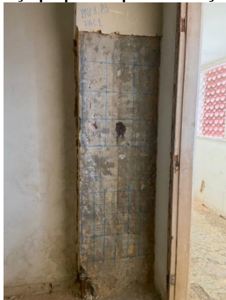
Figura 5 – Peça preparada para execução dos ENDS
