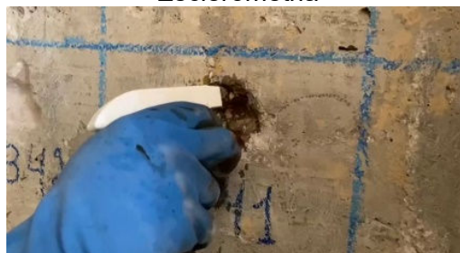
Profundidade de penetração de íons cloretos
