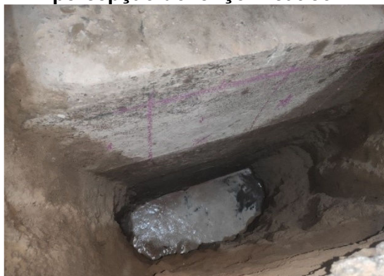
Figura 10 – Bloco de fundação, com percepção do lençol freático
