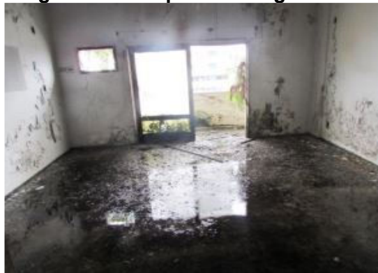
Figura 35 – Esquadrias degradadas
