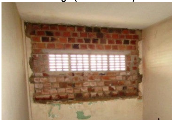
Figura 33 – Detalhe das esquadrias retiradas e substituídas por alvenaria e cobogó (fachada leste)
