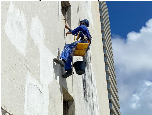
Figura 24 - Realização do ensaio de percussão nas fachadas
