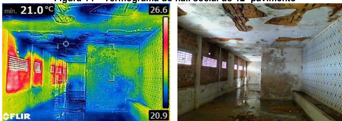
Figura 14 – Termograma do hall social do 12º pavimento
