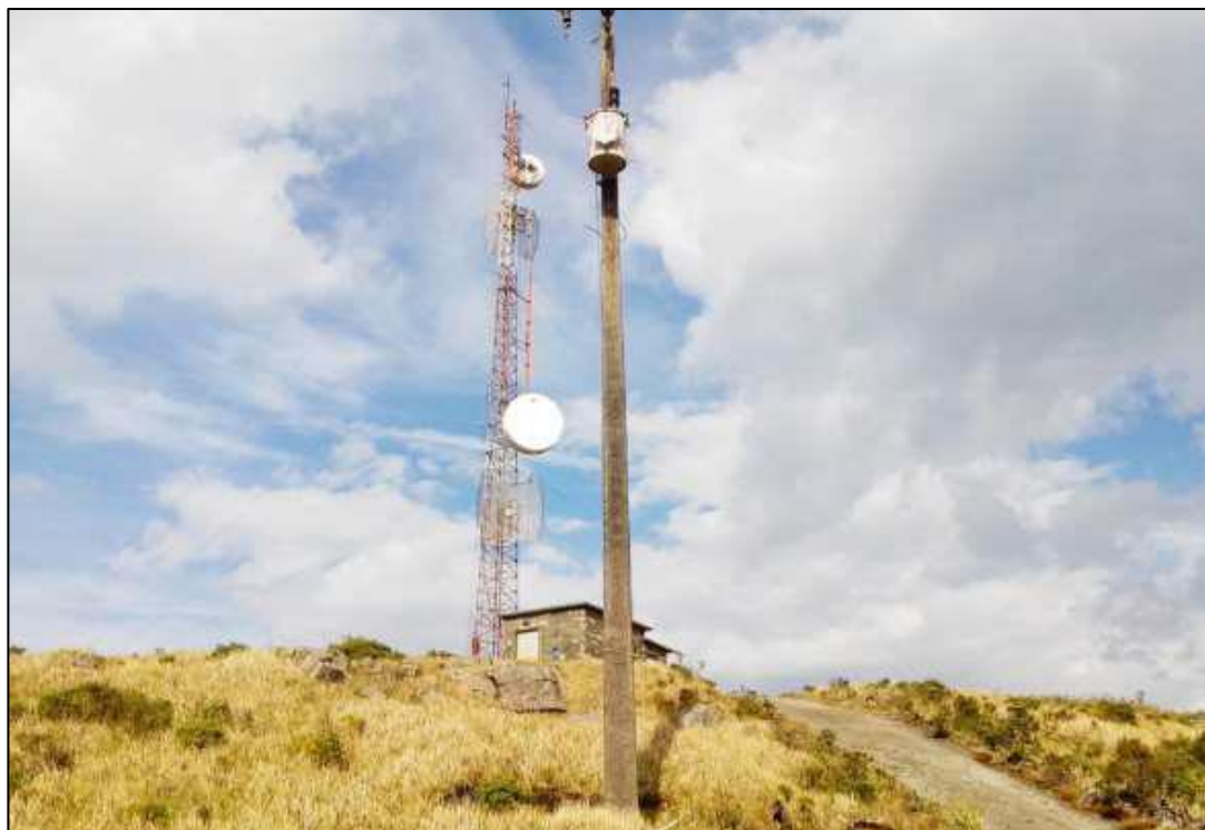
Figura 2 – Vista da antena e de pequena edificação de apoio.
