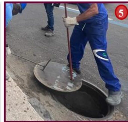
BUEIRO DA RUA SENDO ABERTO
