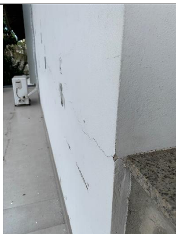
Figura 7 – Laje exposta. Vista parcial da parede com fissuração intensa
