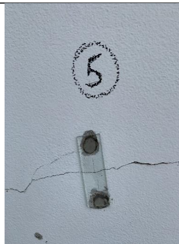
Figura 12 – Implantação de selos em vidro, para verificação do nível de atividade das fissuras
