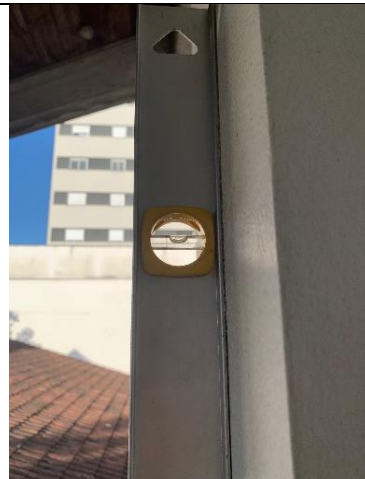
Figura 28 – Detalhe da figura anterior. Observar prumo satisfatório
