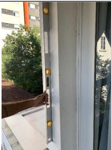
Figura 27 – Verificação de prumo, ao final do peitoril da sacada frontal
