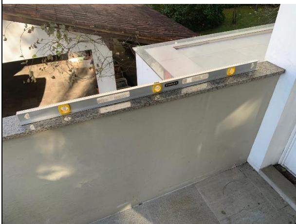
Figura 23 – Notar placa de granito solta, no peitoril da sacada frontal
