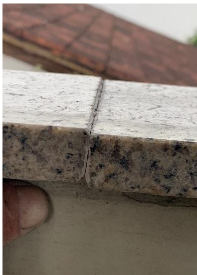
Figura 23 – Notar placa de granito solta, no peitoril da sacada frontal
