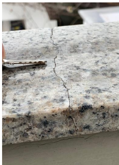
Figura 24 – Notar placa de granito fissurada, no peitoril da sacada frontal
