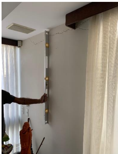
Figura 31 – Verificação de nível, na viga da laje exposta, nas proximidades do pilar P20
