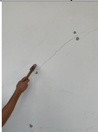
Figura 4 – Sacada frontal. Uso de detector magnético para analisar fissura presente, quanto à existência de interferências (ferragens ou instalação elétrica)
