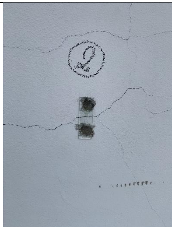
Figura 11 – Implantação de selos em vidro, para verificação do nível de atividade das fissuras
