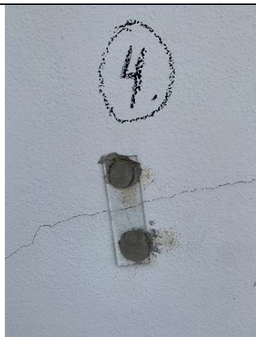
Figura 11 – Implantação de selos em vidro, para verificação do nível de atividade das fissuras
