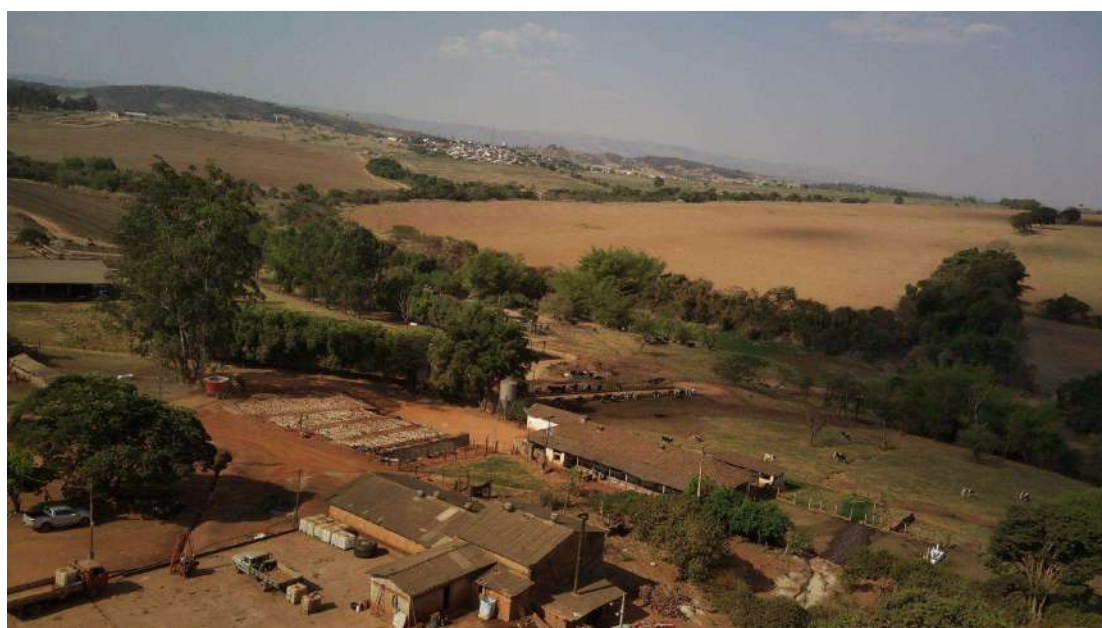
Figura 4: Vista aérea das benfeitorias presentes no imóvel sede. Fonte: Dados de campo (2021).
