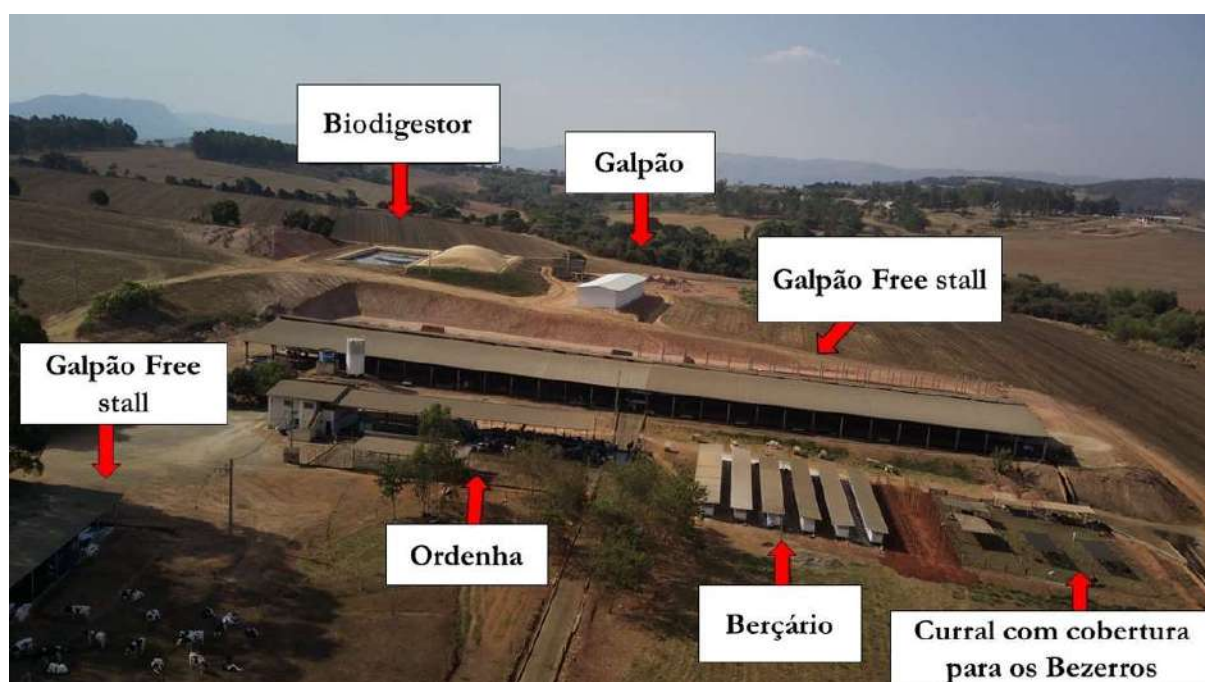
Figura 8: Vista das benfeitorias presentes no imóvel sede. Fonte: Dados de campo (2021).
