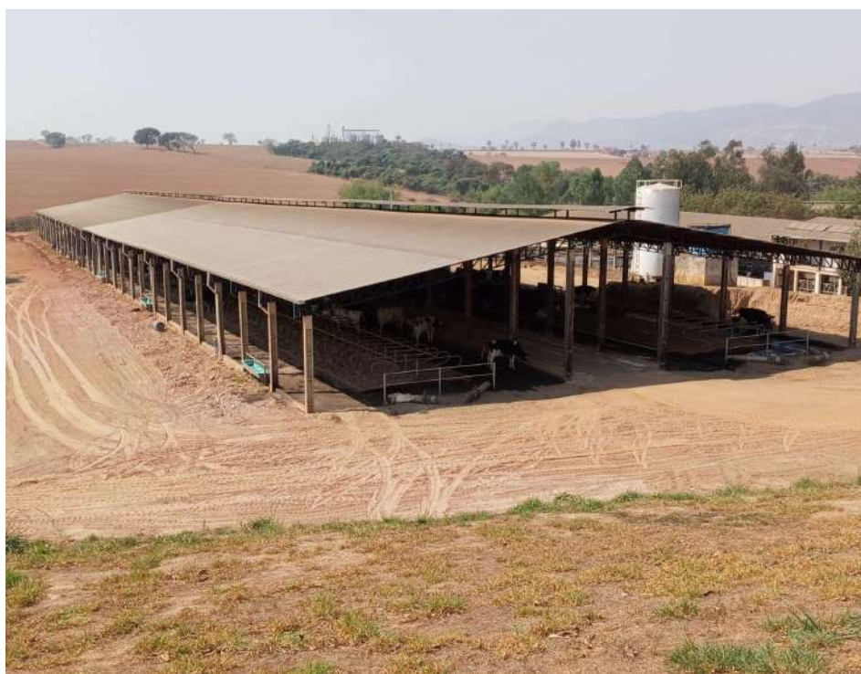
Figura 13: Galpão climatizado do sistema produtivo leiteiro. Fonte: Dados de campo (2021).
