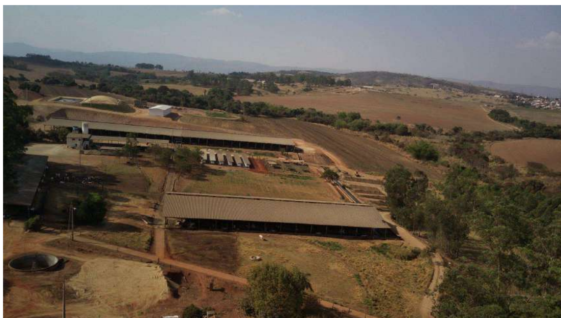
Figura 7: Vista aérea das benfeitorias presentes no imóvel sede. Fonte: Dados de campo (2021).
