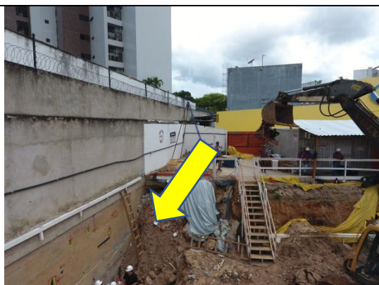
Foto: C4-009 Teste SPT no talvegue.
