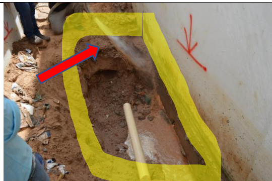
Foto: C4-022 Para comprovação do vaso comunicante fora utilizado água do hidrante.
