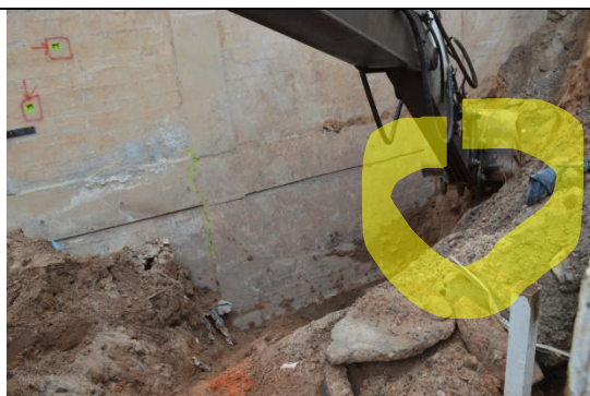
Foto: C4-017 Escavação para encontro do ponto de fuga (comprovação do processo técnico).
