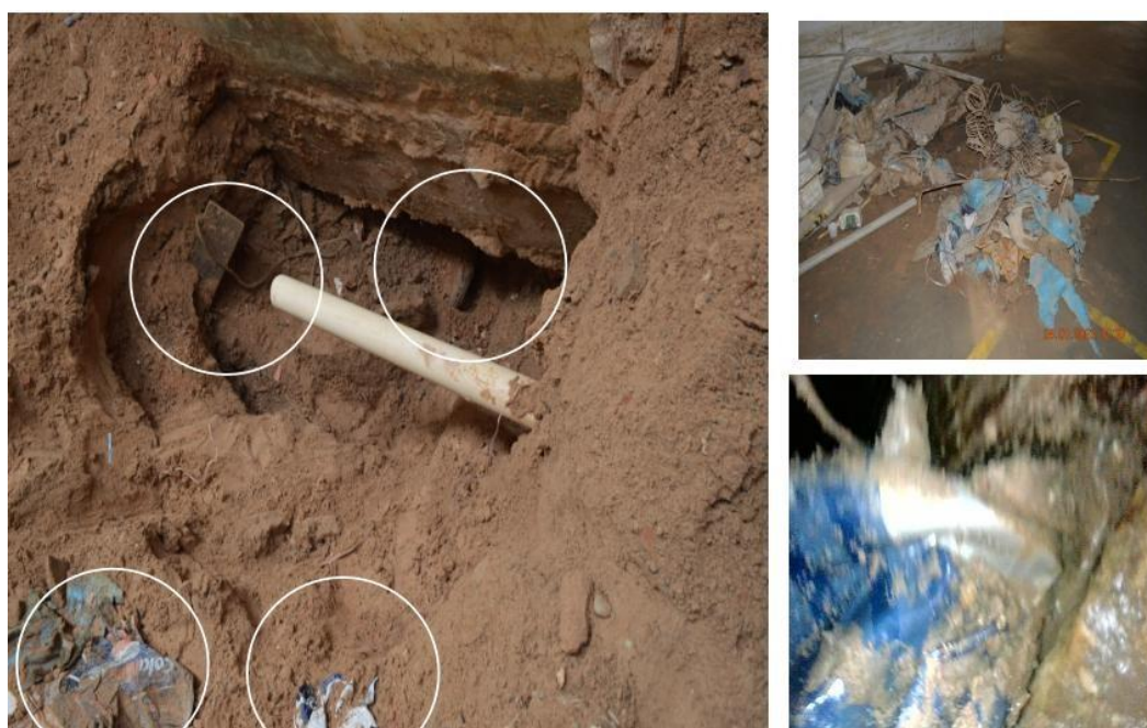
Figura 13 – Comprovação da disposição de resíduos sólidos no aterro do condomínio Beta
