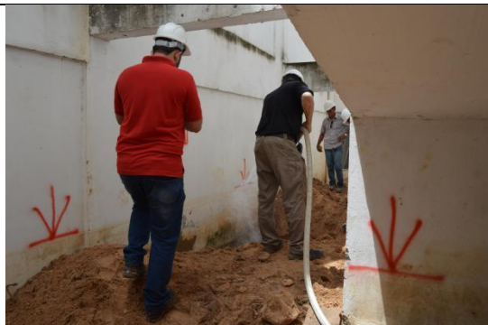
Foto: C4-021 Comprovação do vaso comunicante na parte interna do subsolo2 – dentro do cond. Beta (área de drenagem)
