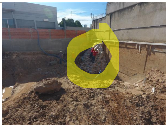
Foto: C4-006 Foram feitas contenções para evitar novos danos, no ponto de encontro das obras.
