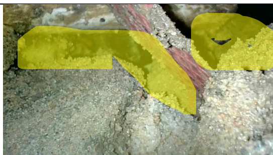
Foto: C4-015 Sondagem dos vazios com comprovação de substrato arenoso, amarelo.
