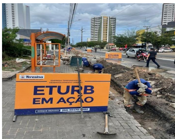
Figura 8 – Obra em andamento, realizada pela prefeitura de Teresina
