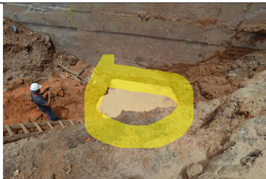
Foto: C4-026 Vaso comunicante comprovado (lado da obra Alpha). Simulação ocorreu com êxito e um microcenário da comprovação funcional da prova cabal foi concluída com satisfação técnica.
