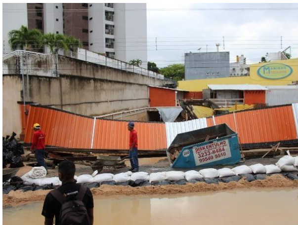
Figura 9 – Alagamento na região do sinistro
