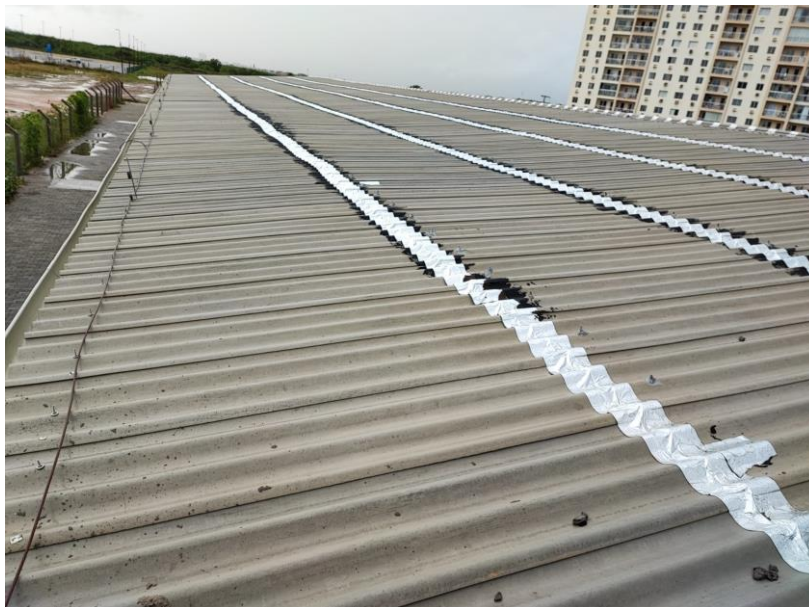
Foto 2: Vista geral do telhado instalado
