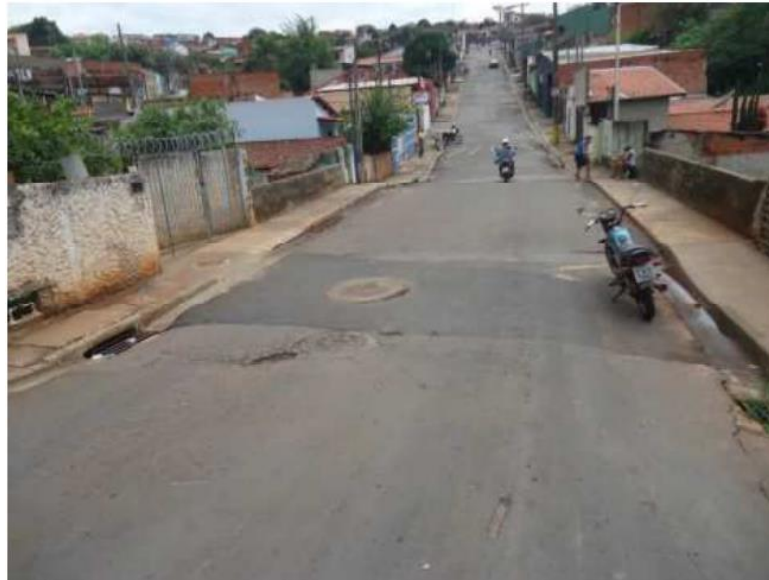
Fotografia 2 – Rua em frente do imóvel.
