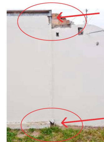
Foto 9 – Condutor de águas pluviais em desacordo com o Código Civil. Fonte: autor.
