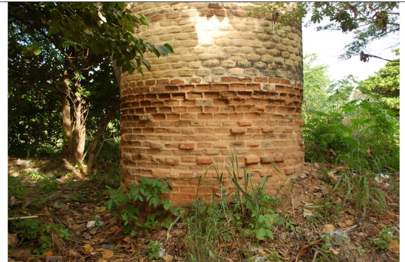
Foto: PV005 - Vista da base atual da chaminé.
