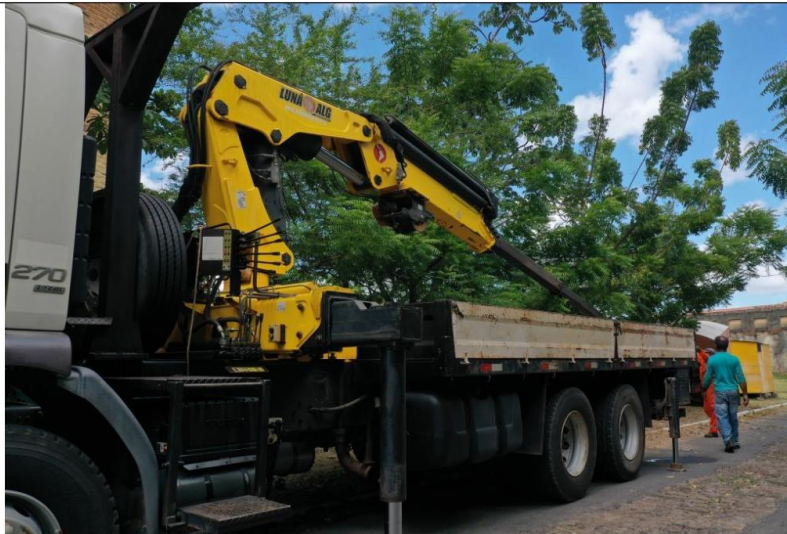
Foto: PV006 - Vista equipamento hidráulico caminhão munck com 5 lanças
