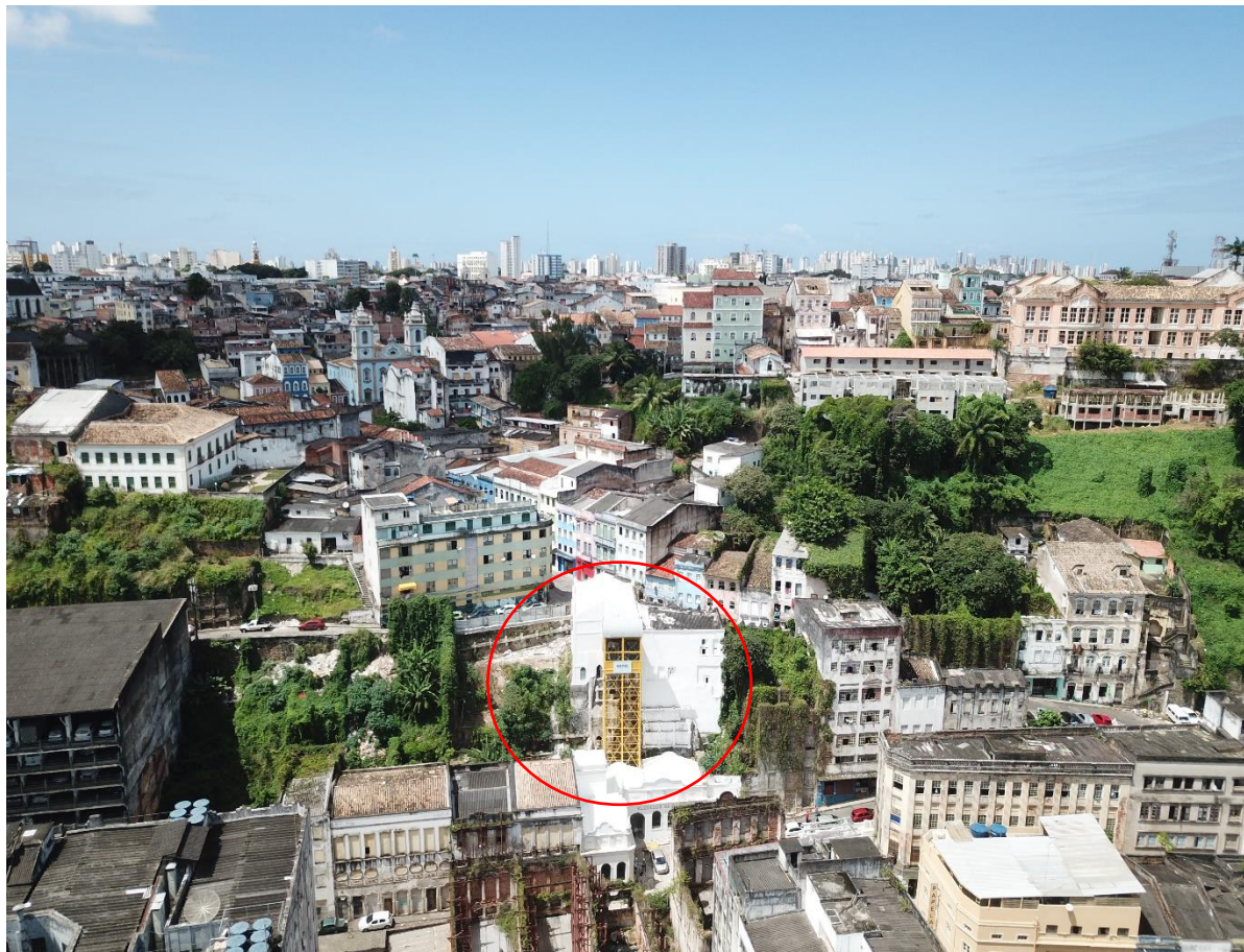
Figura 10 – Vista aérea do sítio com os elevadores e edificações concluídos
