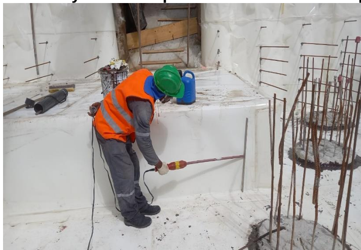
Figura 15 – Holiday detector aplicado sobre material impermeabilizante
