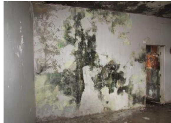
Registro da degradação originada pela infiltração
