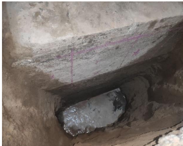
Bloco de fundação, com percepção do lençol freático
