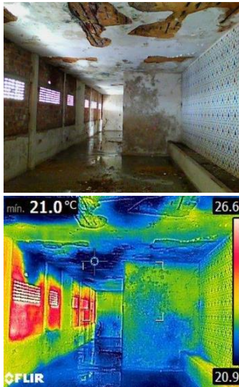
Termografia do 12º pavimento
