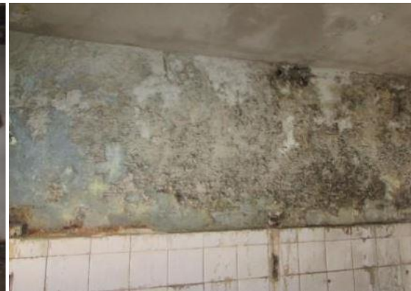
Registro da degradação originada pela infiltração
