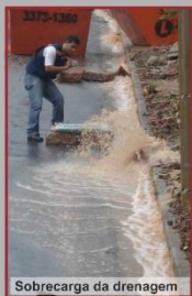
Sobrecarga da drenagem
