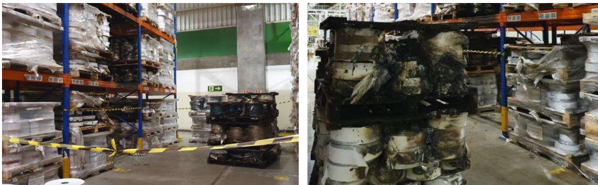
Local do sinistro de incêndio na área de expedição de embalagens
