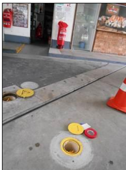
Figura 17: Abertura e instalação do Poço
