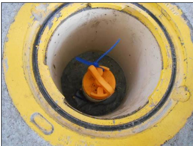
Figura 18: Colocação do lacre
