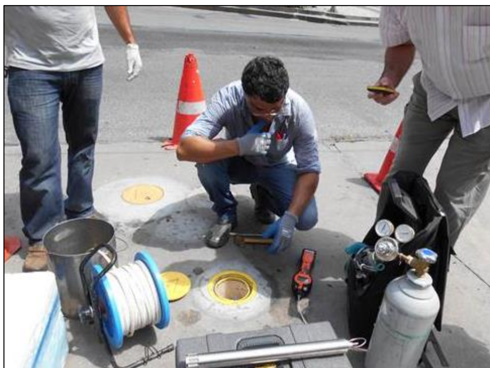
Figura 19: Testes sendo realizados
