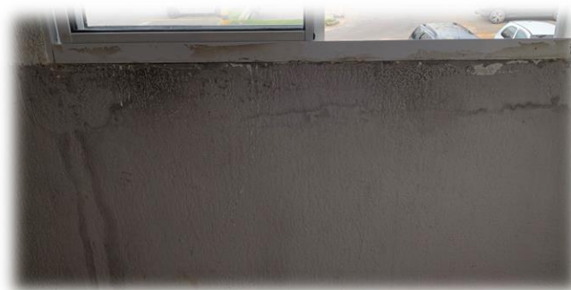
Sinais de umidade (infiltração)
