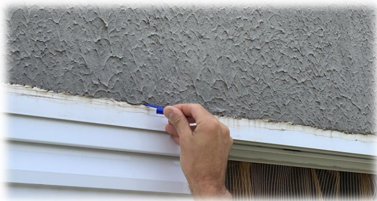
Sinais de umidade (infiltração)
