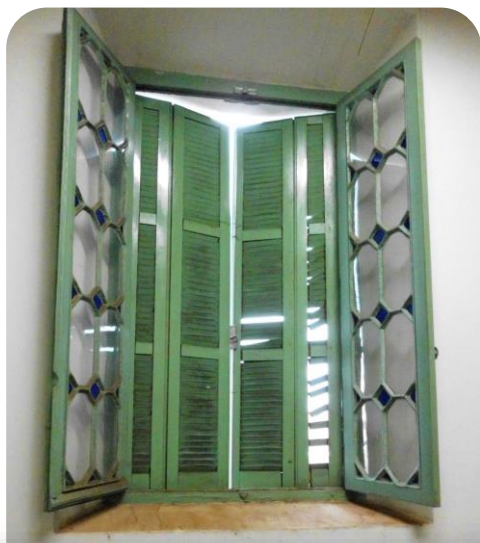
Acúmulo de sujeira no beiral interno
