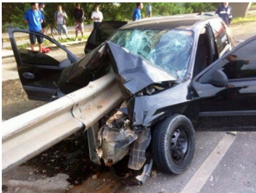
Imagem 13 – Acidente visto de frente, com ponta de defesa metálica, em não conformidade com o item 6.1 Terminais de dispositivos de contenção longitudinal da ABNT NBR 15486:2016.
