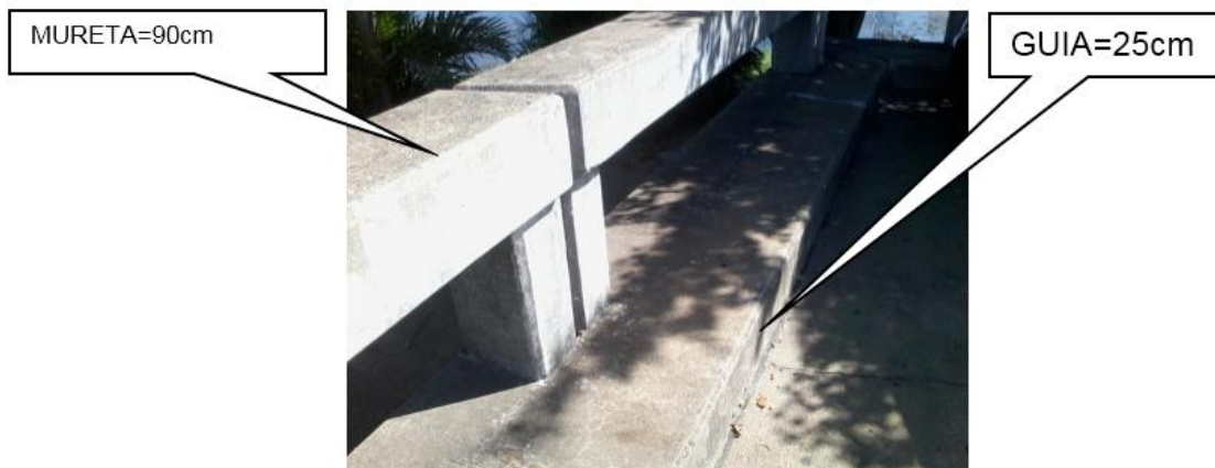
Imagem 09 – Detalhe de Mureta de proteção da ponte Rio Niterói.
