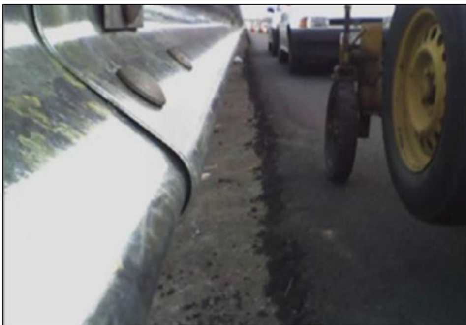
Imagem 10 – Defesa implantada a 25 cm do asfalto recapeado
