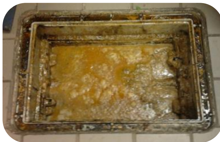
Caixa de gordura
