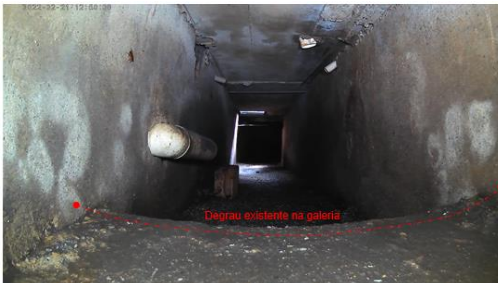
Figura 28 – Locação do degrau existente na galeria
