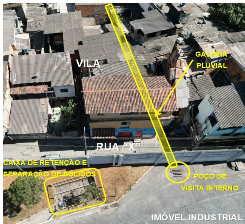
Figura 14 – Posição da galeria de drenagem pluvial vistoriada
