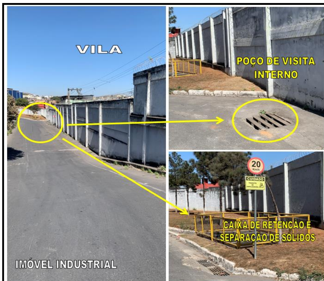
Figura 15 – Trecho inicial da galeria de drenagem pluvial vistoriada
