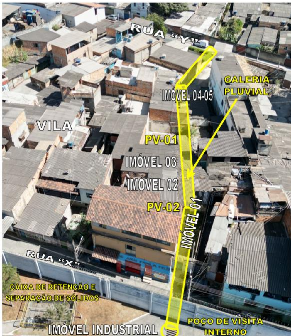
Figura 16 – Trecho inicial da galeria de drenagem pluvial vistoriada
