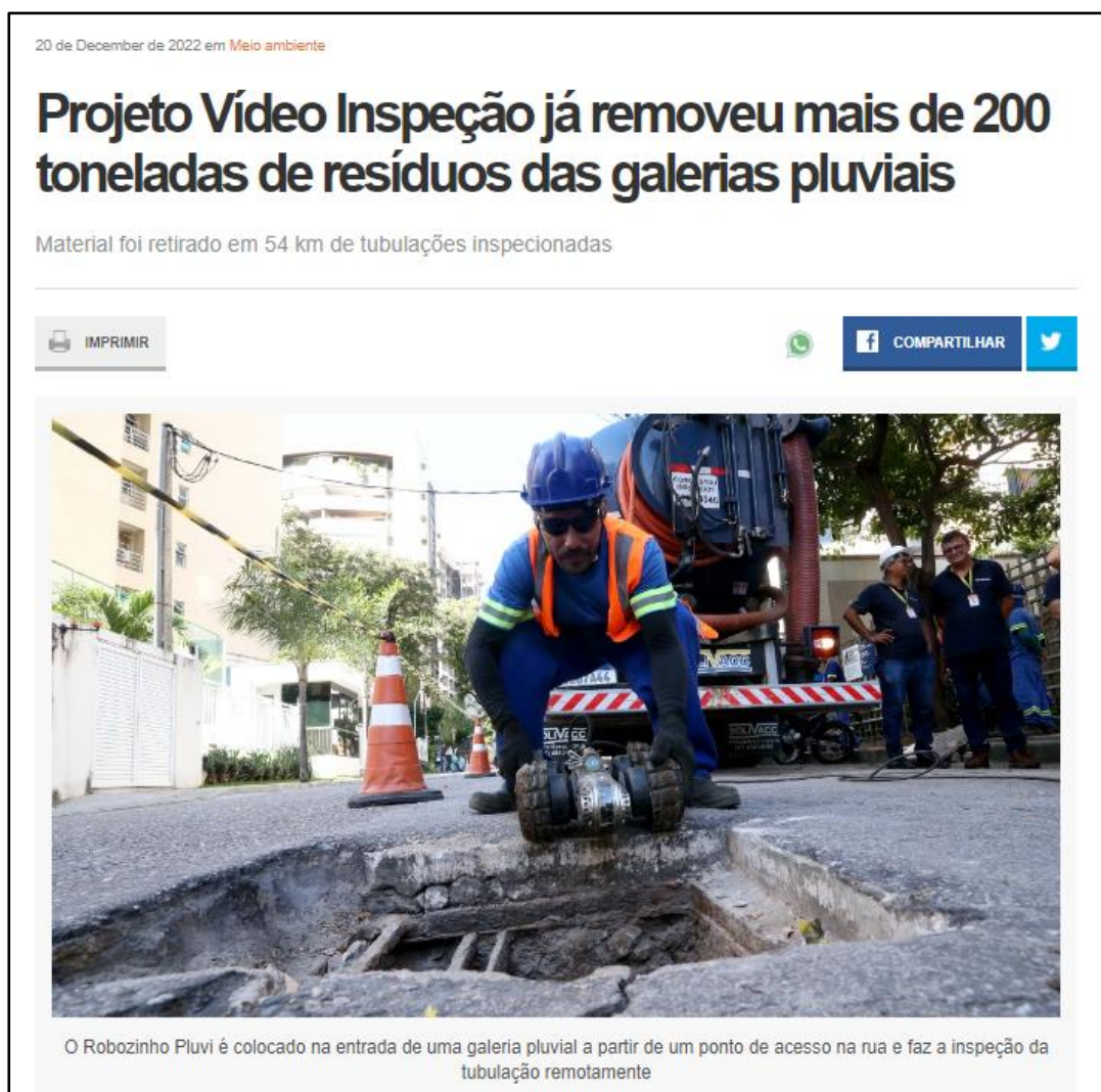
Figura 8 – Projeto Vídeo Inspeção com robôs no município de Fortaleza/CE.
