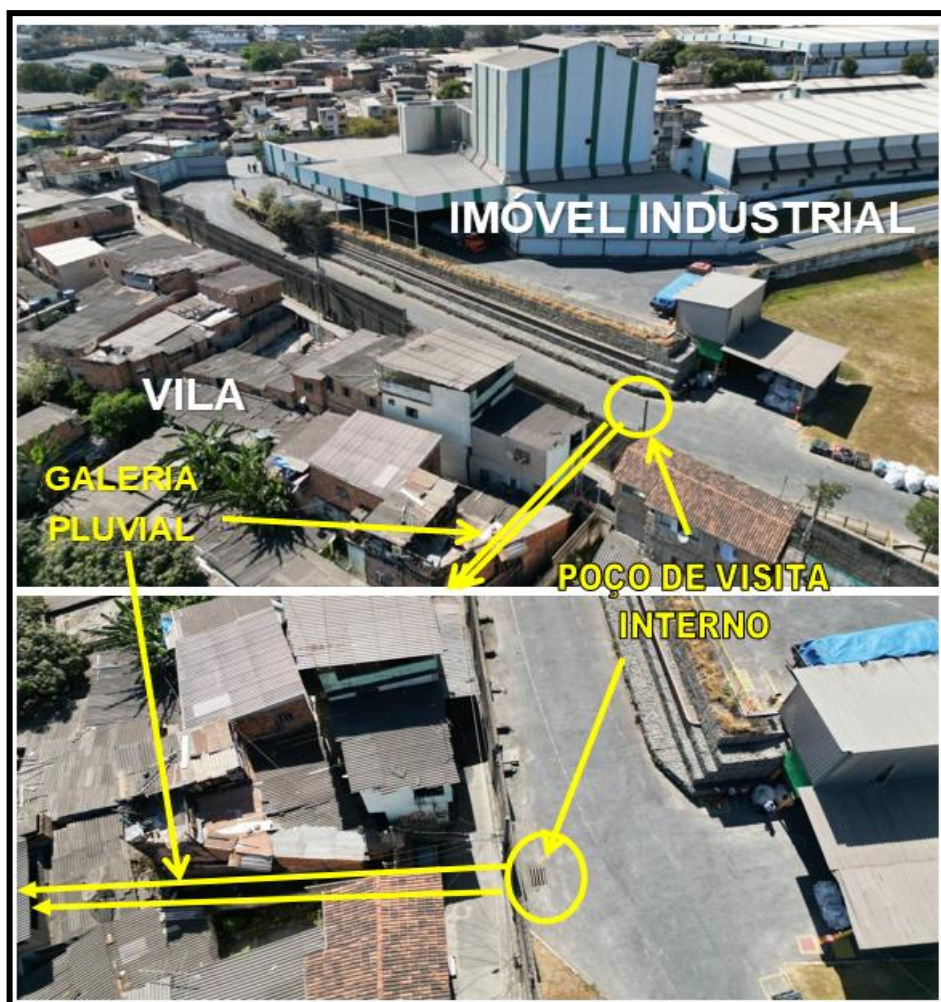
Figura 13 – Outra perspectiva do local de implantação da galeria pluvial
