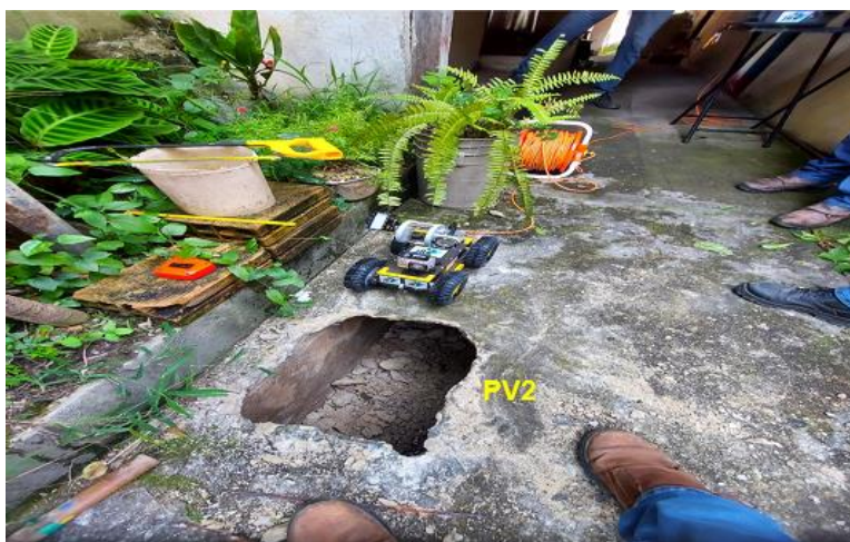
Figura 30 – Trecho inspecionado PV2: ponto de acesso
