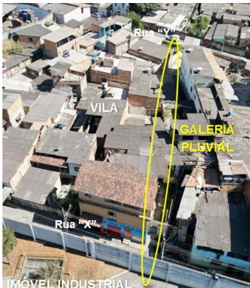
Figura 12 – Posição da galeria de drenagem pluvial vistoriada
