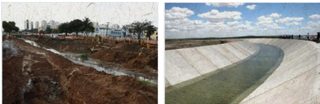
Figura 4 – Imagens da execução de um canal artificial
