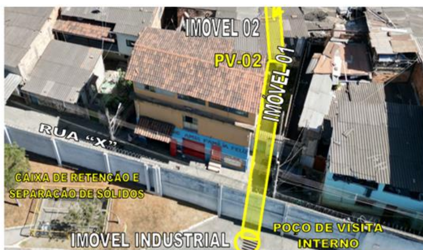
Figura 31 – Trecho inspecionado PV-02 até Poço de Visita Interno
