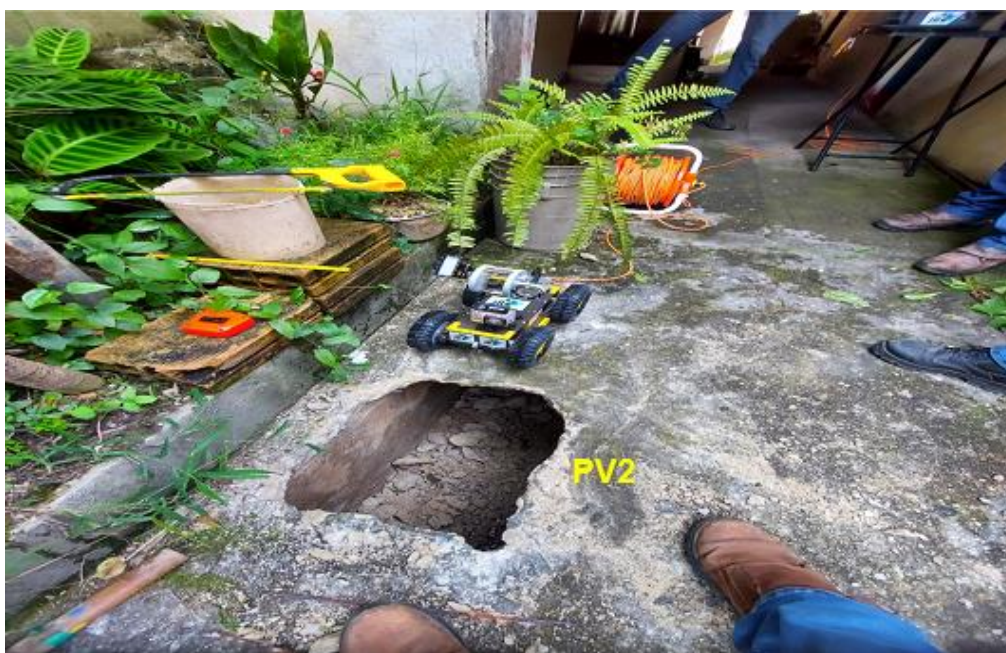
Figura 25 – Trecho inspecionado PV2: ponto de acesso
