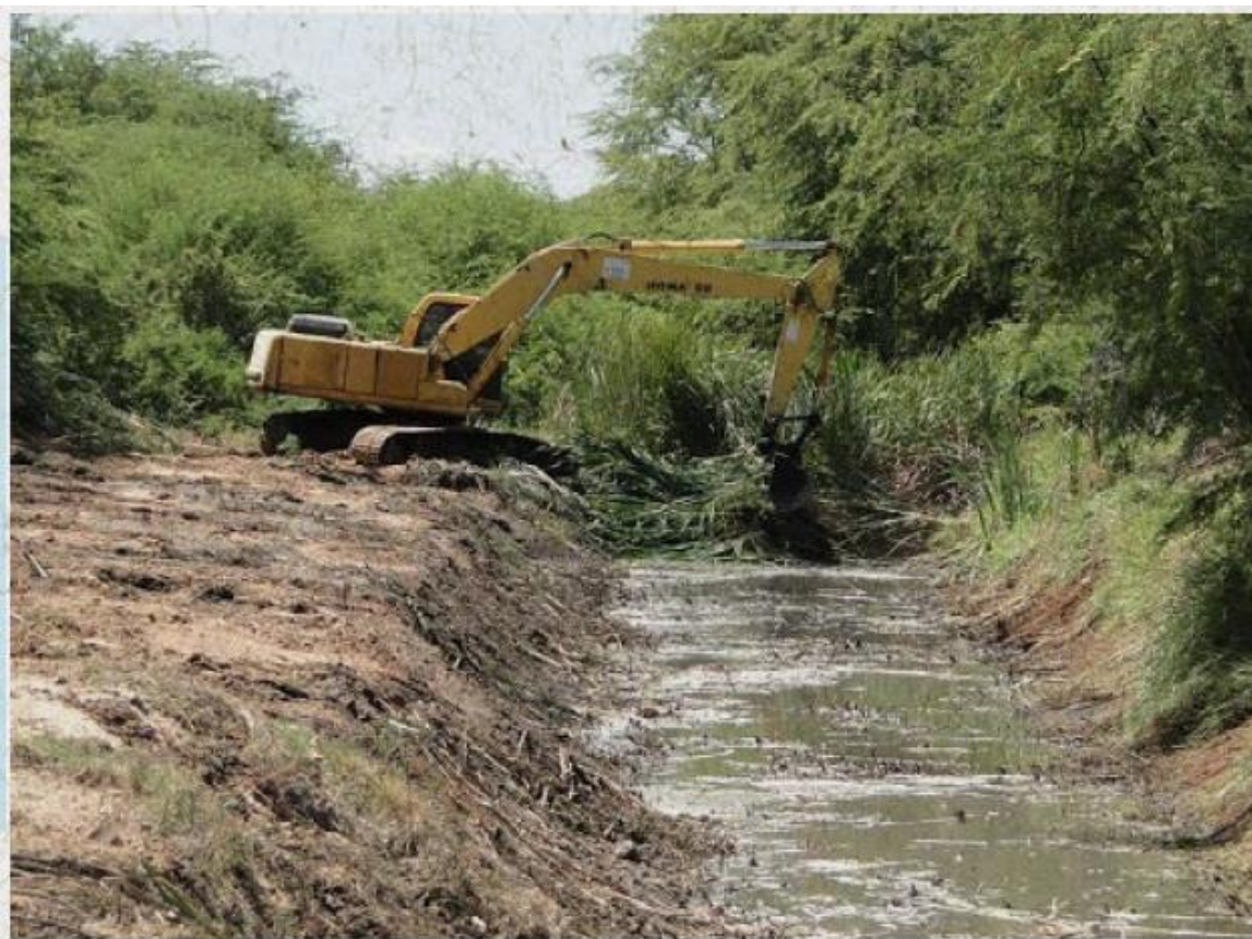
Figura 5 – Execução de obras para ampliação de um canal natural
