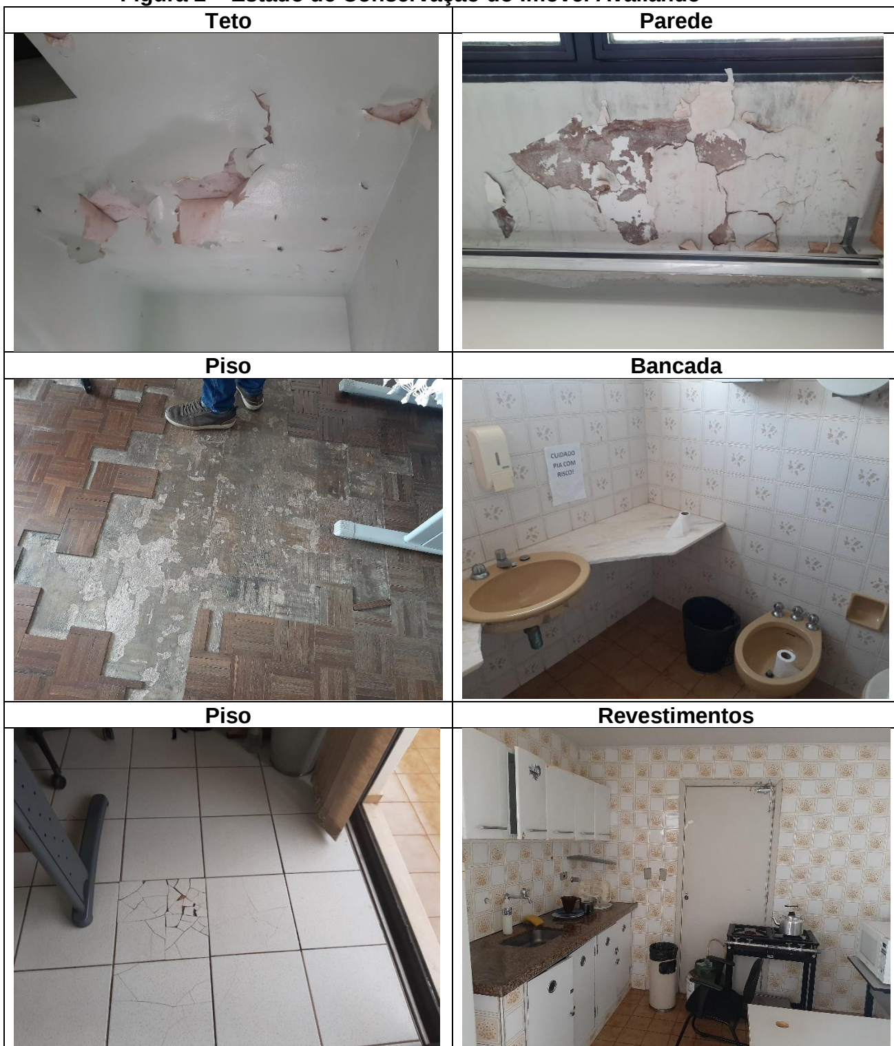
Figura 2 – Estado de Conservação do Imóvel Avaliando
