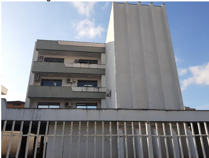
Figura 1 – Fachada Imóvel Avaliando
