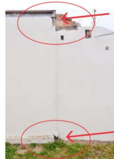
Foto 9 – Condutor de águas pluviais em desacordo com o Código Civil. Fonte: autor.
