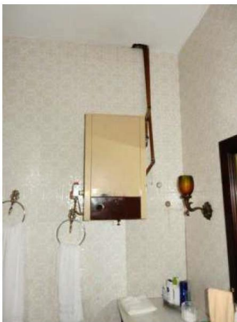
Foto 13 – Residência com aquecedor dentro de banheiro, com risco elevado aos usuários. Fonte: autor.
