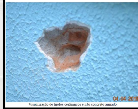
Visualização de tijolos cerâmicos e não concreto armado
