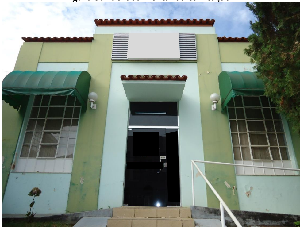
Figura 9: Fachada frontal da edificação
