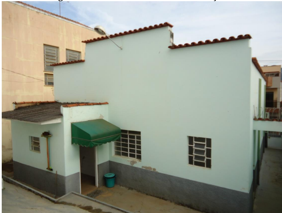
Figura 10: Fachada dos fundos da edificação
