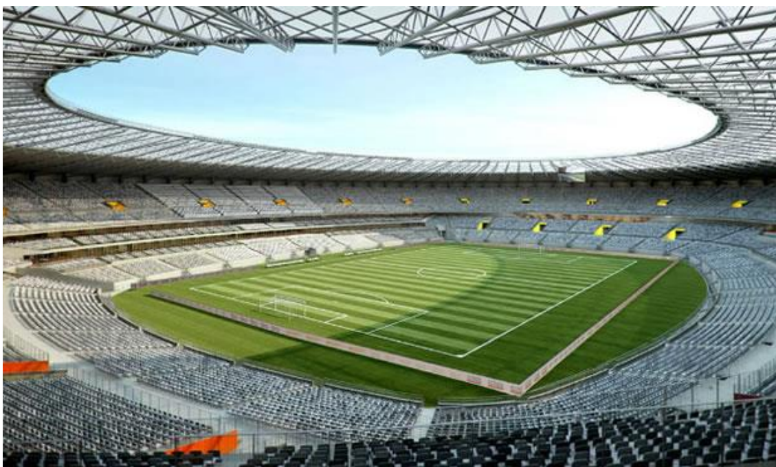
Figura 46: Fotografia interna do Estádio Mineirão
