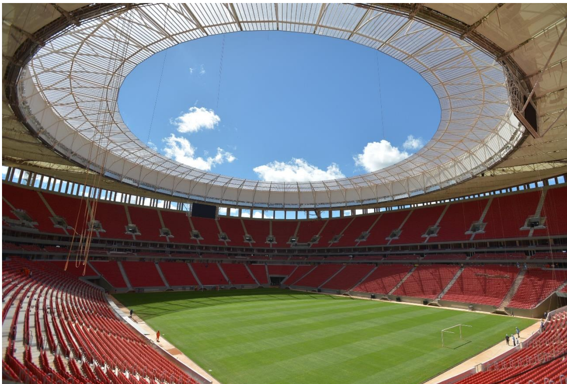
Figura 28: Fotografia interna do Estádio Mané Garrincha
