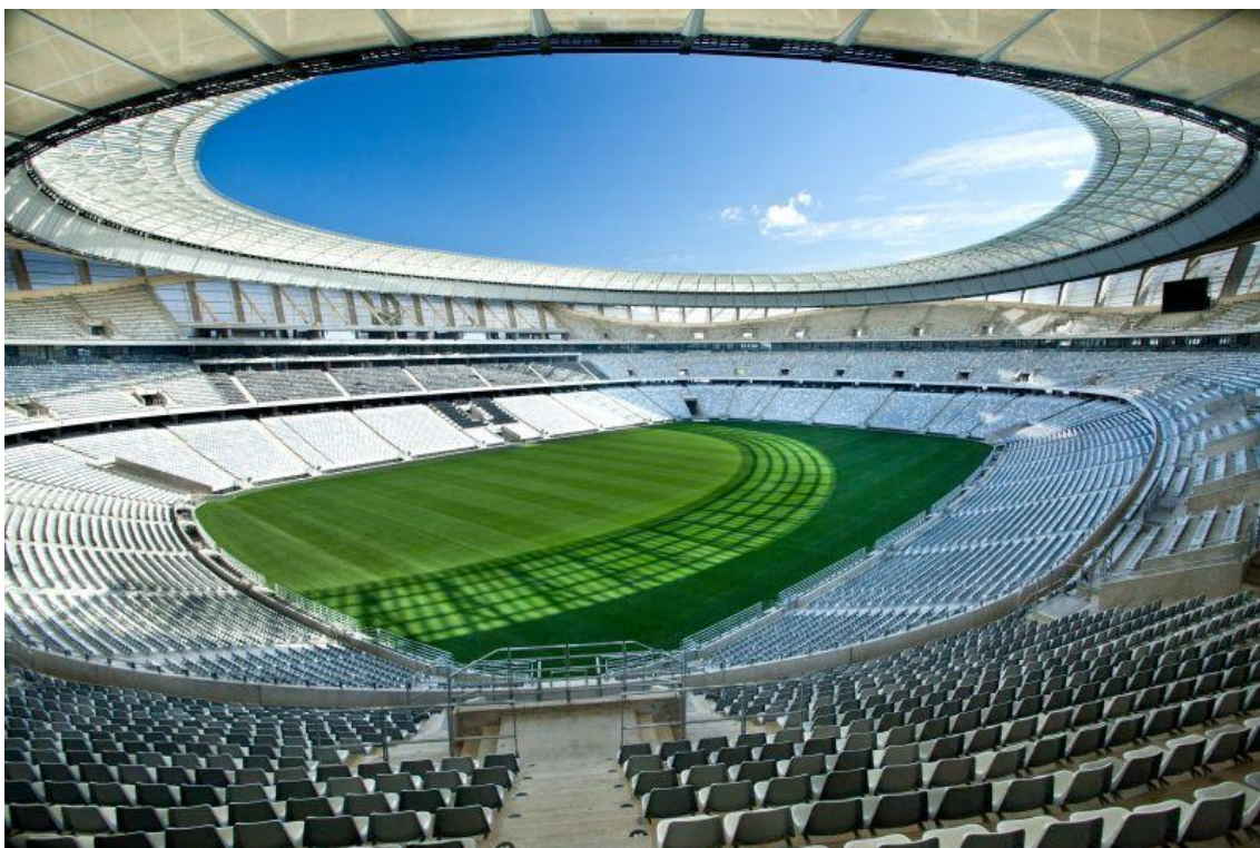
Figura 24: Fotografia interna do Cape Town Stadium
