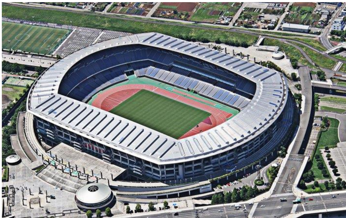
Figura 25: Fotografia externa do Nissan Stadium
