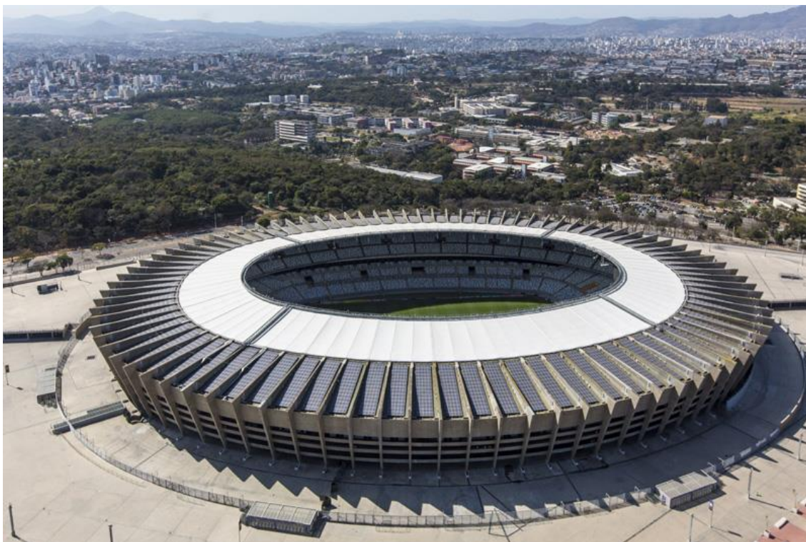
Figura 45: Fotografia externa do Estádio Mineirão
