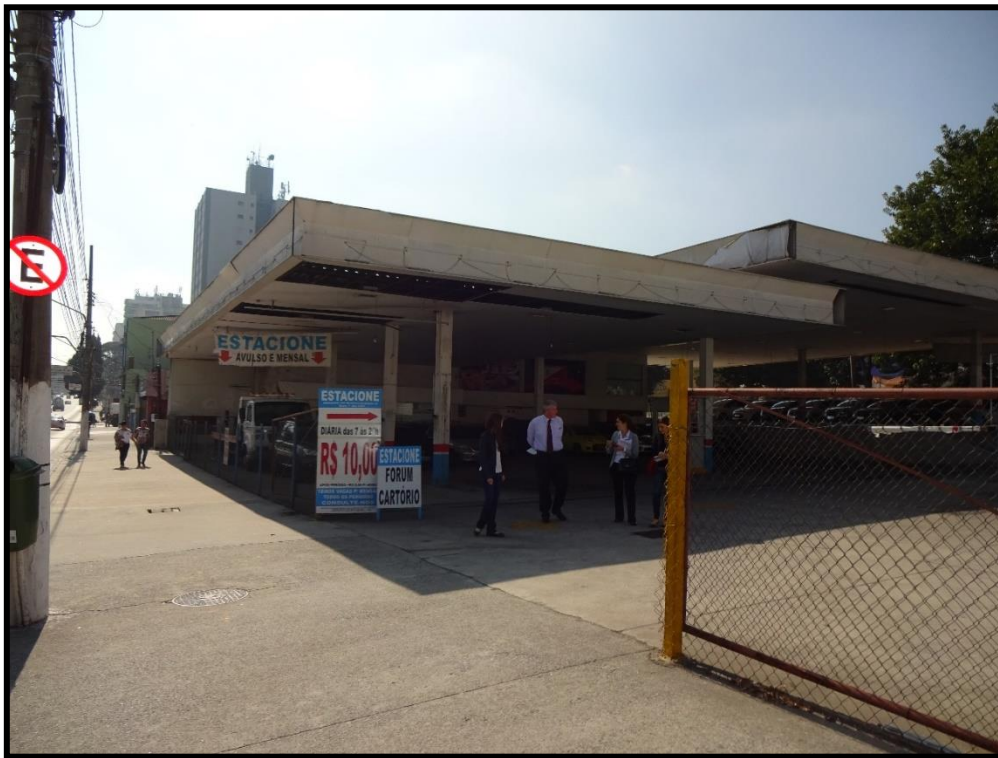
Foto 7: Imóvel – Vista da Av. Adolfo Pinheiro
