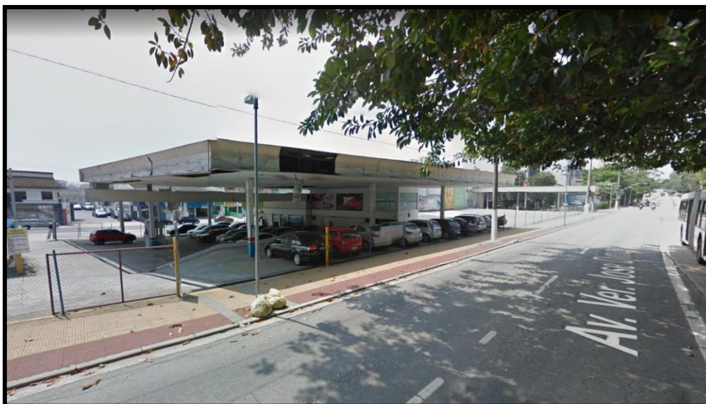
Foto 8: Imóvel – Vista da Av. Vereador José Diniz
