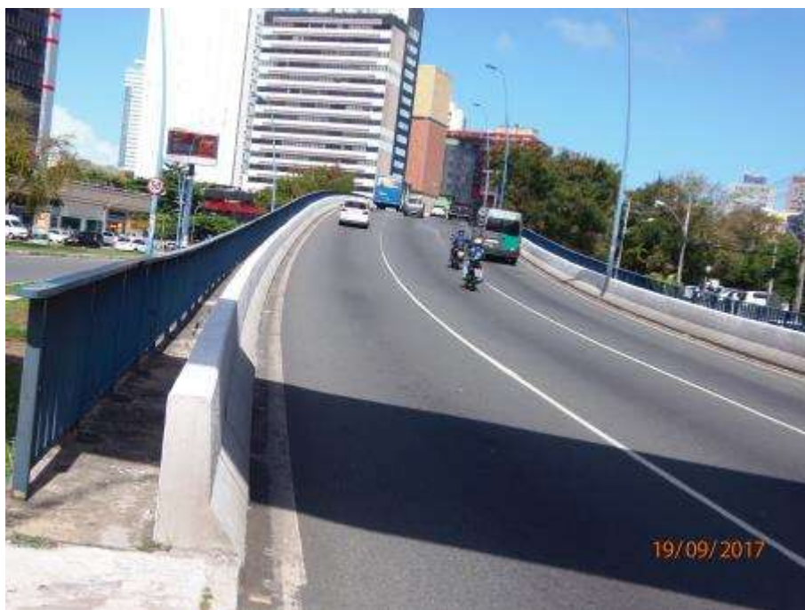
- Acesso ao viaduto a partir da Avenida Tancredo Neves.
