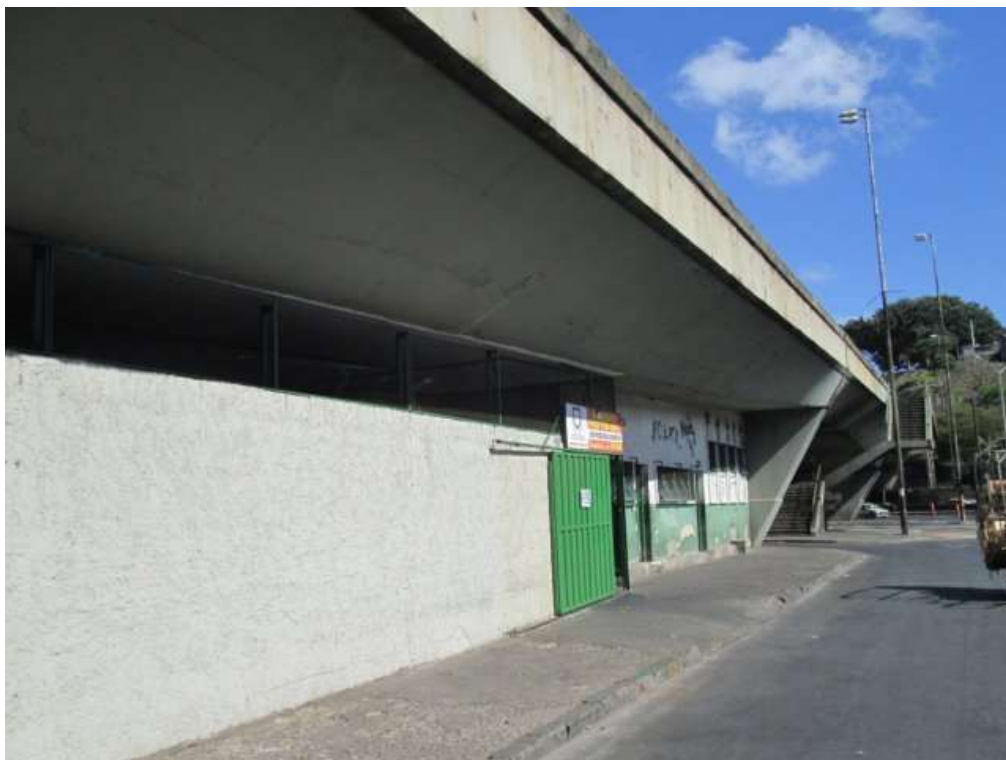
F31/HG – Vista da lateral do viaduto nas proximidades da Avenida Tereza Cristina. Baixo utilizado pelo Sindicato dos pipoqueiros da Grande BH. Ao fundo, vista da escada que dá acesso ao passeio de pedestres
