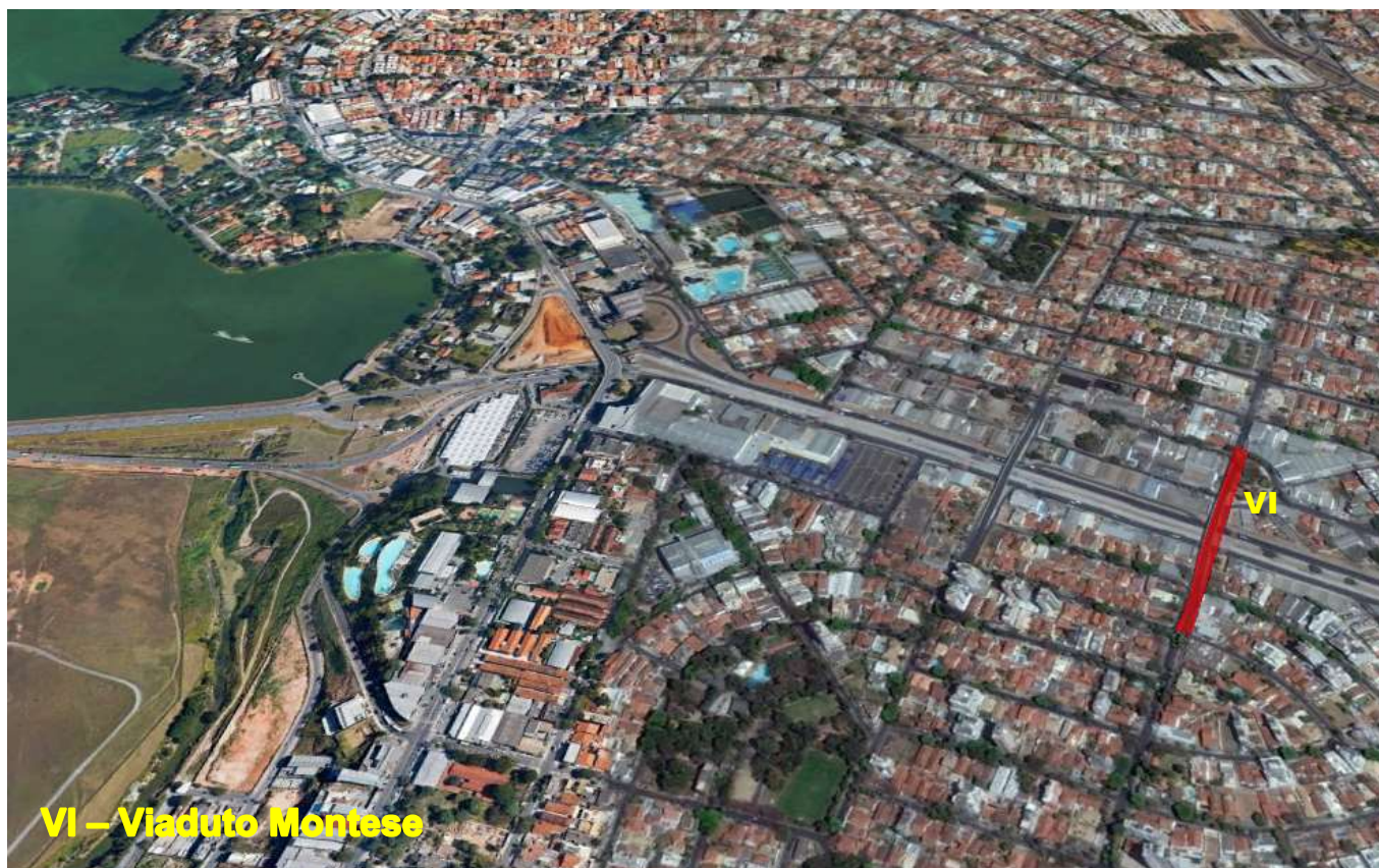
FIG02/FS – Região de localização das estruturas objetos de vistorias.
