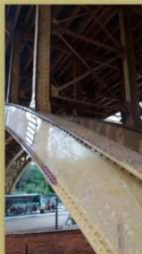
Contraventamento dos arcos
