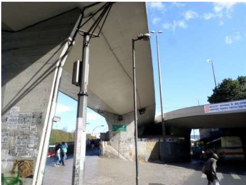
F15/FS – Outra vista do viaduto e seus pilares.
