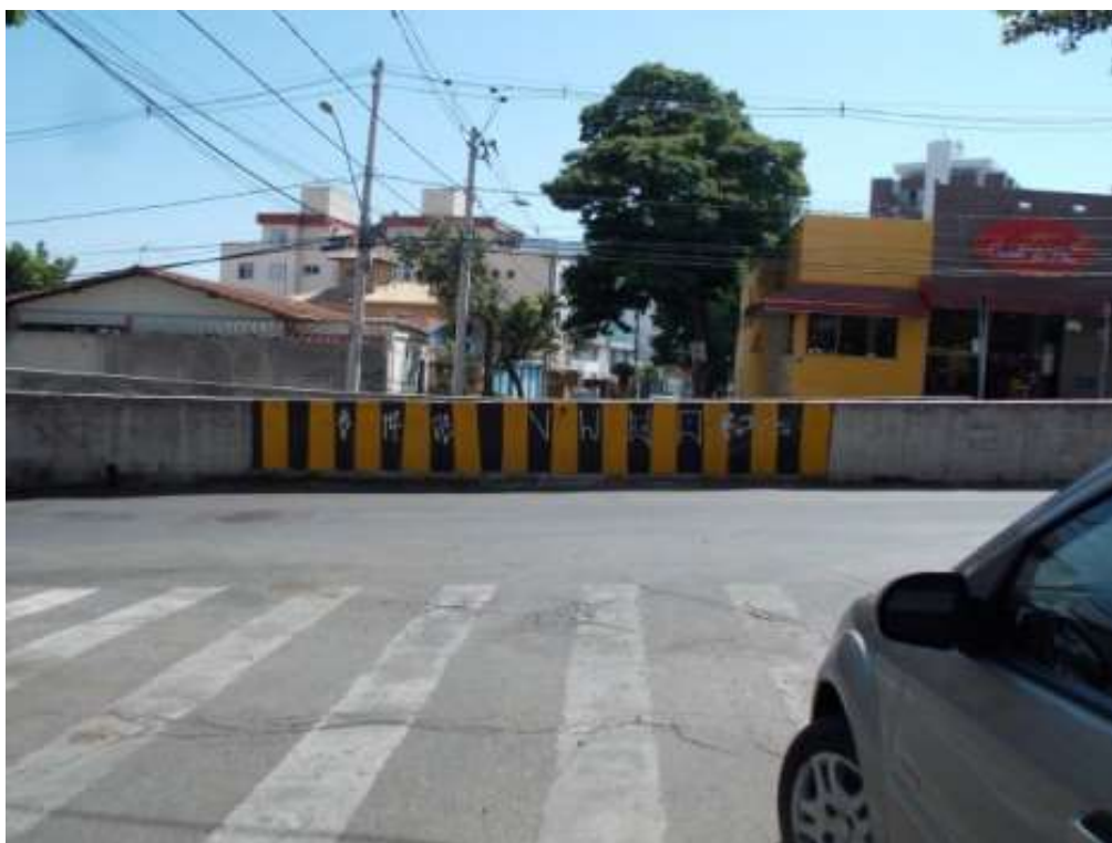
F64/FL – Viaduto Montese, interferência do viaduto na circulação das vias locais.
