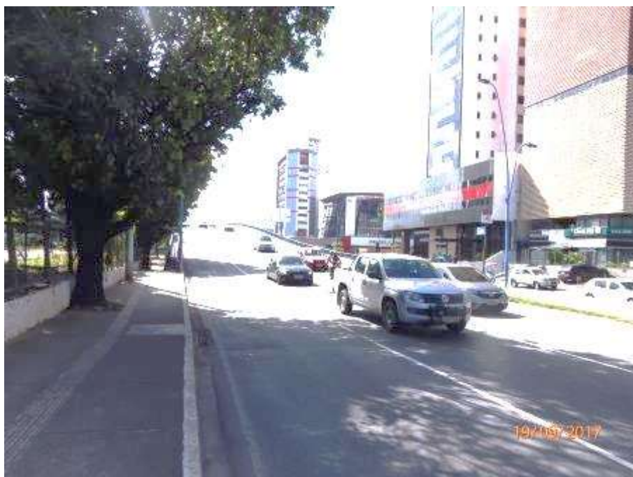
- Saída do viaduto.
