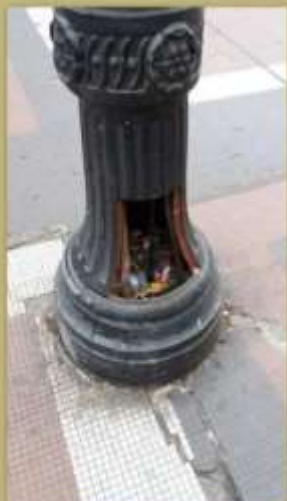
Base do Poste de Iluminação Pública
