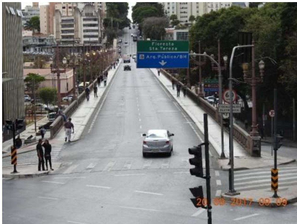
F01/ST – Viaduto Santa Tereza visto da esquina da Rua da Bahia com Rua Dos Tamoios.
