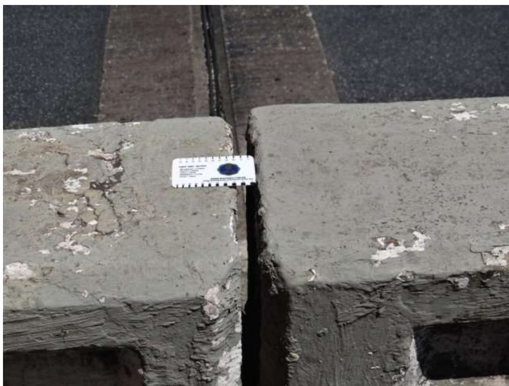
F48/FS – Detalhe afastamento da defesa em ponto onde existe junta de dilatação.
