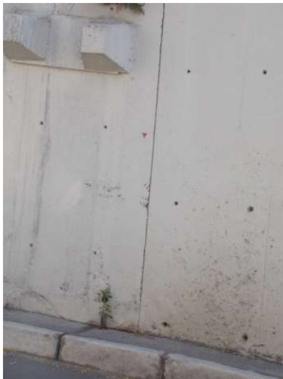
F48/FL –Viaduto Montese, detalhe do elemento descrito acima.
