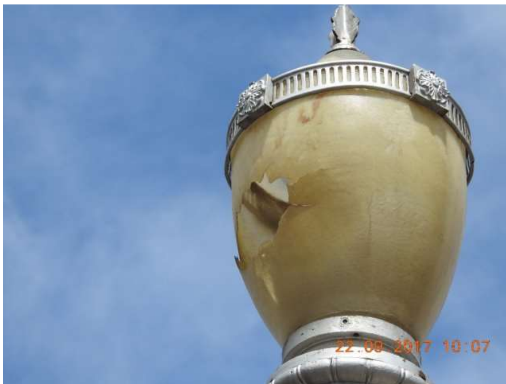
F43/FL – Detalhe da luminária quebrada.
