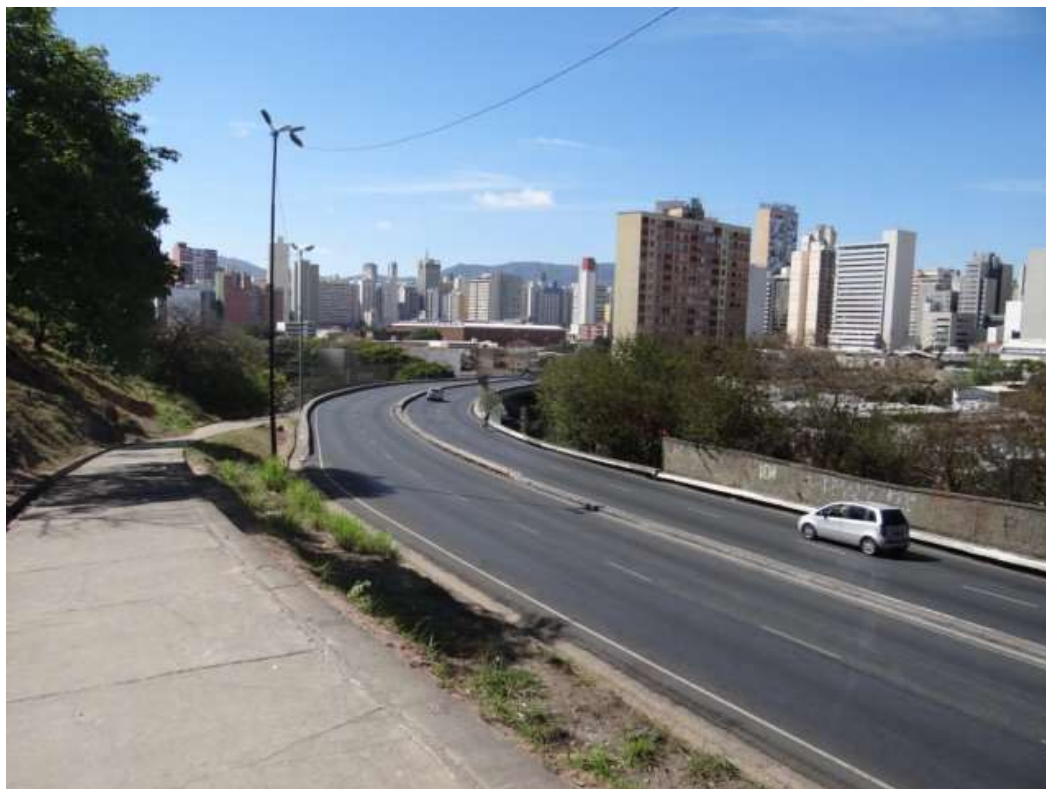
F03/HG – Vista geral do viaduto com detalhe do passeio disponível para passagem de pedestres.
