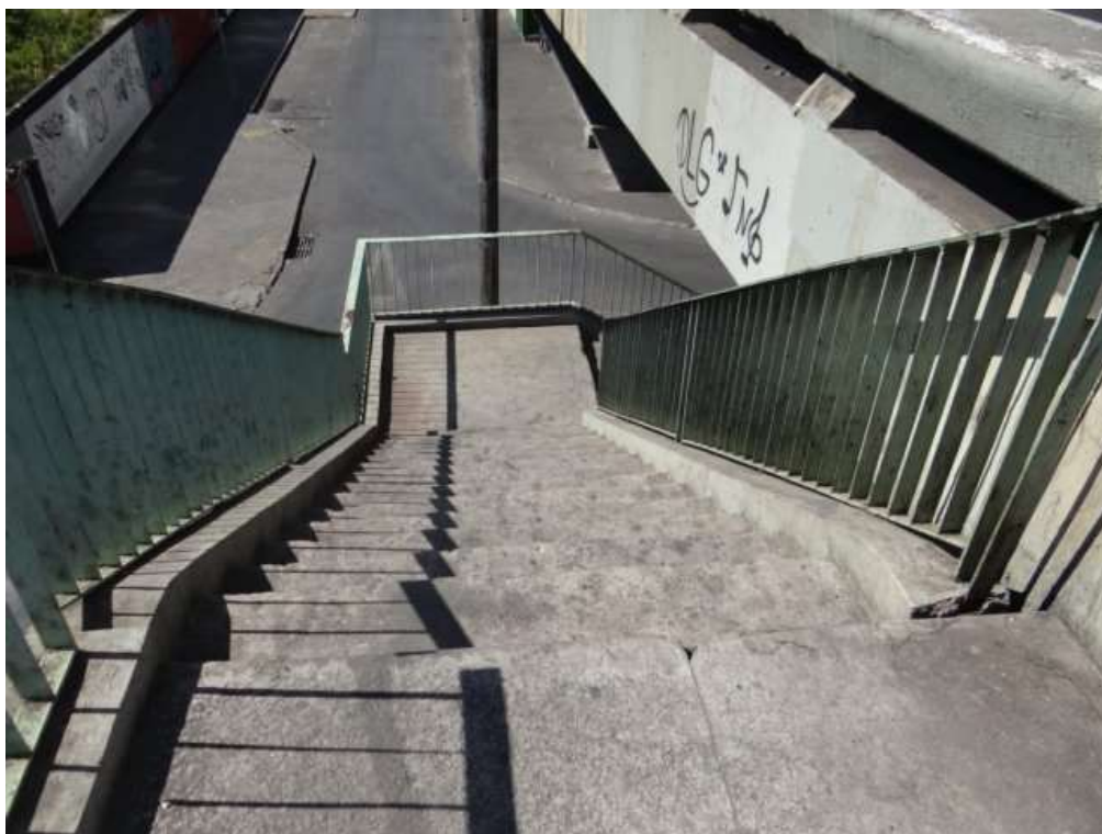
F30/HG – Escada que dá acesso ao passeio de pedestres.
