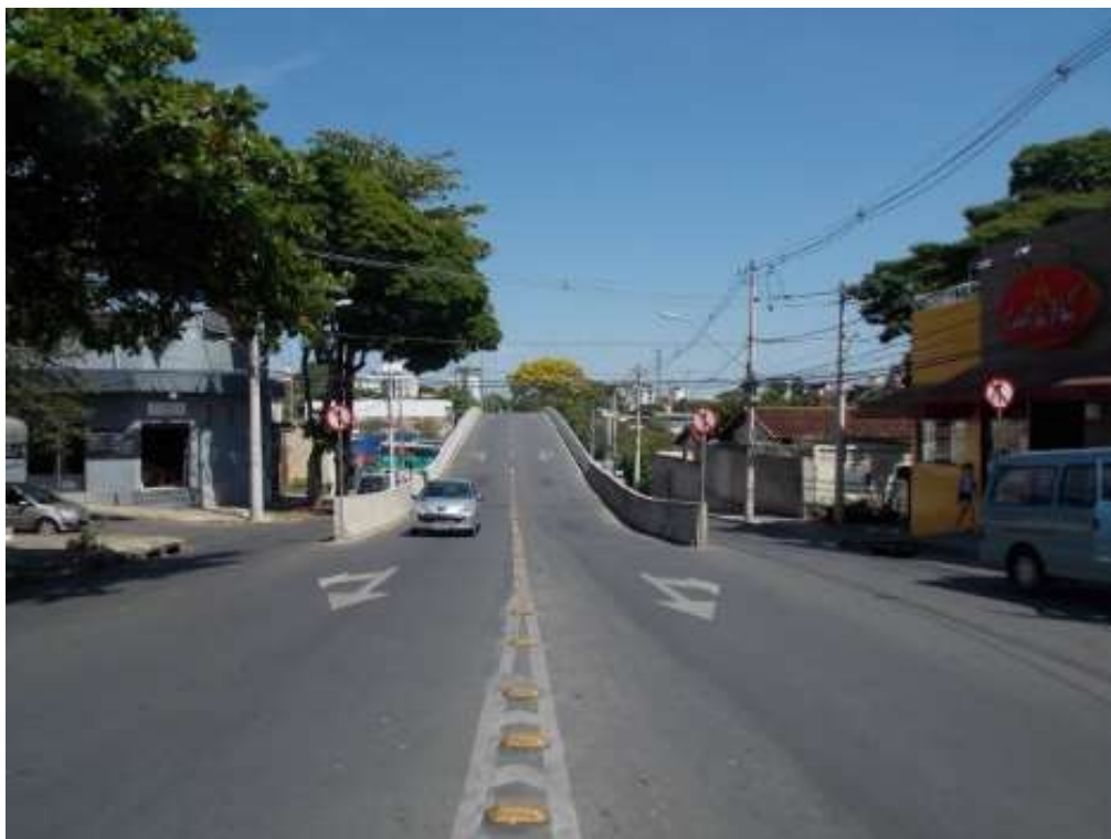
F02/FL – Viaduto Montese, visualizado pela rampa de acesso do Bairro Itapoã.
