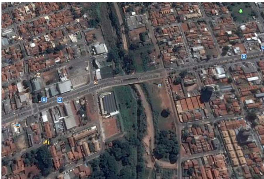
Ponte Avenida T-63 sobre o Córrego Cascavel, Setor Jardim América, Goiânia.
