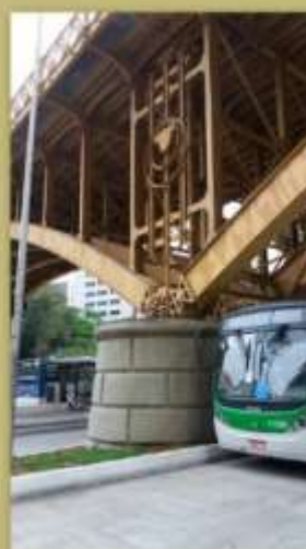
Contraventamento vertical sobre o aparelho de apoio central
