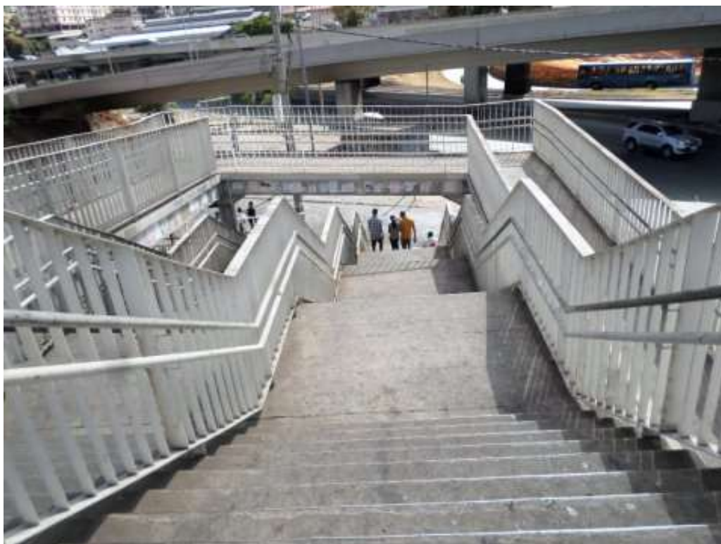
F42/FS – Vista da escada de acesso ao final da passarela.
