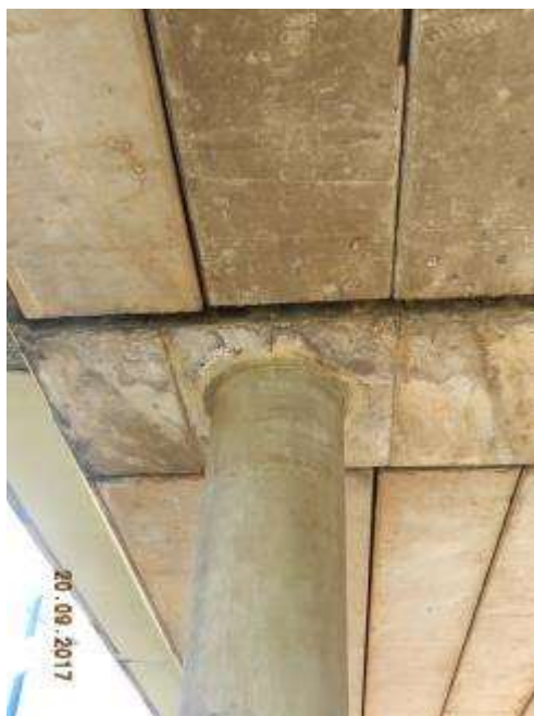
- Carbonatação do concreto nos apoios do tabuleiro.
