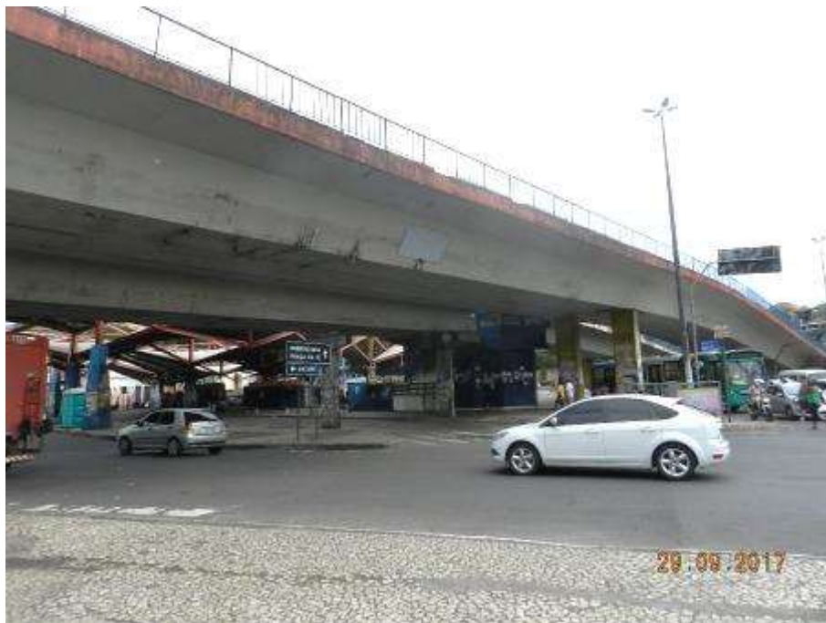
- Vista do viaduto sentido Comércio.
