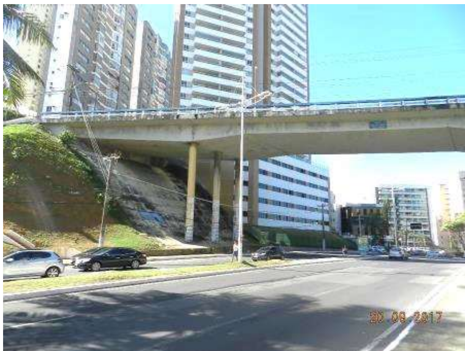
- Outra vista do viaduto Eng° José Nilson Dantas Maciel.
