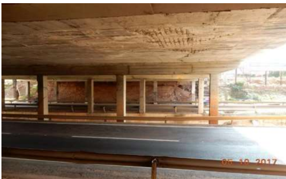
FOTO. 17 – Vista geral da face inferior da laje sobre a Marginal Botafogo.
