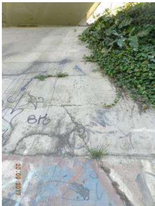
- Trincas e fissuras na camada de concreto do talude.
