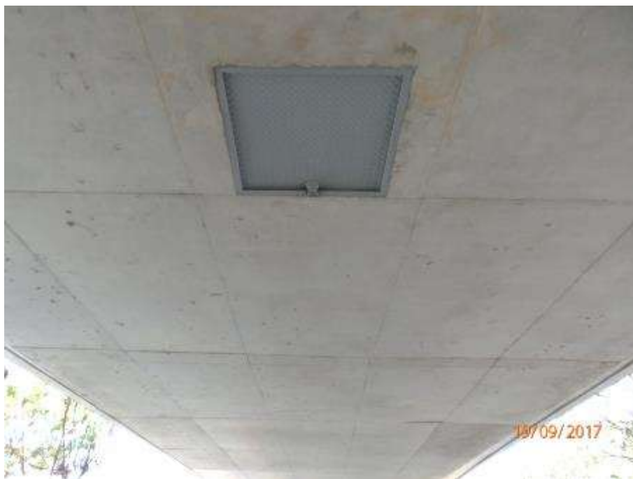
- Alçapão de acesso para manutenção no interior da estrutura.
