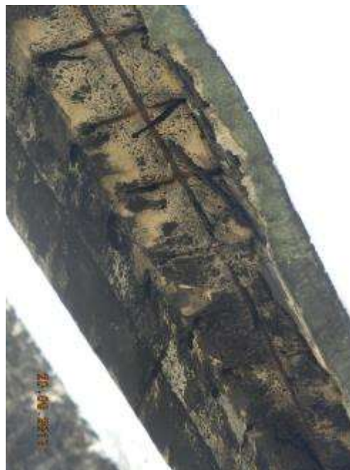
- Guarda corpo com ferragem aparente e pilaretes com rachadura.
