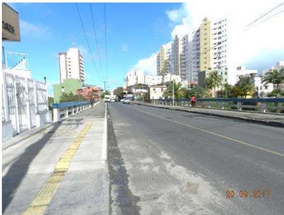
- Vista do viaduto, sentido bairro do Rio Vermelho.
