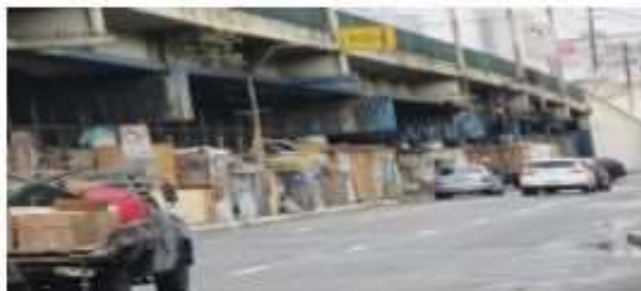
Moradias irregulares se formaram embaixo do viaduto
