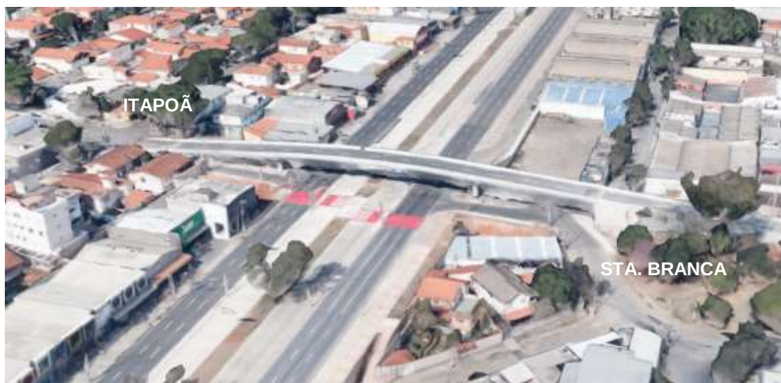
FIG04/FL – Fotografia Aérea do Viaduto Montese. Fonte: Google Earth.
