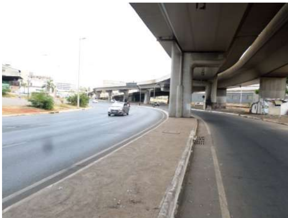
F54/FS – Vista geral da alça para Av. Pres. Antônio Carlos
