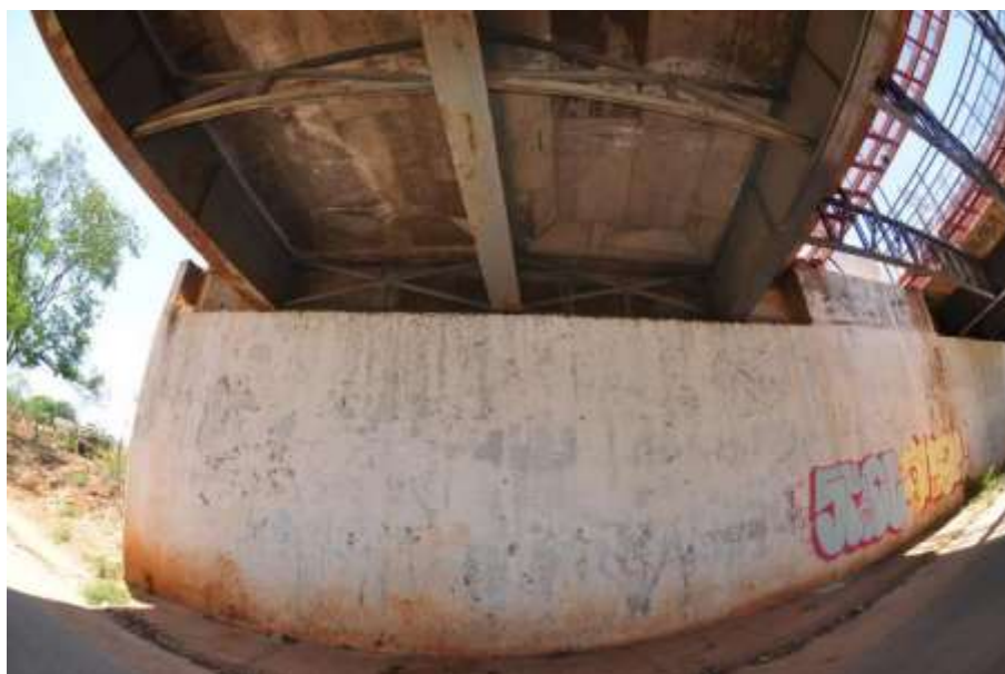
FOTO 40 – Vista da contenção do aterro da cabeceira da ponte na Ponte T-63 sobre o córrego Cascavel visualizado da Avenida T-63 sentido Centro / Bairro.
