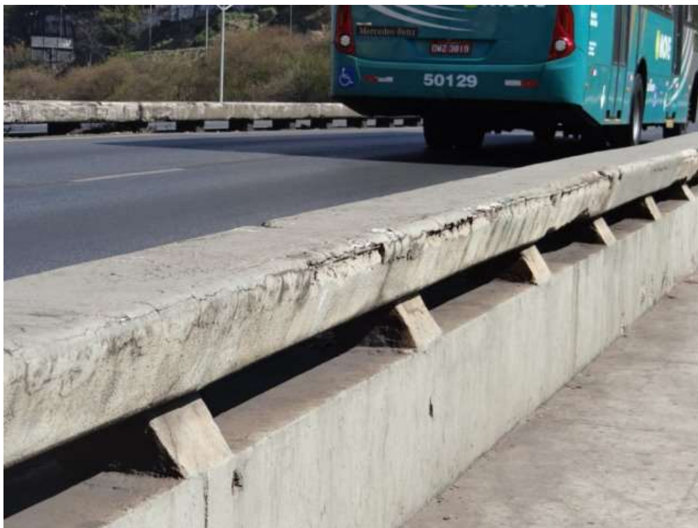
F29/HG – Falta de recobrimento em grande extensão da defesa.
