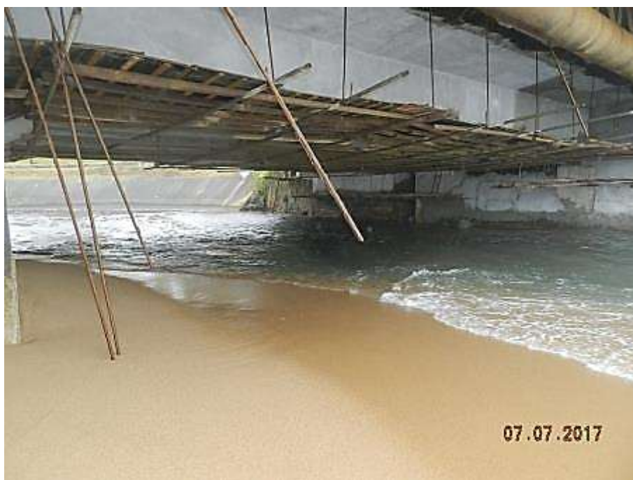
- Vista da parte inferior da ponte.
