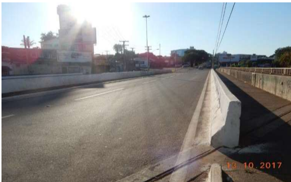
FOTO. 6 – Pista de rolamento e Guarda corpo sul, vista pela cabeceira 01.
