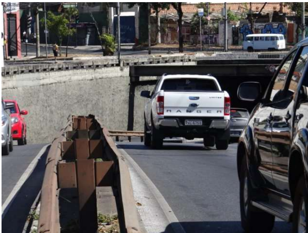
F05/HG – Vista da trincheira existente no viaduto.
