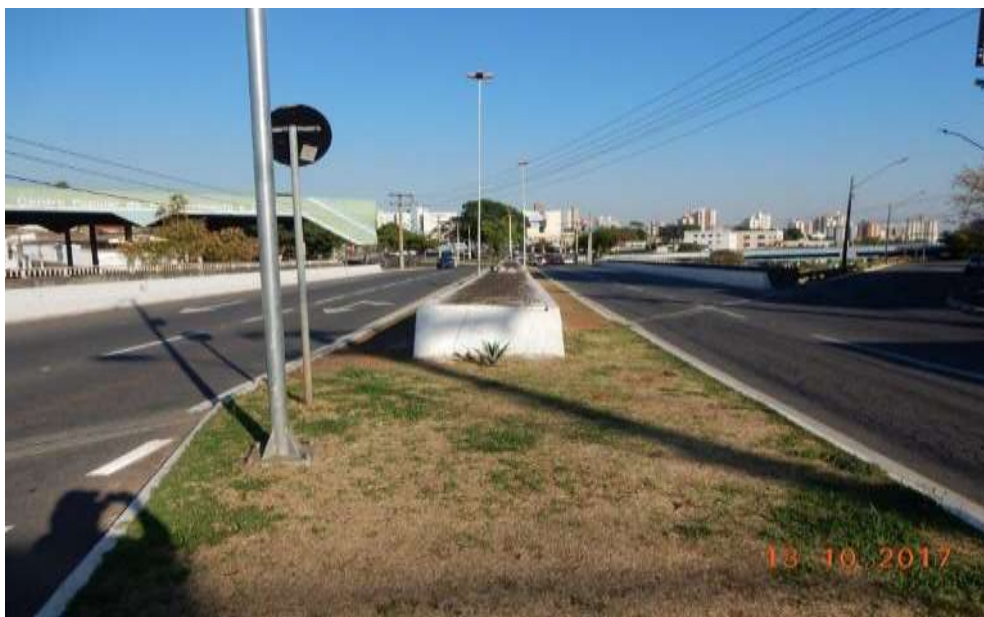
FOTO. 8 – Vista geral da pista: à direita pista sul, à esquerda pista norte e ao centro, tubulação de água potável embutida entre os dois guarda corpos e pré-moldado de concreto horizontal na parte superior.
