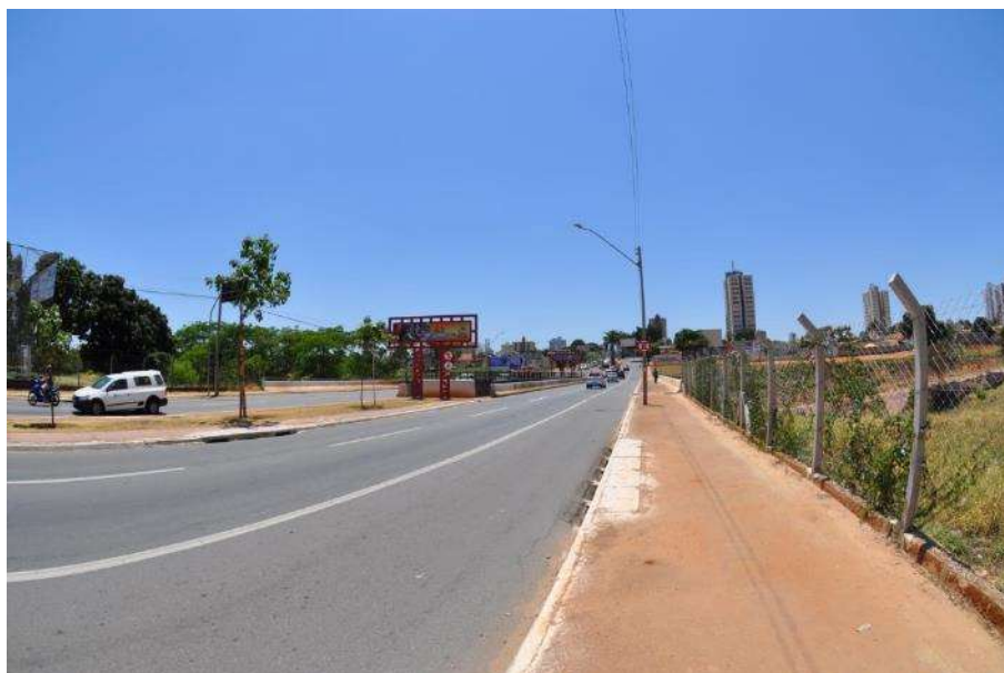
FOTO 4 – Vista de um dos pontos de drenagem pluvial lateral na pista de rolamento que antecede a Ponte T-63 sobre o córrego Cascavel visualizado da Avenida T-63 sentido Centro / Bairro.
