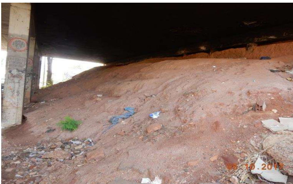
FOTO. 22 – Talude em terra e pilaretes da cabeceira, visto pela Marginal Botafogo.
