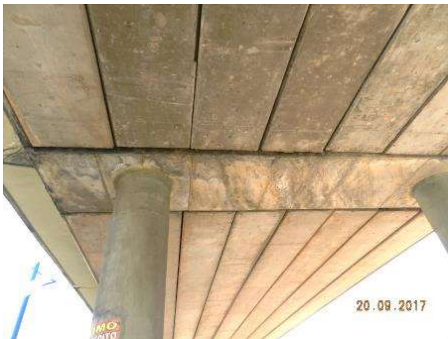
- Carbonatação do concreto nos apoios do tabuleiro.
