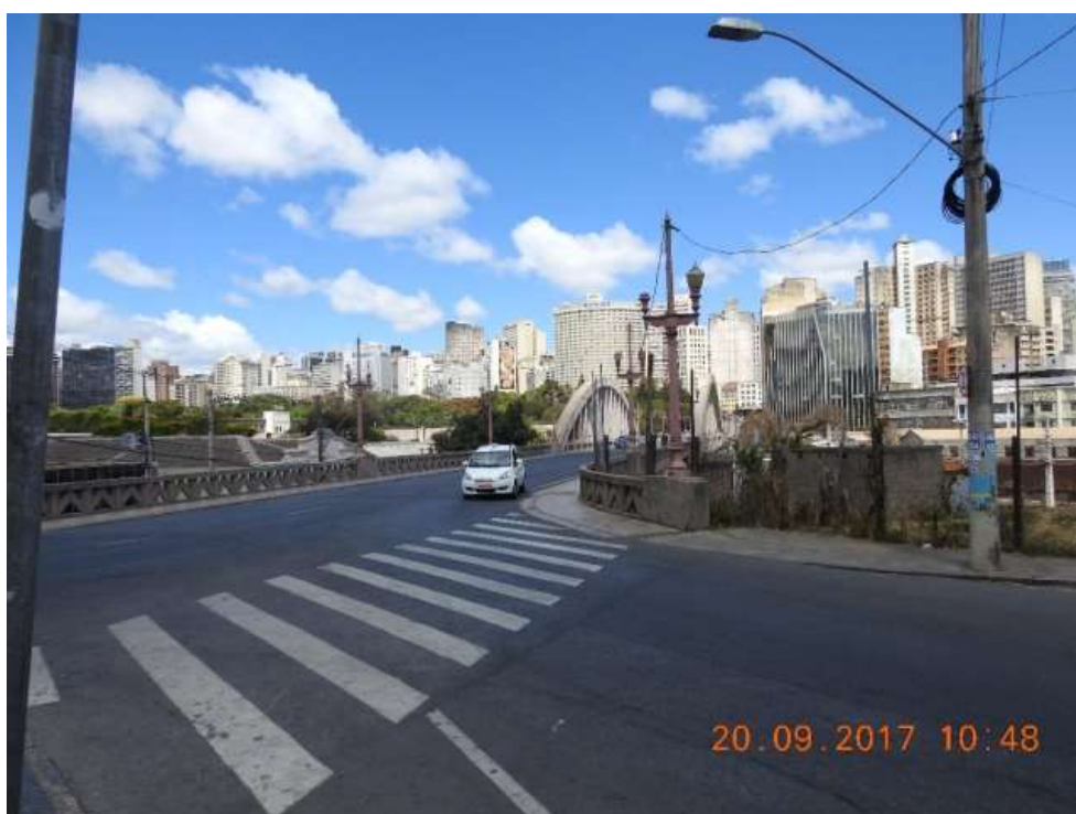
F58/ST – Vista do viaduto da esquina da Rua Sapucaí com Avenida Assis Chateaubriant. Danos e falta de padronização no passeio.
