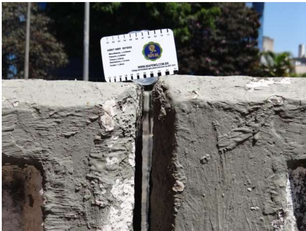
F49/FS – Detalhe do desnível da defesa onde existe junta de dilatação.
