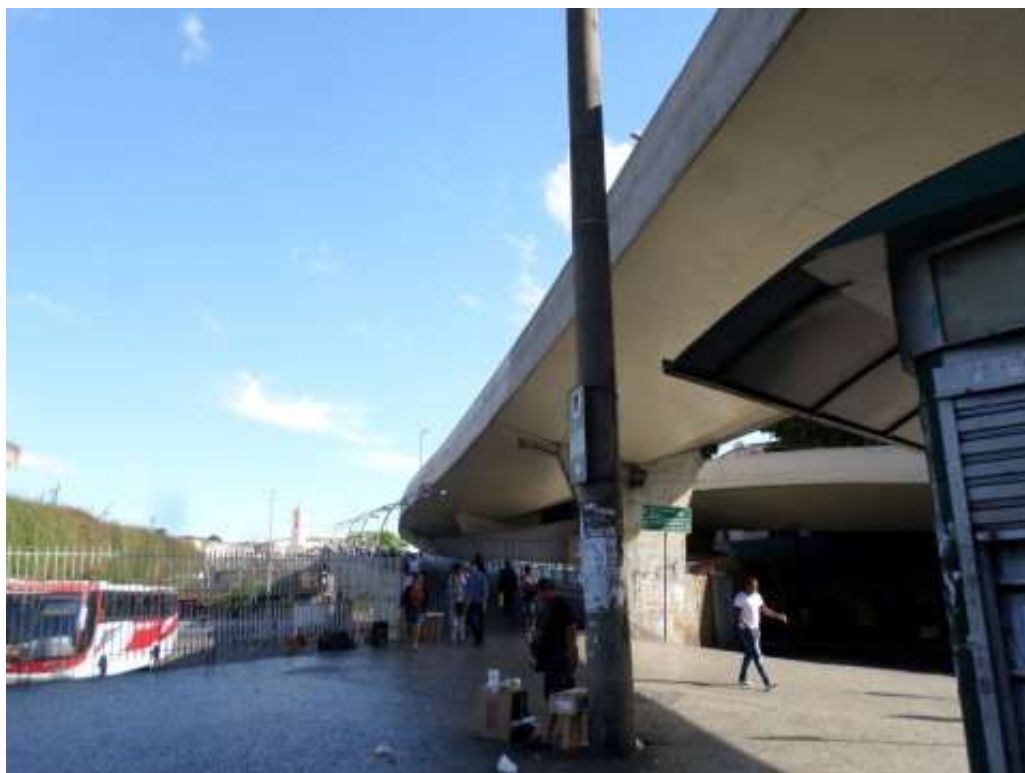
F24/FS – Vista do início da passarela de acesso à Estação do metrô e a Av. Presidente Antônio Carlos.
