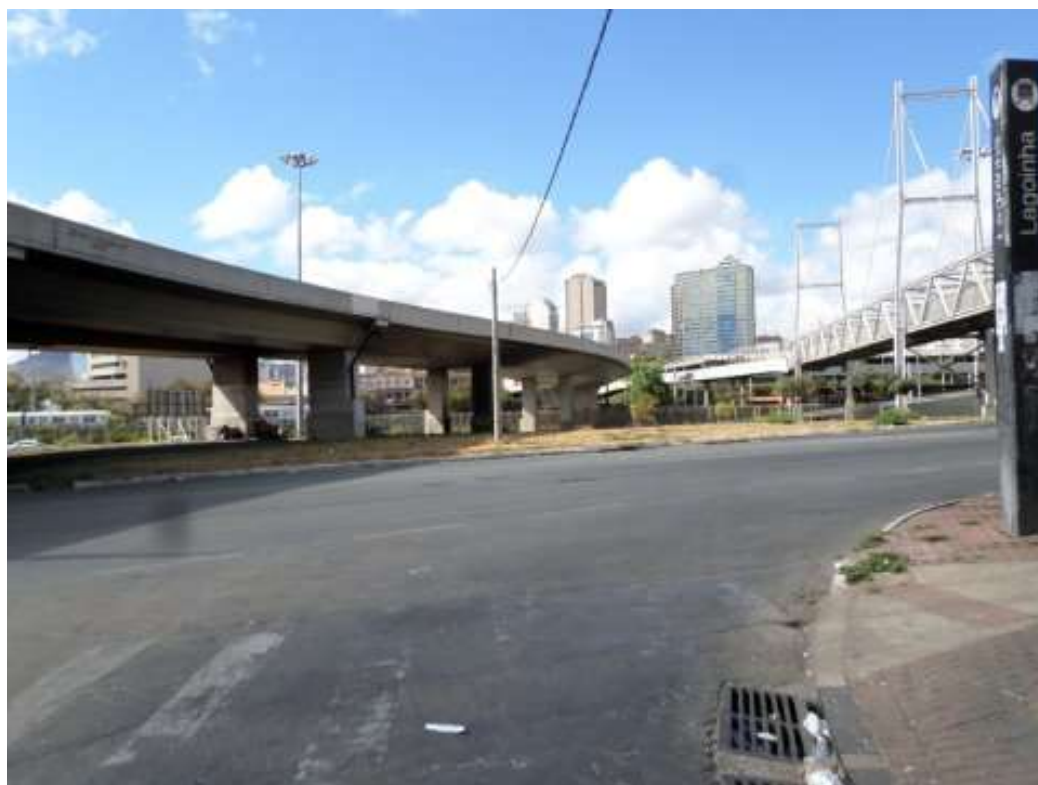
F46/FS – Vista do mesmo viaduto após atravessar o Rio Arruda.
