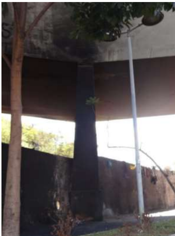
F41/HG – Vista de um dos pilares com marcas deixadas por fogueiras.
