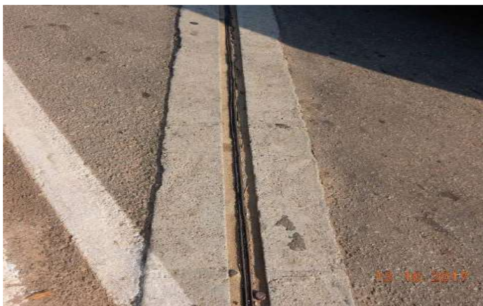
FOTO. 5 – Pista de rolamento, junta de dilatação da cabeceira 01 na Avenida Fuad José Sebba.
