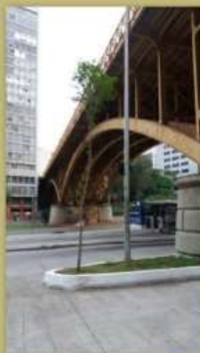
Arcos do viaduto (superestrutura)
