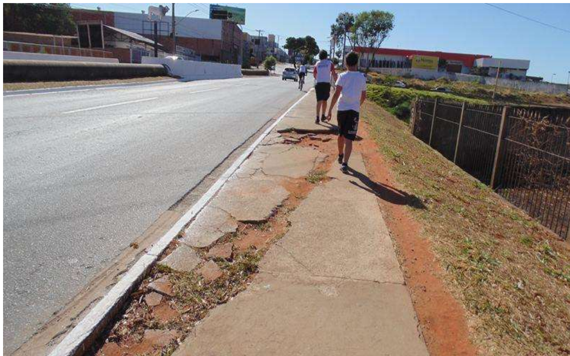
Foto 12 – Passeio totalmente danificado, sarjeta com buracos e rachaduras nas guias.
