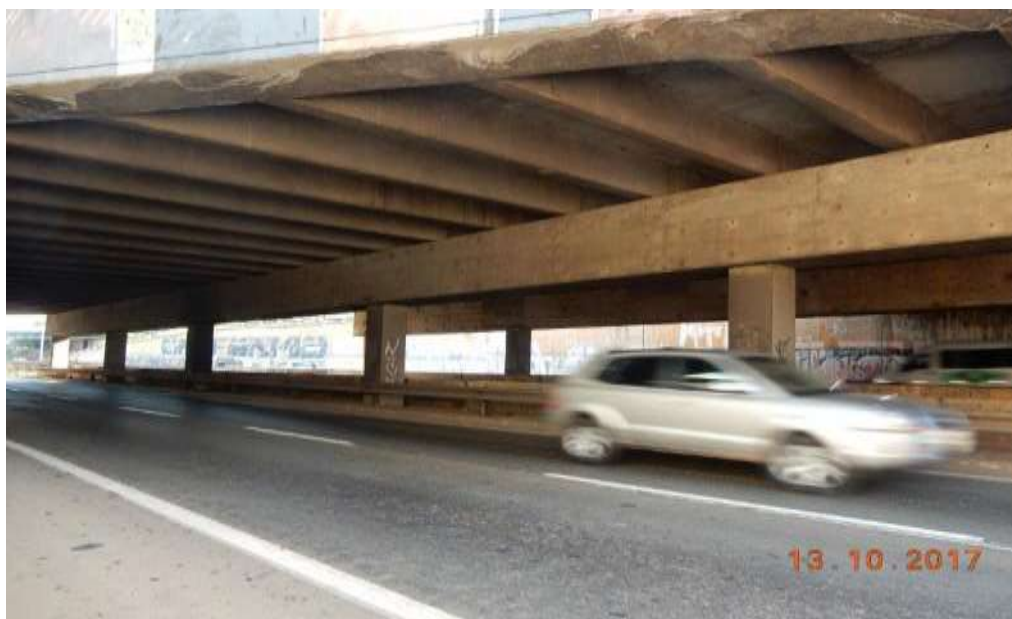
FOTO. 14 – Pista de rolagem da Marginal Botafogo e vista geral inferior da ponte.
