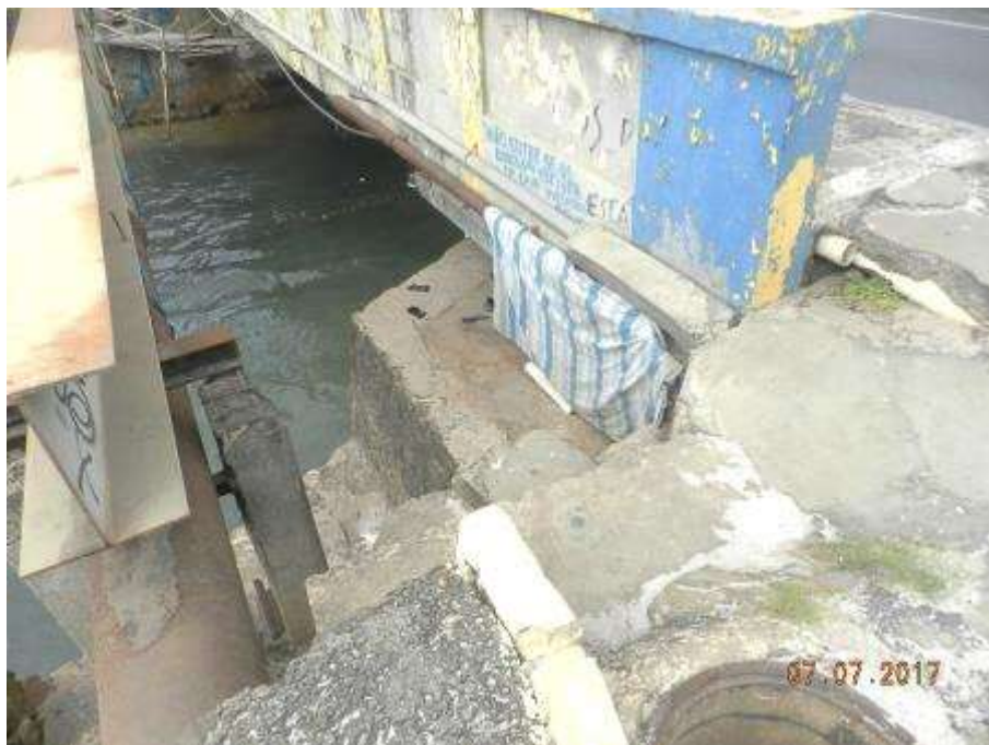
- Ponte sendo utilizada como abrigo para moradores de rua.
