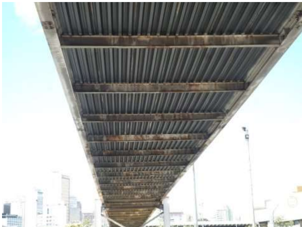
F45/FS – Vista aproximada da mesma passarela.
