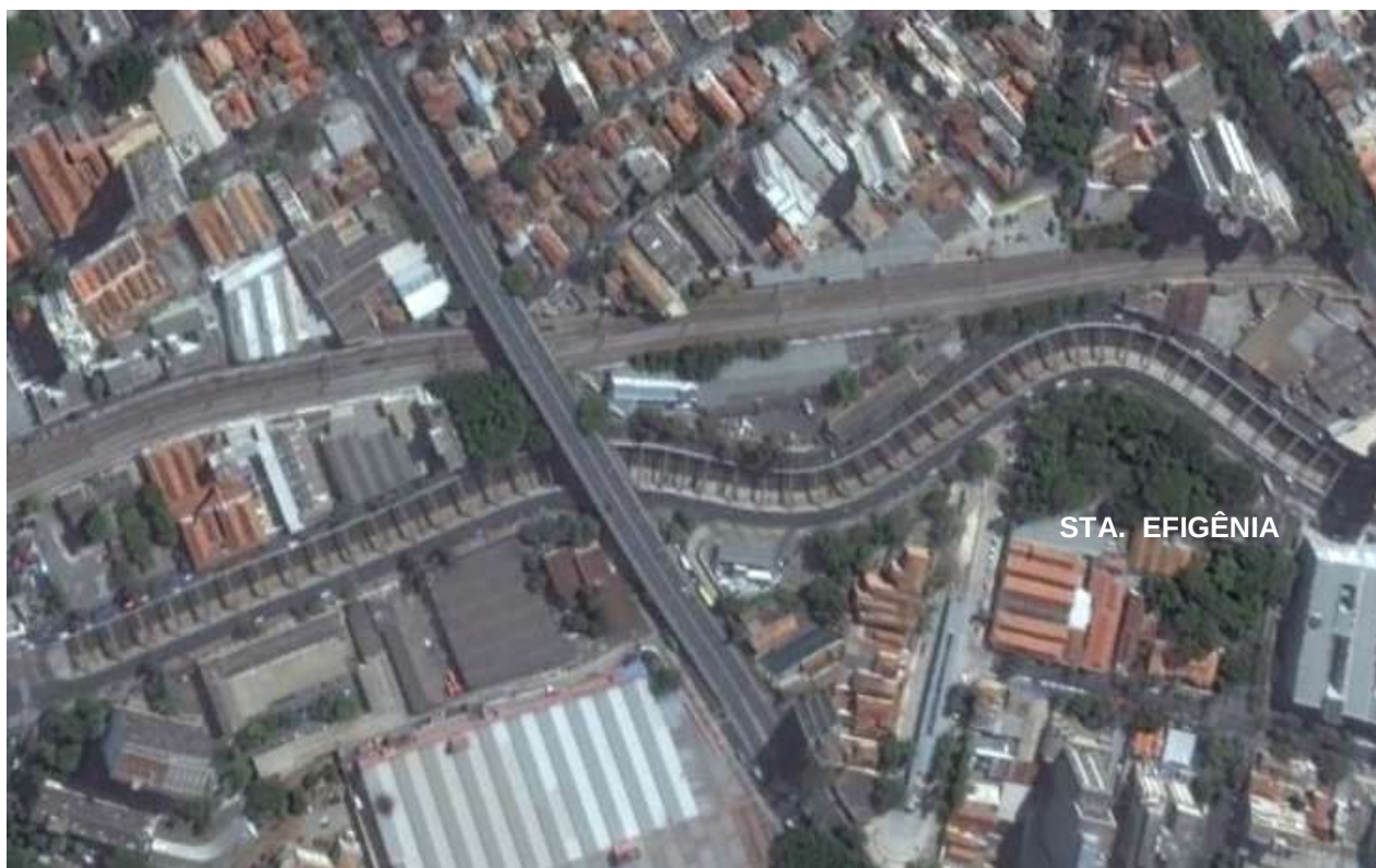
FIG03/FL – Fotografia Aérea do Viaduto Pedro Aguinaldo Fulgêncio. Fonte: Google Earth.
