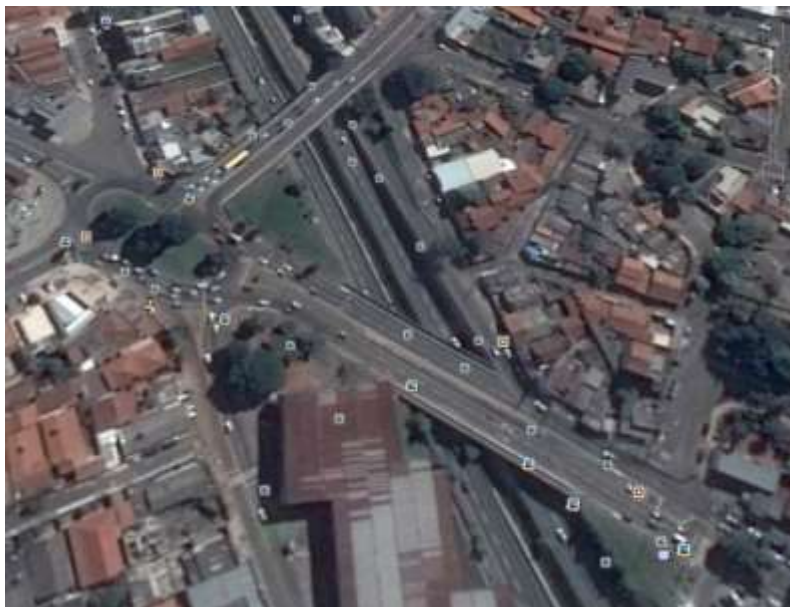
Ponte Avenida Fuad José Sebba com a Marginal Botafogo, Setor Sul, Goiânia.
