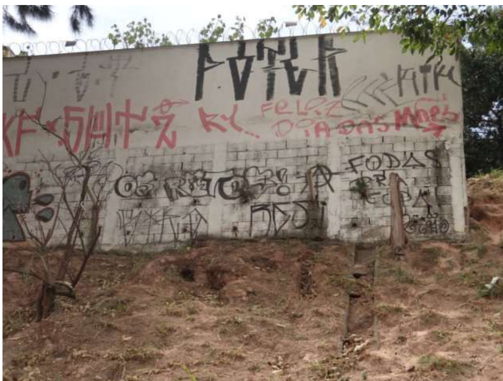
F20/HG – Outra vista dos diversos pontos de lançamento de drenagem antes da contenção.
