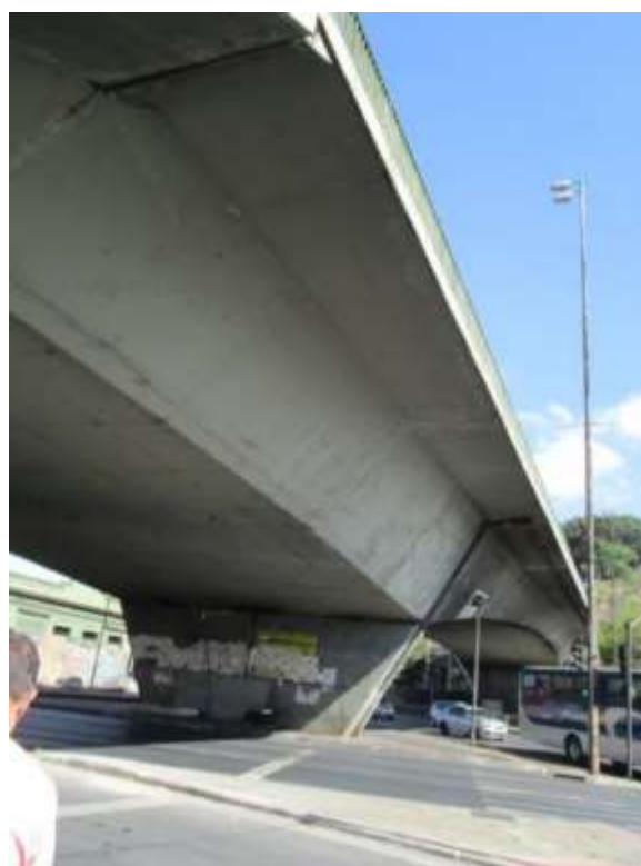
F38/HG – Vista geral da estrutura do viaduto nas proximidades da Avenida Tereza Cristina.
