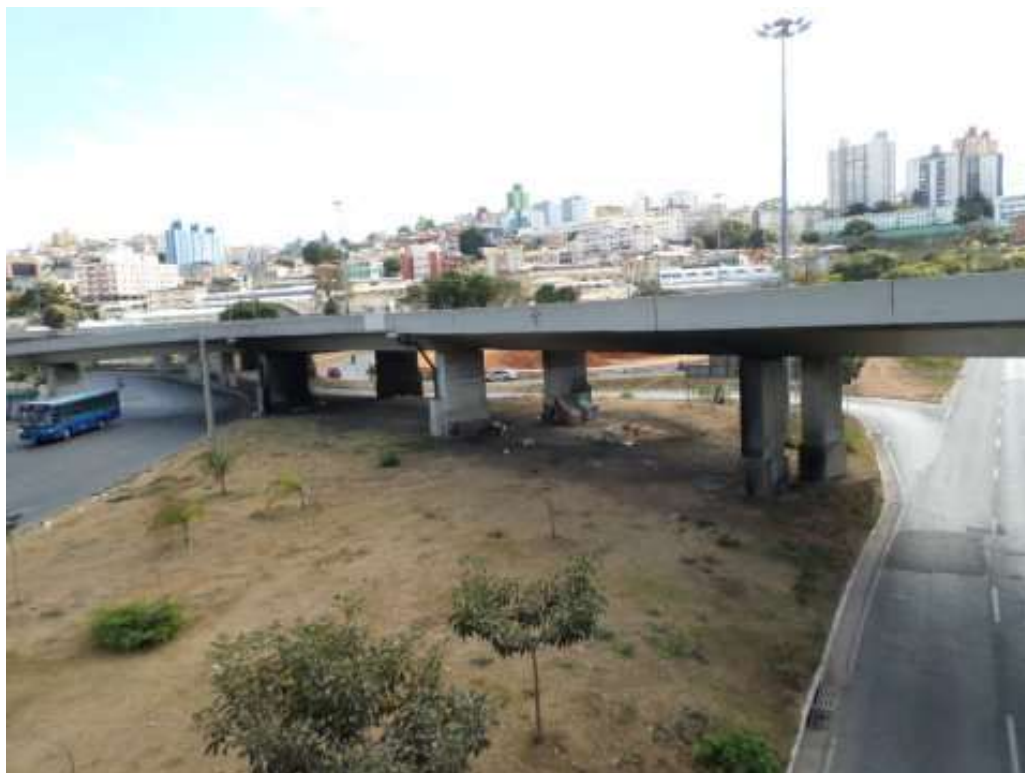
F39/FS – Vista geral da continuação do viaduto e seu desmembramento em duas direções, uma para Av. Pres. Antônio Carlos e a outra para a Av. Pedro II.
