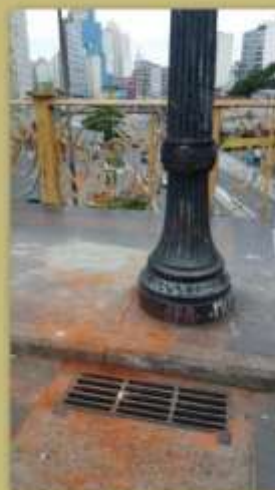
Grelha de escoamento de água pluvial no centro do viaduto
