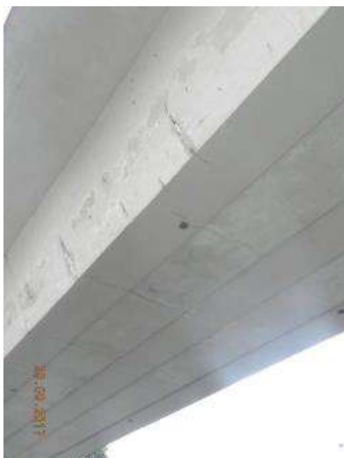
- Trincas próximas ao ponto de iluminação.
