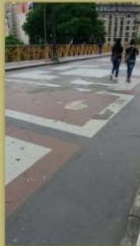
Detalhe do piso do viaduto em pastilha (ausência de várias peças)
