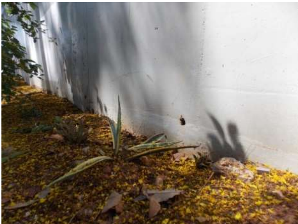
F12/FL –Viaduto Montese, detalhe do dispositivo de drenagem.
