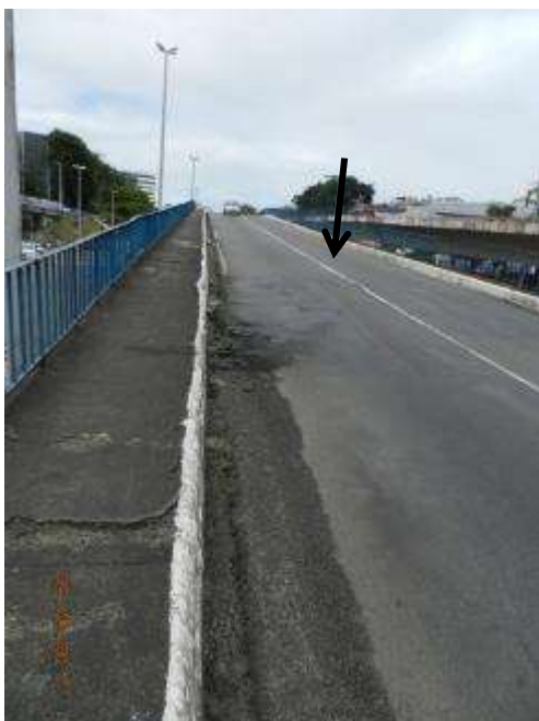
- Deficiência do pavimento asfáltico.
