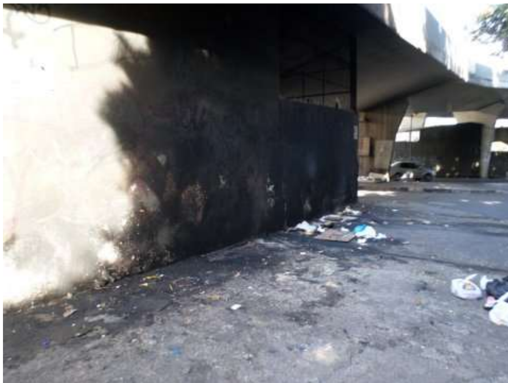
F19/FS – Vista da base da cabeceira 2 com marcas de fuligem.
