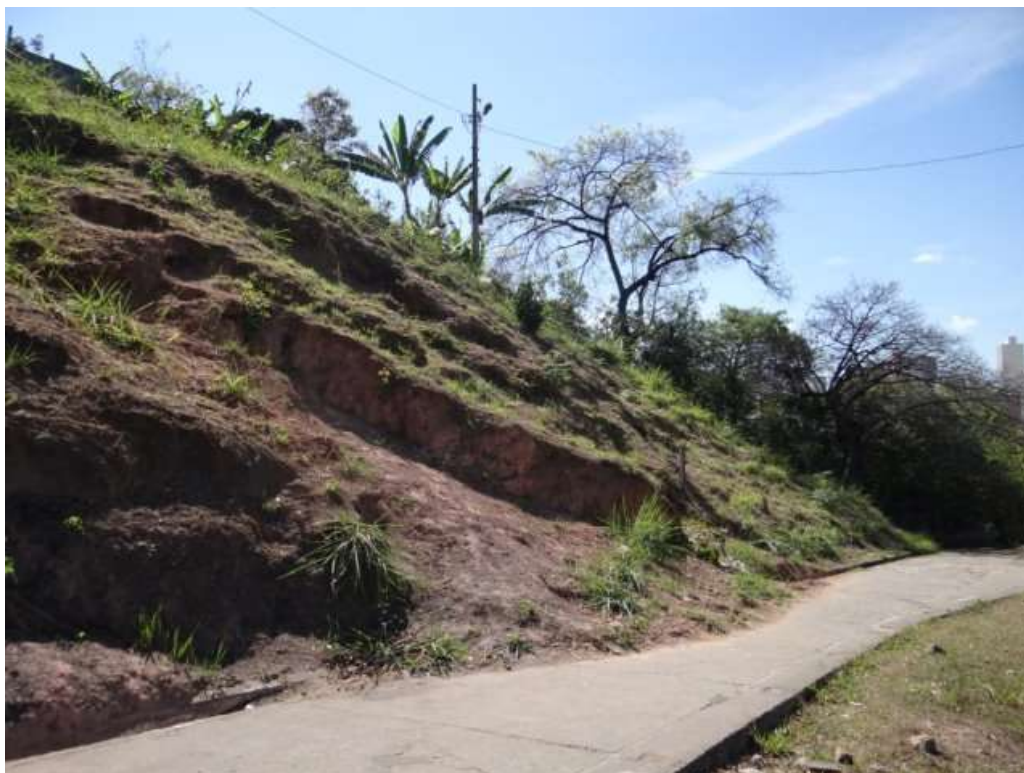
F21/HG – Detalhe de erosão e movimentação de terra, obstruindo parcialmente o passeio de pedestres.
