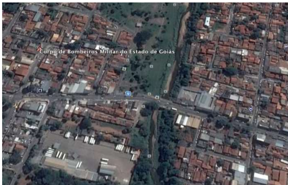
Ponte Avenida 24 de Outubro sobre o Córrego Cascavel, Goiânia
