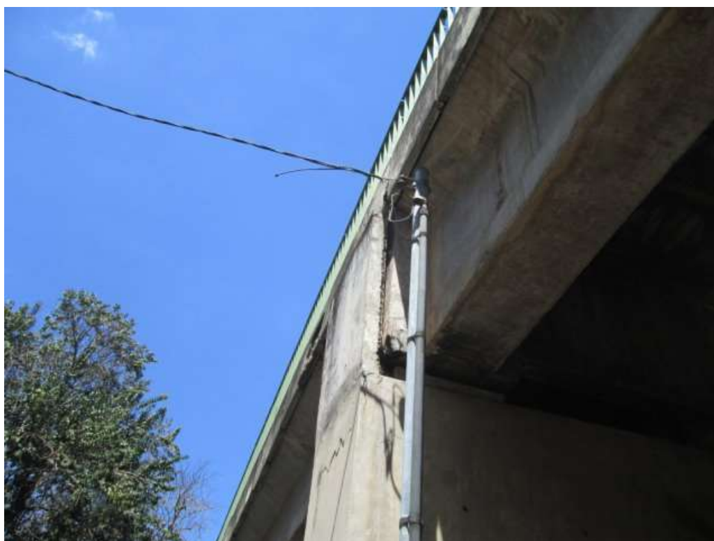
F30/FS – Detalhe movimentação da estrutura.
