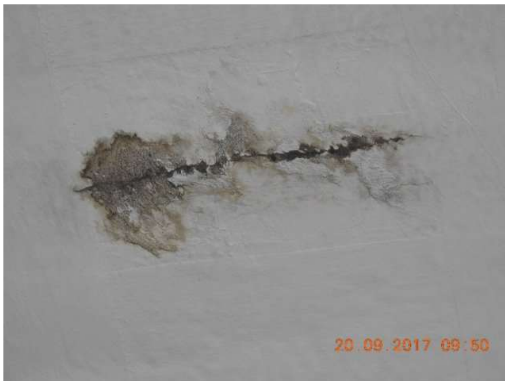
F23/ST – Detalhe para armadura já comprometida por oxidação.
