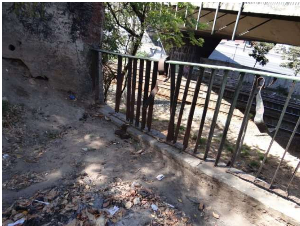
F25/HG – Detalhe guarda corpo da foto anterior.
