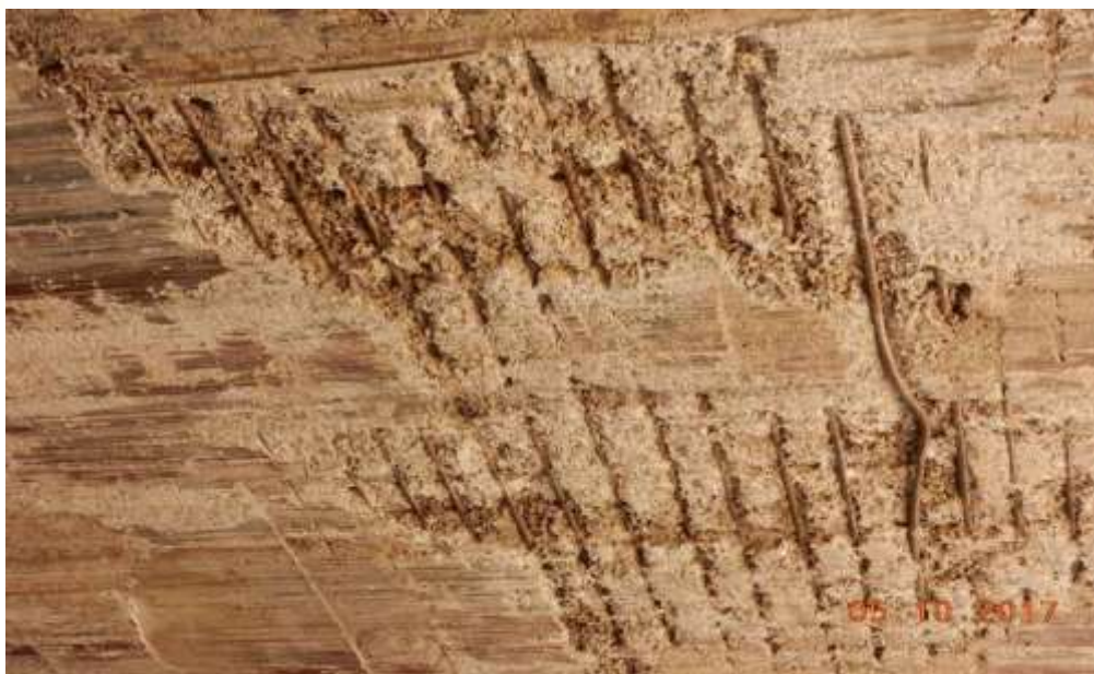
FOTO. 18 – Laje sobre a Marginal Botafogo com Ferragem exposta, cobrimento insuficiente da armadura e corrosão em ferragem, na estrutura de concreto armado. O concreto foi parcialmente danificado por Impacto de veículos altos.
