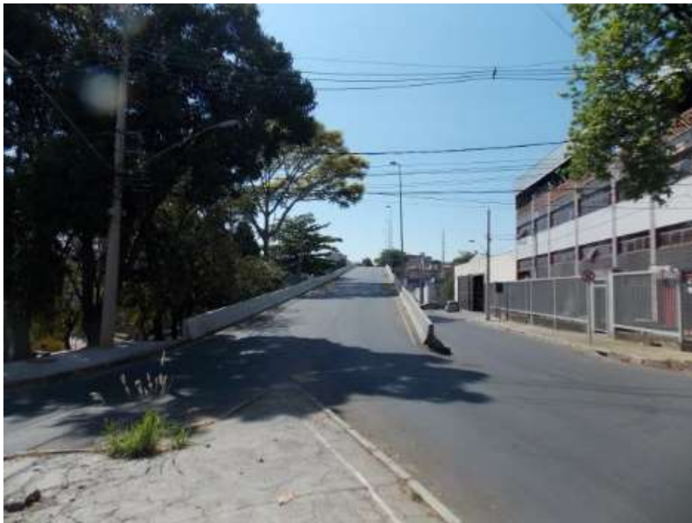
F01/FL – Viaduto Montese, visualizado da rampa de acesso do Bairro Santa Branca.
