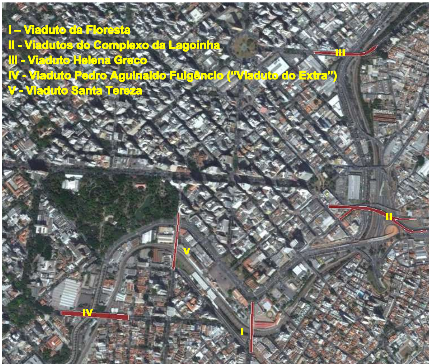
FIG01/FS – Região de localização das estruturas objetos de vistorias.
