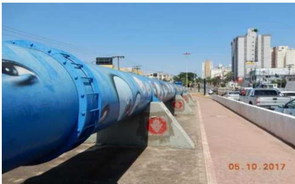
FOTO. 3 – Ilha central da Avenida Universitária, passeio e tubulação de água potável.
