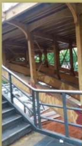
Contraventamento vertical dos arcos do viaduto
