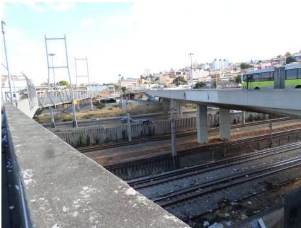
F30/FS – Vista geral do viaduto.
