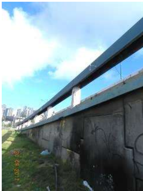
- Trincas nos pilaretes do guarda corpo.
