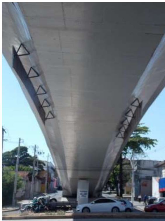
F39/FL –Viaduto Montese, seção inferior seção inferior do tabuleiro.
