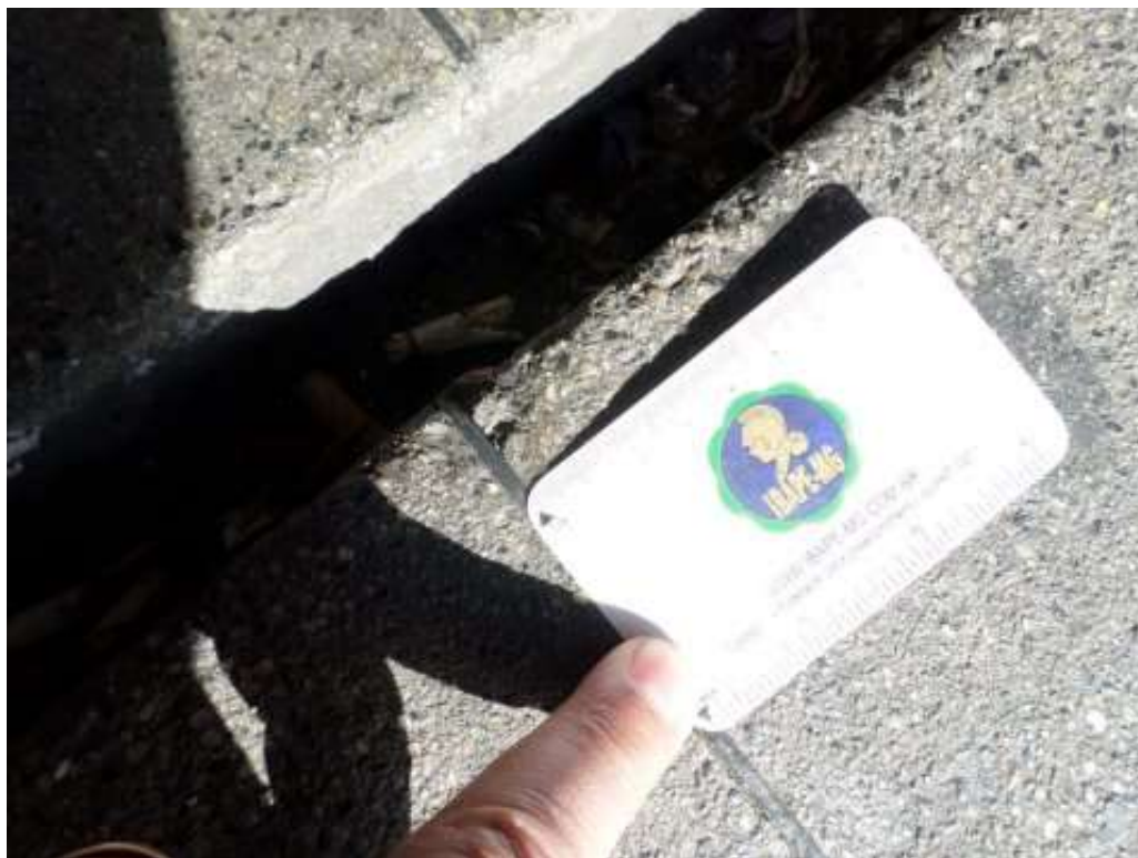
F35/FS – Vista do deslocamento lateral da mesma interface.
