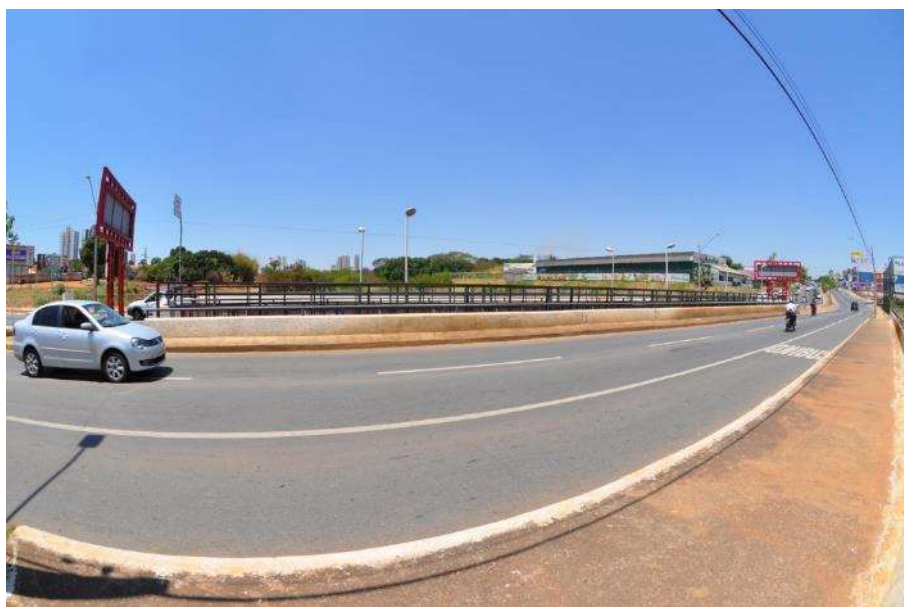
FOTO 2 – Vista de outro ponto da Ponte T-63 sobre o córrego Cascavel visualizado da Avenida T-63 sentido Centro / Bairro.
