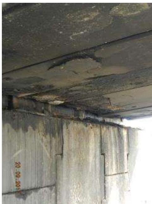
- Deslocamento do concreto na laje do viaduto.
