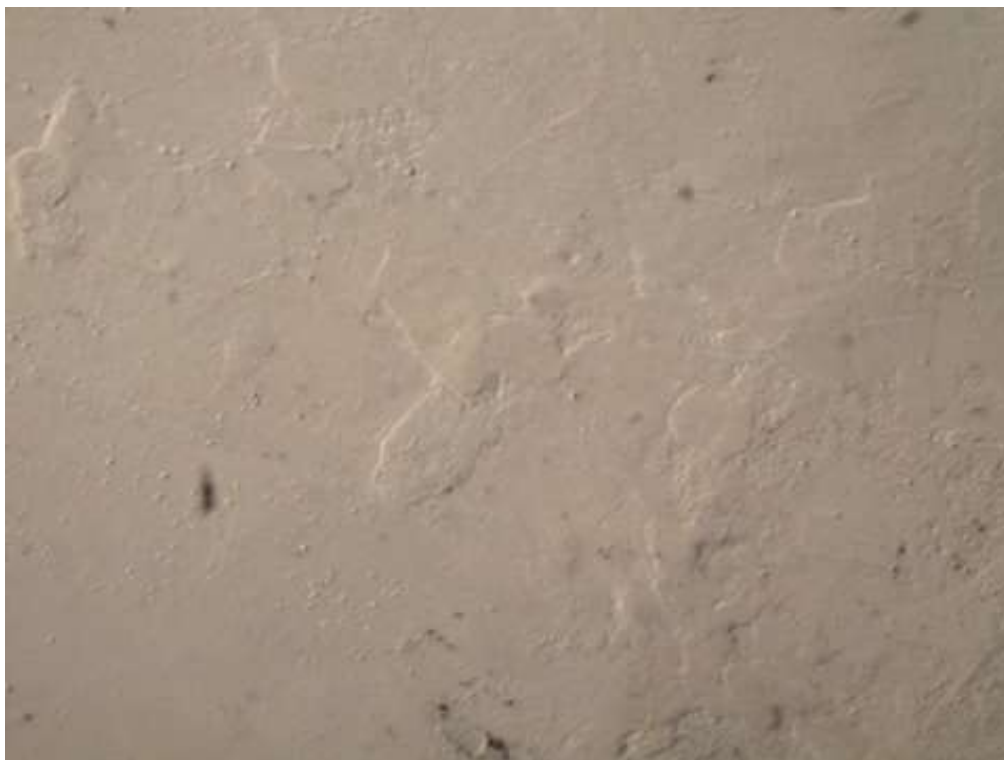
F09/FS – Outra vista aproximada dos deslocamento com pintura por cima
