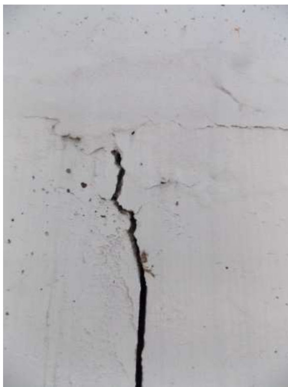
F60/FL – Viaduto Montese, detalhe da junta.
