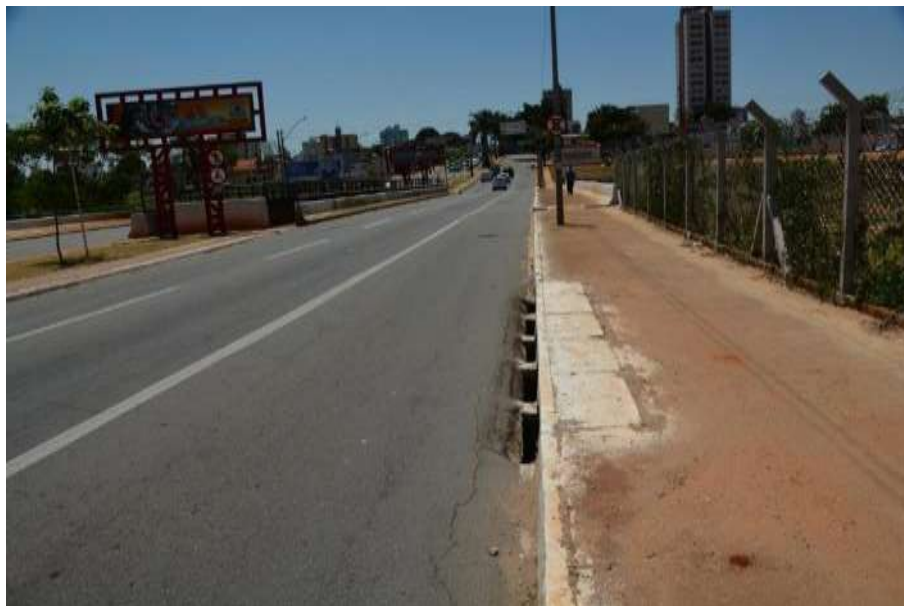
FOTO 47 –Vista do pavimento asfáltico rachado próximo a um dos pontos de drenagem pluvial lateral na pista de rolamento que antecede a pista da Ponte T-63 sobre o córrego Cascavel visualizado da Avenida T-63 sentido Bairro / Centro.
