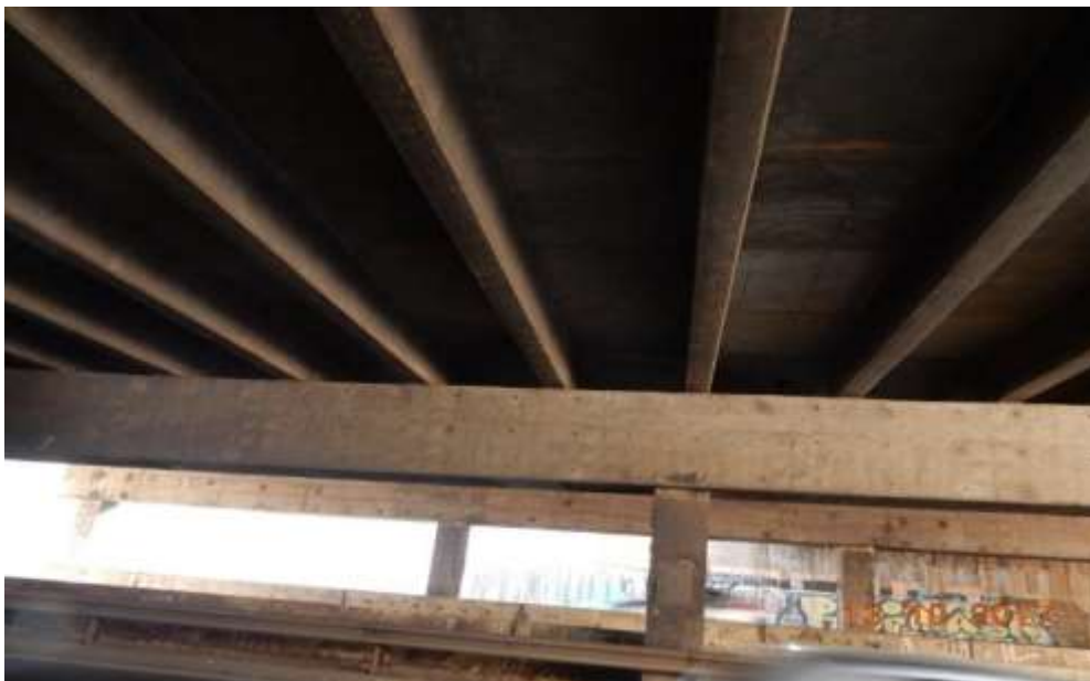
FOTO. 16 – Estrutura da ponte, vista inferior.
