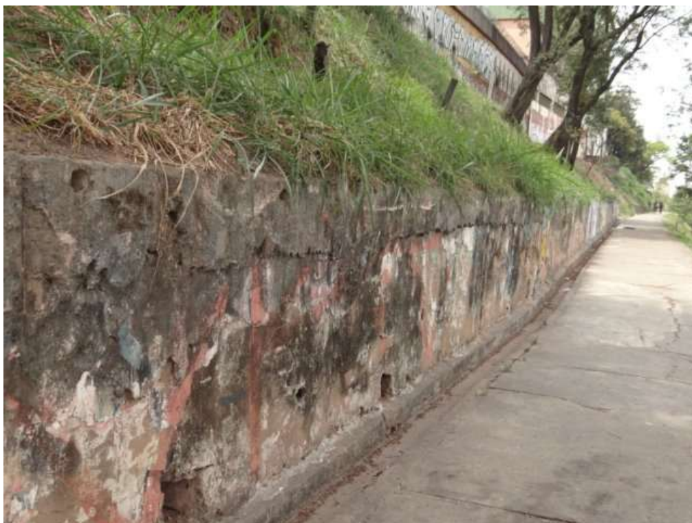
F14/HG – Detalhe de drenagem na contenção.
