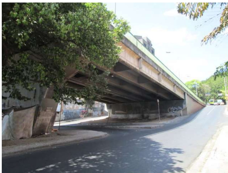
F04/FS – Outra vista da estrutura do viaduto, Bairro Santa Efigênia.
