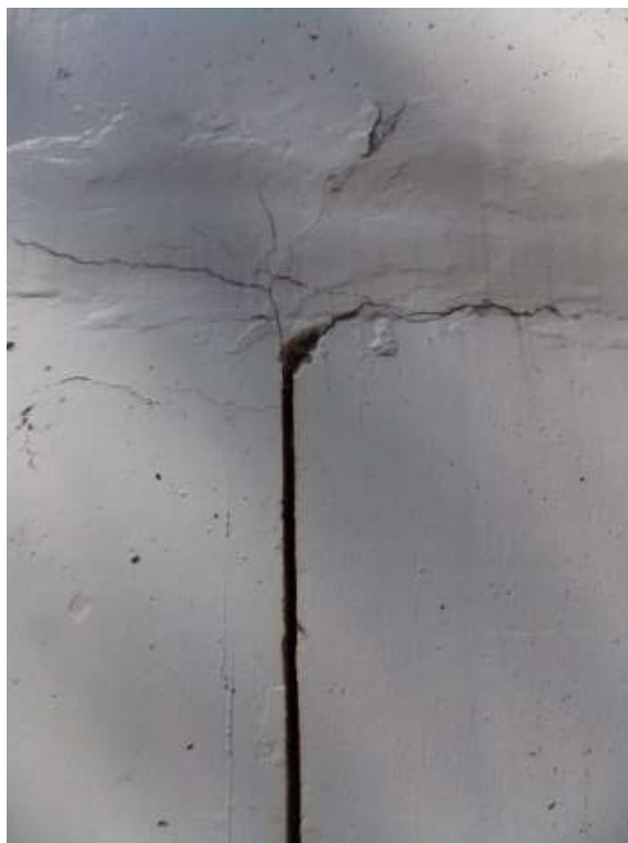
F07/FL – Viaduto Montese, detalhe da fotografia anterior.
