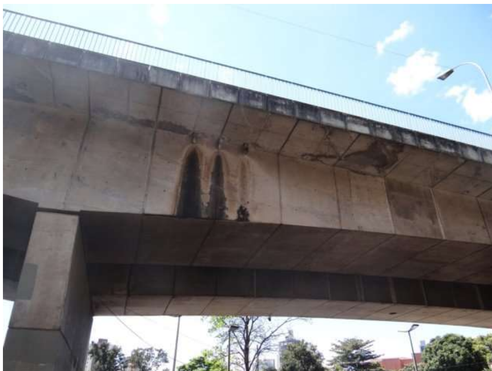
F14/FS – Outro detalhe do sistema de drenagem na lateral do viaduto.
