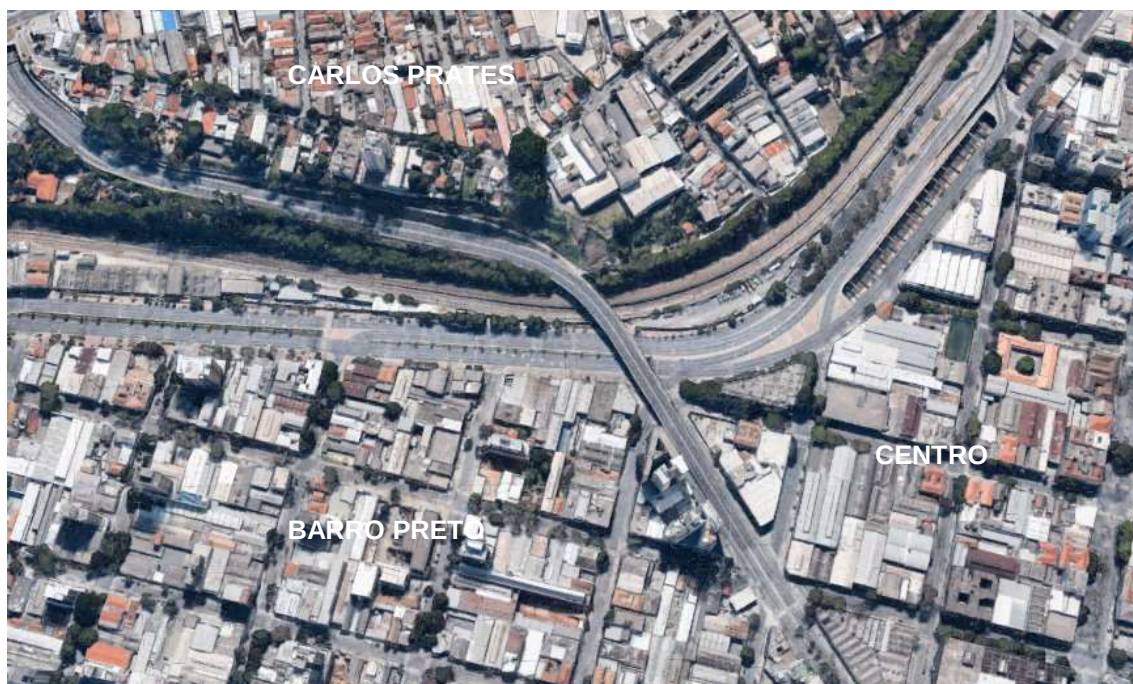
FIG03/FL – Fotografia Aérea do Viaduto Helena Greco. Fonte: Google Earth.
