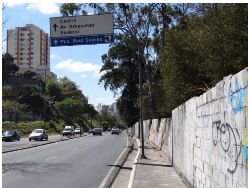
F42/HG – Vista do viaduto sentido Centro de Belo Horizonte.
