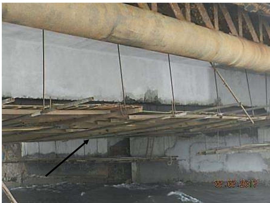
- Estrutura provisório instalada sob a ponte.
