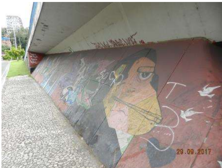
- Parede de contenção da cabeceira 01.
