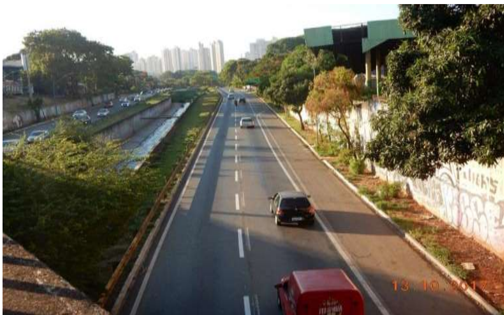
FOTO. 3 – Vista da Marginal Botafogo – pista norte sul com observador sobre a Ponte.
