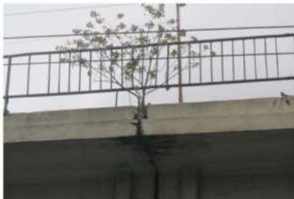
Arbustos ajudam a danificar as juntas de dilatações
