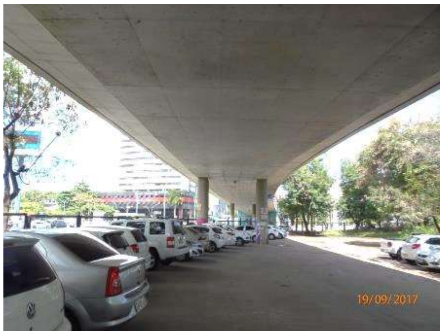
- Parte inferior do tabuleiro.
