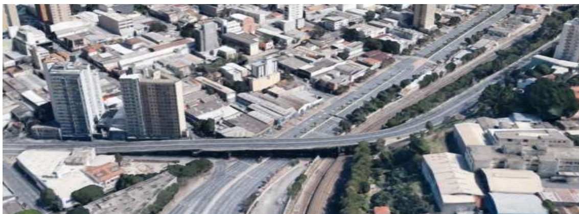
FIG04/FL – Fotografia Aérea do Viaduto Helena Greco . Fonte: Google Earth.
