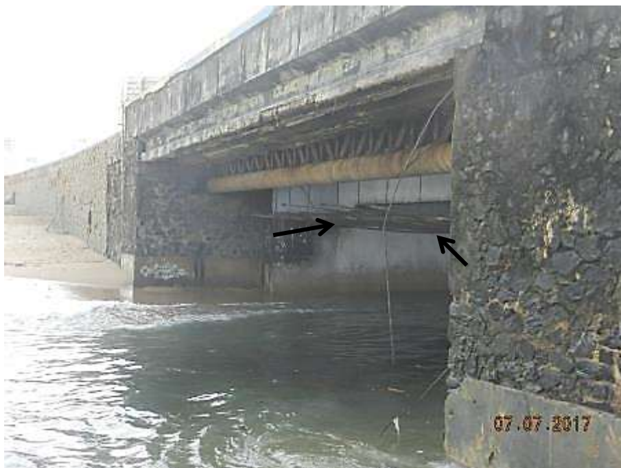
- Armaduras rompidas.
