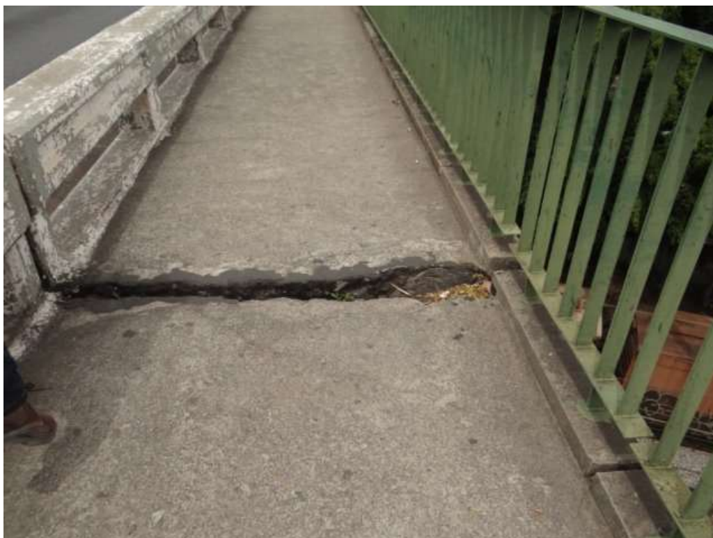
F42/FS – Detalhe de junta de dilatação no passeio para pedestres.
