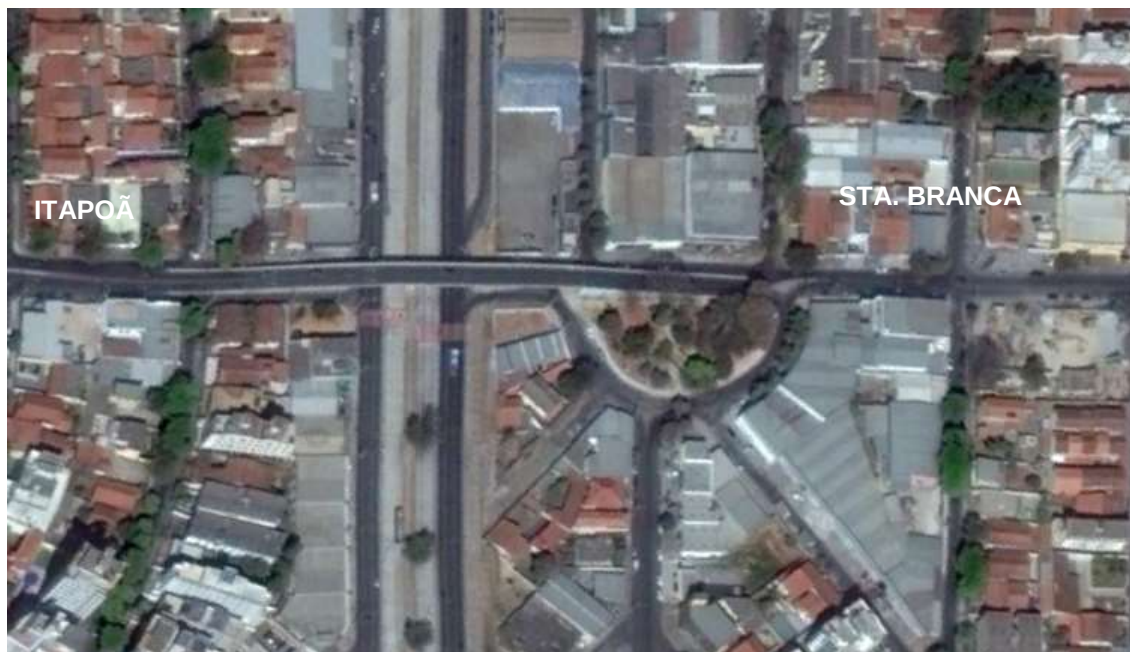
FIG03/FL – Fotografia Aérea do Viaduto Montese. Fonte: Google Earth.
