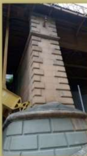
Aparelho de apoio dos arcos junto a base do pilar de concreto
