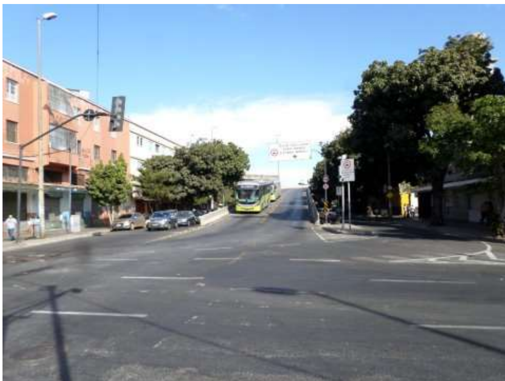
F16/FS – Vista da cabeceira 2, alça do Viaduto Nansen Araújo (exclusiva para ônibus), que vem da Av. Oiapoque.
