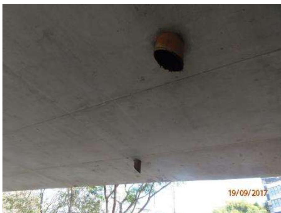
- Drenos sob o tabuleiro.
