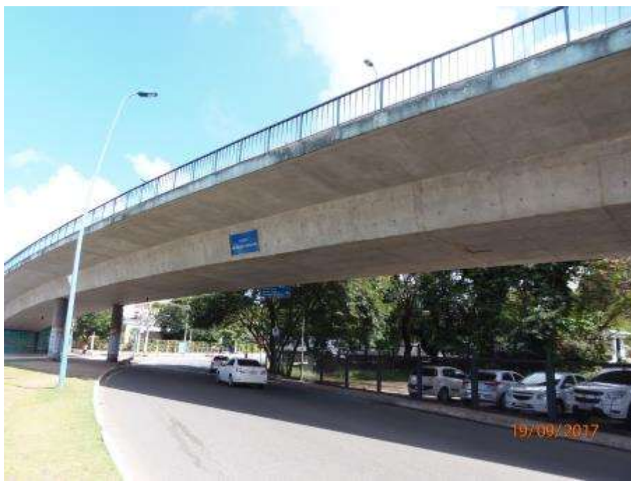
- Viaduto Mamede Paes Mendonça
