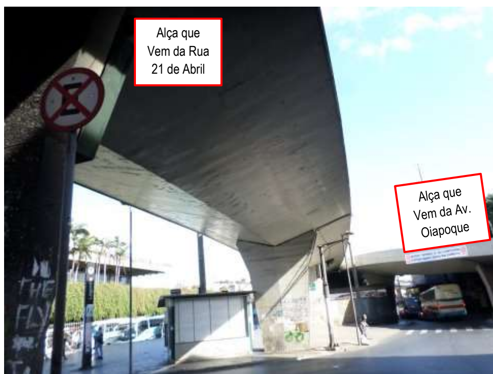
F14/FS – Continuação da vista geral da lateral direita do viaduto, cabeceira 1 na Rua 21 de Abril com a outra alça do Viaduto Nansen Araújo (exclusivo para ônibus), cabeceira que vem da Av. Oiapoque.
