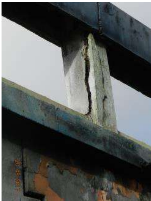
- Guarda corpo com ferragem aparente e pilaretes com rachadura.
