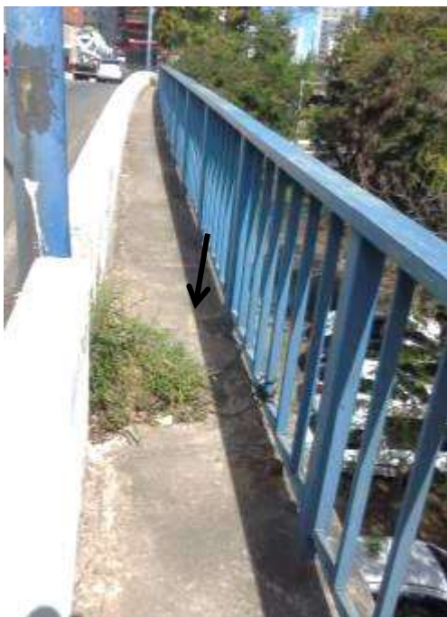
- Fios condutores de energia aparentes e expostos cobertos por vegetação.
