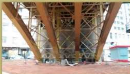
Vista inferior dos arcos de aço da superestrutura do viaduto
