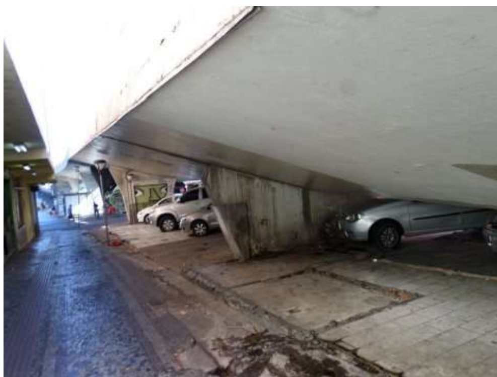
F04/FS – Vista da lateral esquerda do viaduto 5
