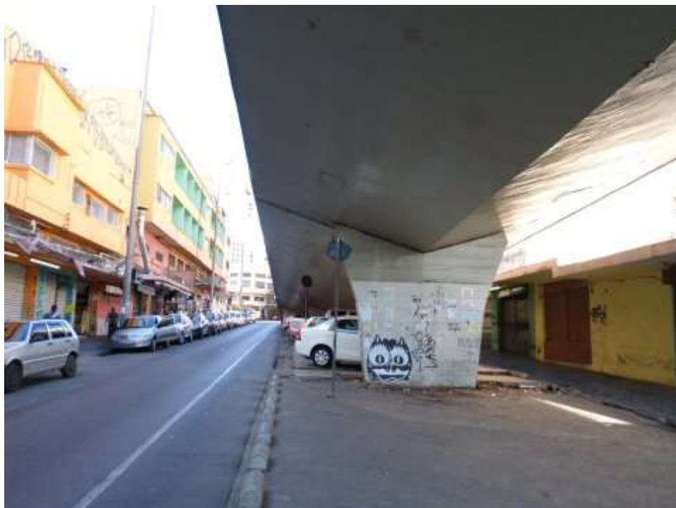
F13/FS – Vista geral da lateral direita 7 do viaduto, cabeceira 1 na Rua 21 de Abril.
