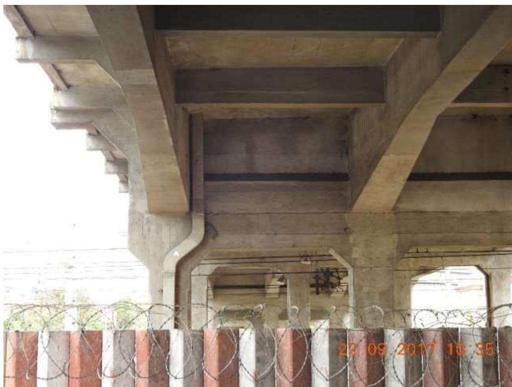
F18/FL – Vista da estrutura, pilares e vigas.
