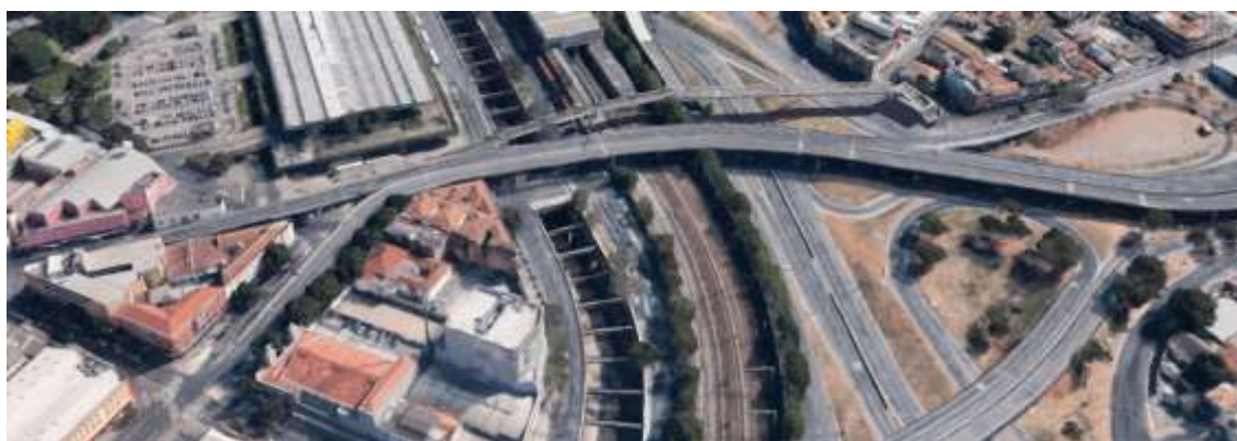
FIG04/FL – Fotografia Aérea do Viaduto Nansen Araújo. Fonte: Google Earth.
