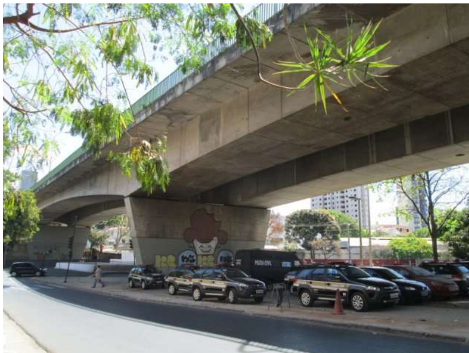
F03/FS – Vista Geral da estrutura do viaduto, Bairro Santa Efigênia.
