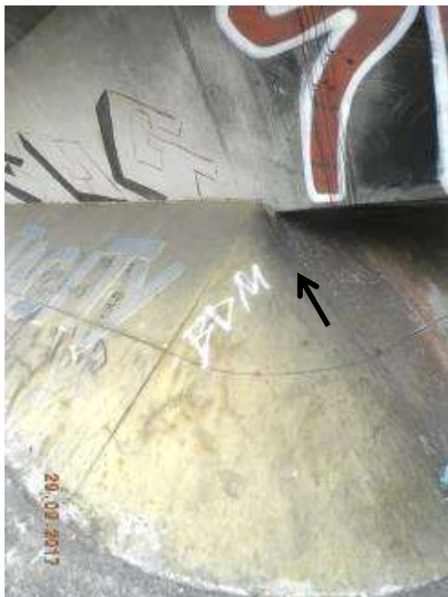
- Trincas na contenção da cabeceira 01 do viaduto.
