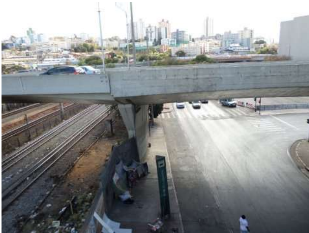
F31/FS – Vista do viaduto com suas 2 alças.
