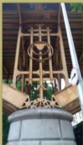
Contraventamento vertical sobre o aparelho de apoio central
