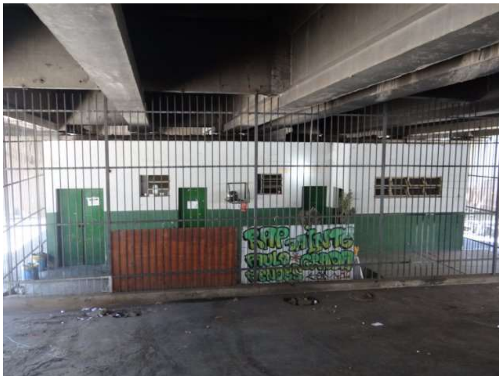
F25/FS – Vista inferior do viaduto, Bairro Floresta, aproveitamento do espaço (instalações de apoio ao serviço de limpeza urbana).
