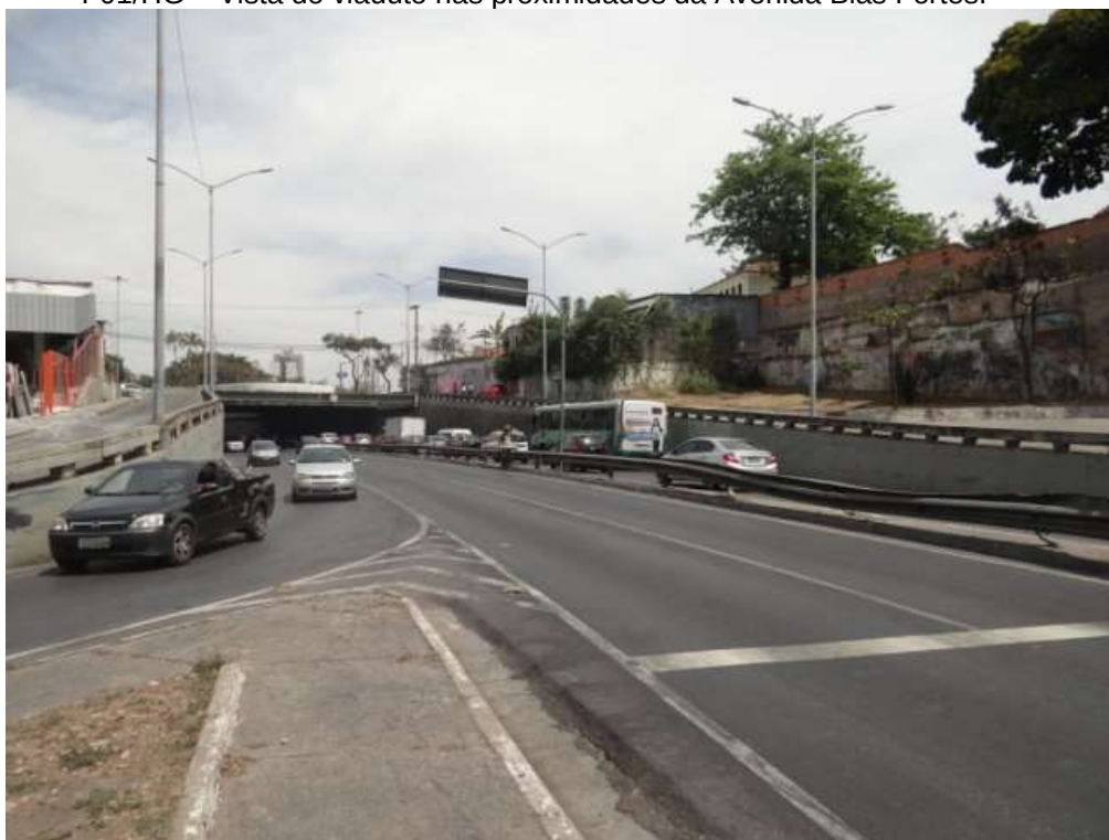
F02/HG – Vista do viaduto nas proximidades da Av. Pedro II.
