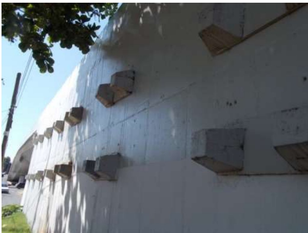
F20/FL –Viaduto Montese, conjunto dos tirantes.
