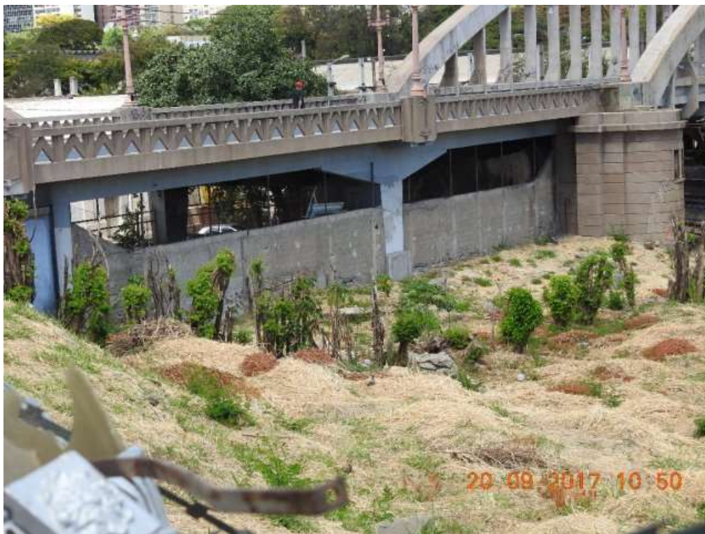
F59/ST – Lateral do viaduto visto da Rua Sapucaí Neste local o público não tem acesso.
