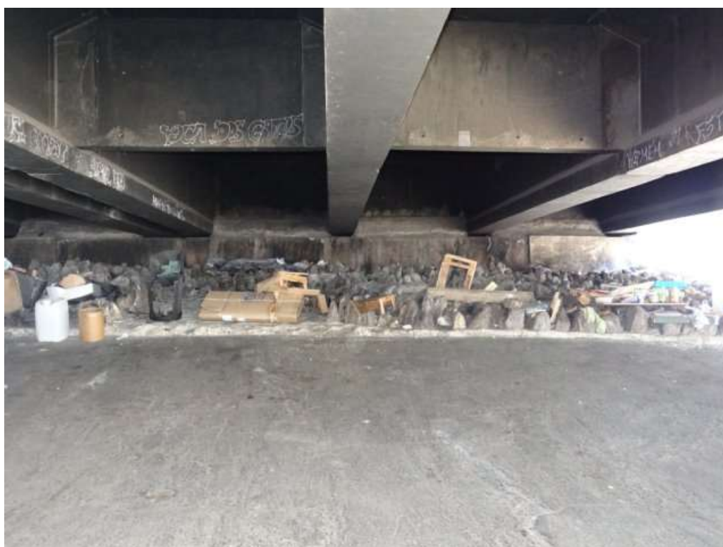
F28/FS – Outra vista inferior do viaduto, Bairro Floresta.
