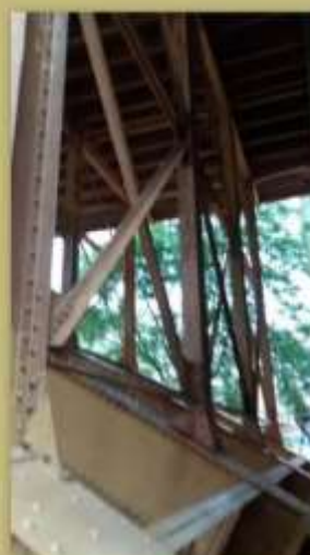
Contraventamento vertical dos arcos do viaduto
