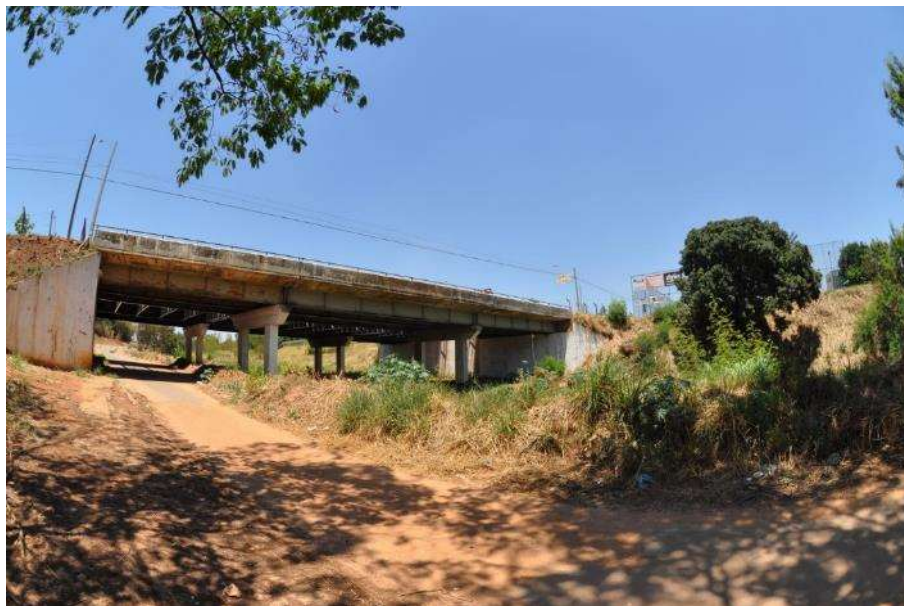
FOTO 19 – Vista geral da Ponte T-63 sentido Centro / Bairro sobre o córrego Cascavel visualizado da parte da Marginal Cascavel (inacabada).
