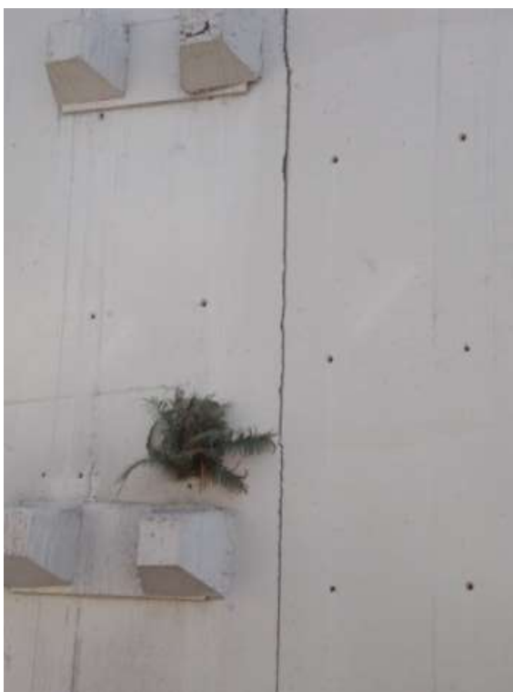
F47/FL –Viaduto Montese, detalhe do elemento descrito acima.
