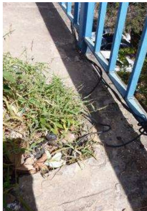
- Fios condutores de energia aparentes e expostos cobertos por vegetação.
