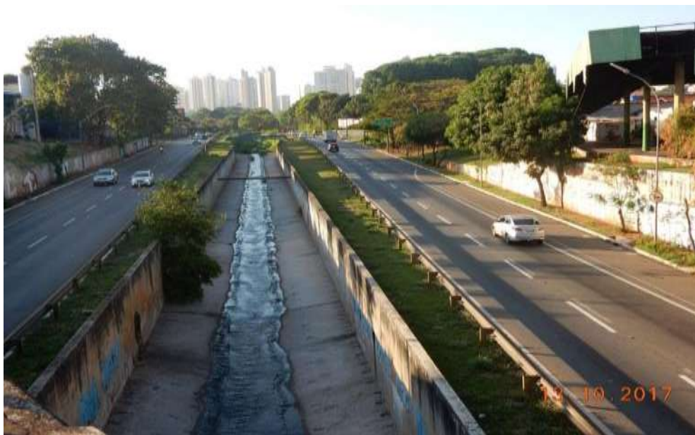
FOTO. 2 – Vista Norte Sul com o observador no passeio da Avenida Fuad José Sebba, a jusante. No centro da foto, canal em concreto para escoamento da água do córrego Botafogo e das águas pluviais das duas pistas da Marginal Botafogo. À direita, pista norte-sul, da Marginal Botafogo. À esquerda, pista sul norte da Marginal.
