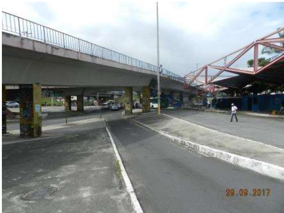
- Viaduto Marta Vasconcelos – sentido Nazaré.
