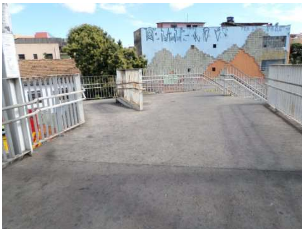
F40/FS – Vista do final da passarela.
