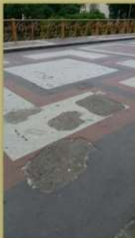
Detalhe do piso do viaduto em pastilha (ausência de várias peças)
