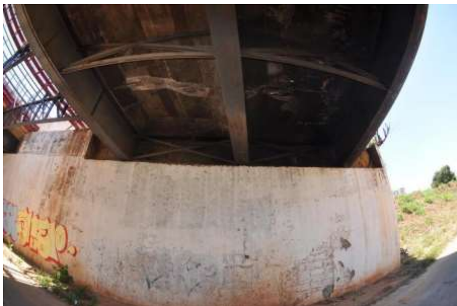
FOTO 41 – Vista da contenção do aterro da cabeceira da ponte na Ponte T-63 sobre o córrego Cascavel visualizado da Avenida T-63 sentido Centro / Bairro.
