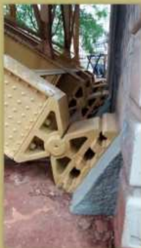
Aparelho de apoio dos arcos junto a base do pilar de concreto
