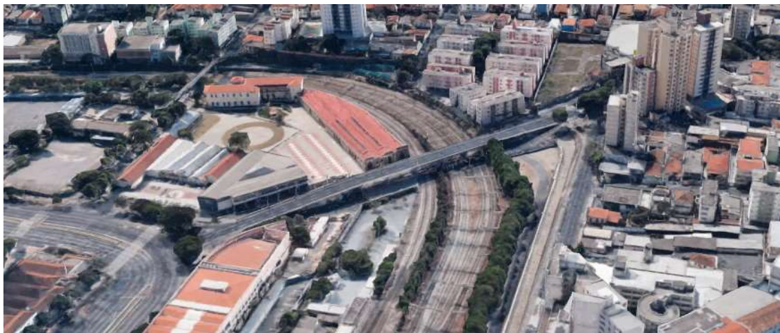
FIG04/FL – Fotografia Aérea do Viaduto da Floresta. Fonte: Google Earth.
