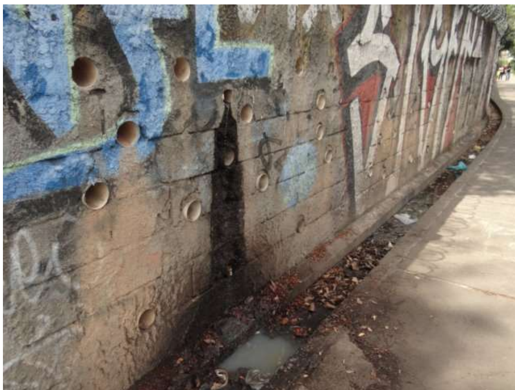
F10/HG – Detalhe lançamento de esgoto na canaleta de drenagem.
