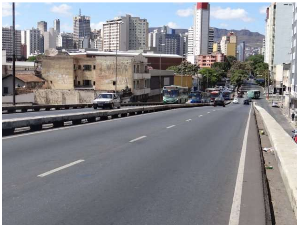
F48/HG – Detalhe do bom estado de conservação da pavimentação asfáltica.
