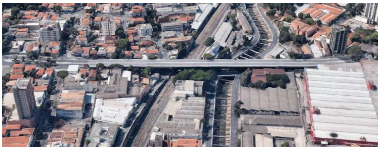
FIG04/FL – Fotografia Aérea do Viaduto Pedro Aguinaldo Fulgêncio. Fonte: Google Earth.
