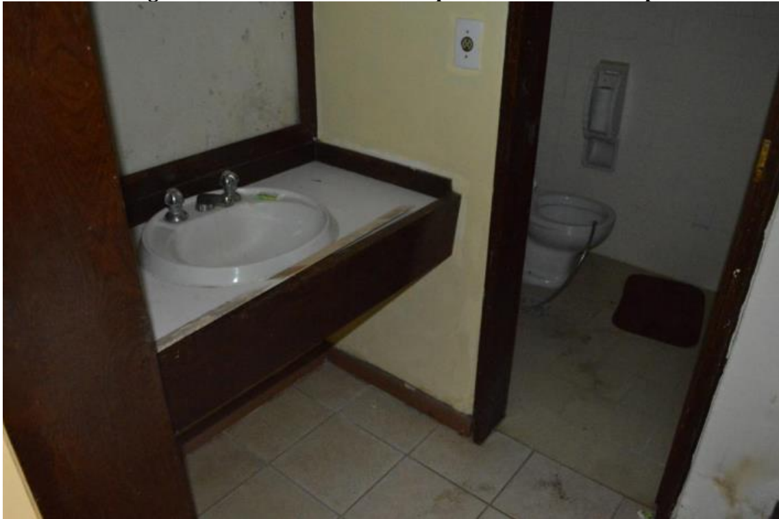
Figura 29 - Banheiro de um dos quartos do Hotel Macapá
