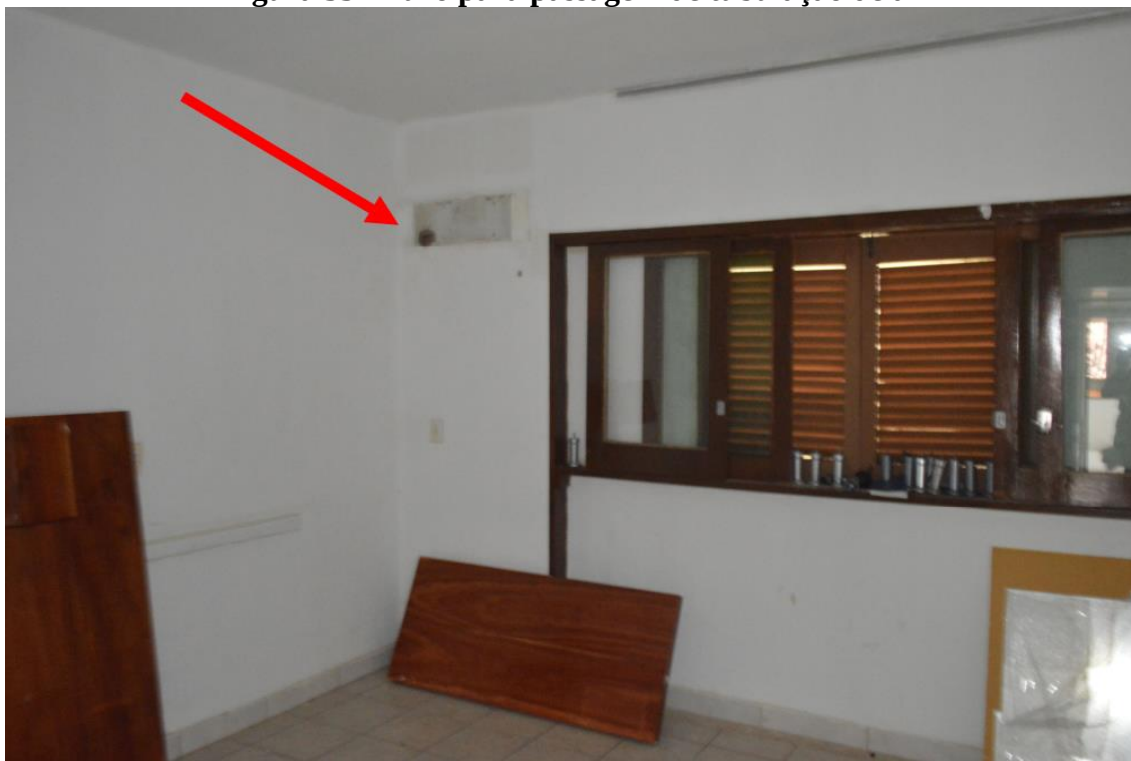
Figura 53 - Furo para passagem de tubulação de ar
