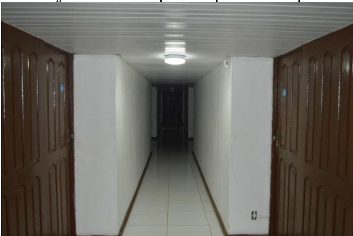
Figura 28 - Corredor dos quartos no 1º piso do Hotel Macapá
