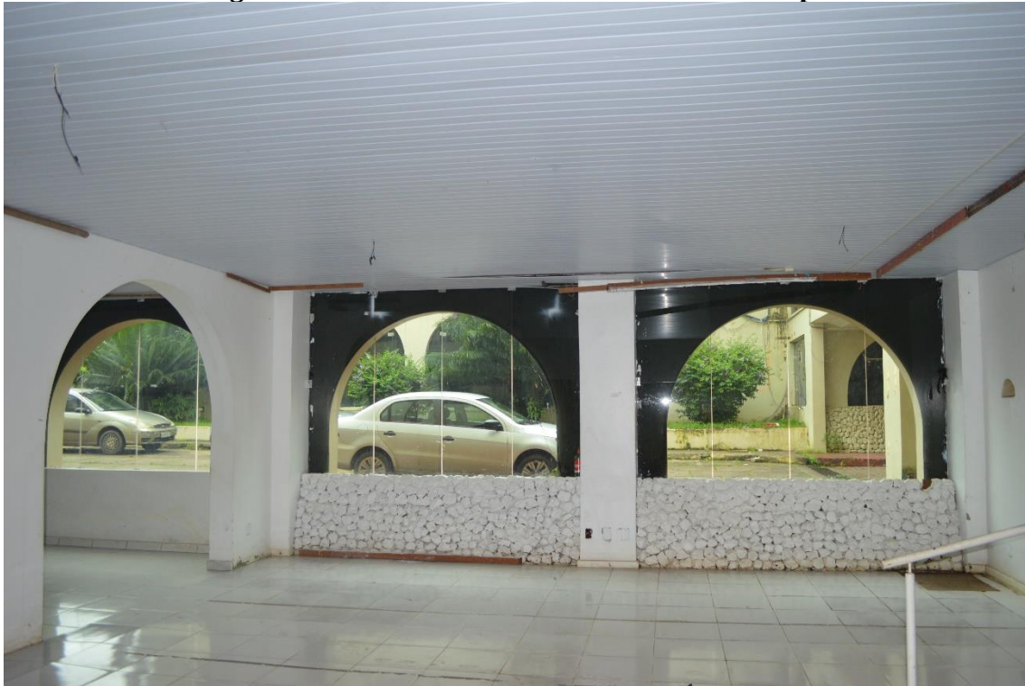
Figura 27 - Entrada do auditório do Hotel Macapá
