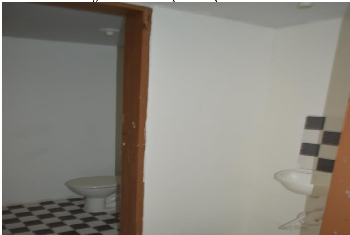
Figura 58 - Substituição de louças sanitárias
