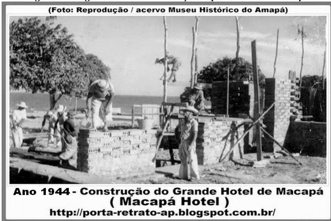
Figura 6 - Imagem do início da construção do prédio do Hotel Macapá
