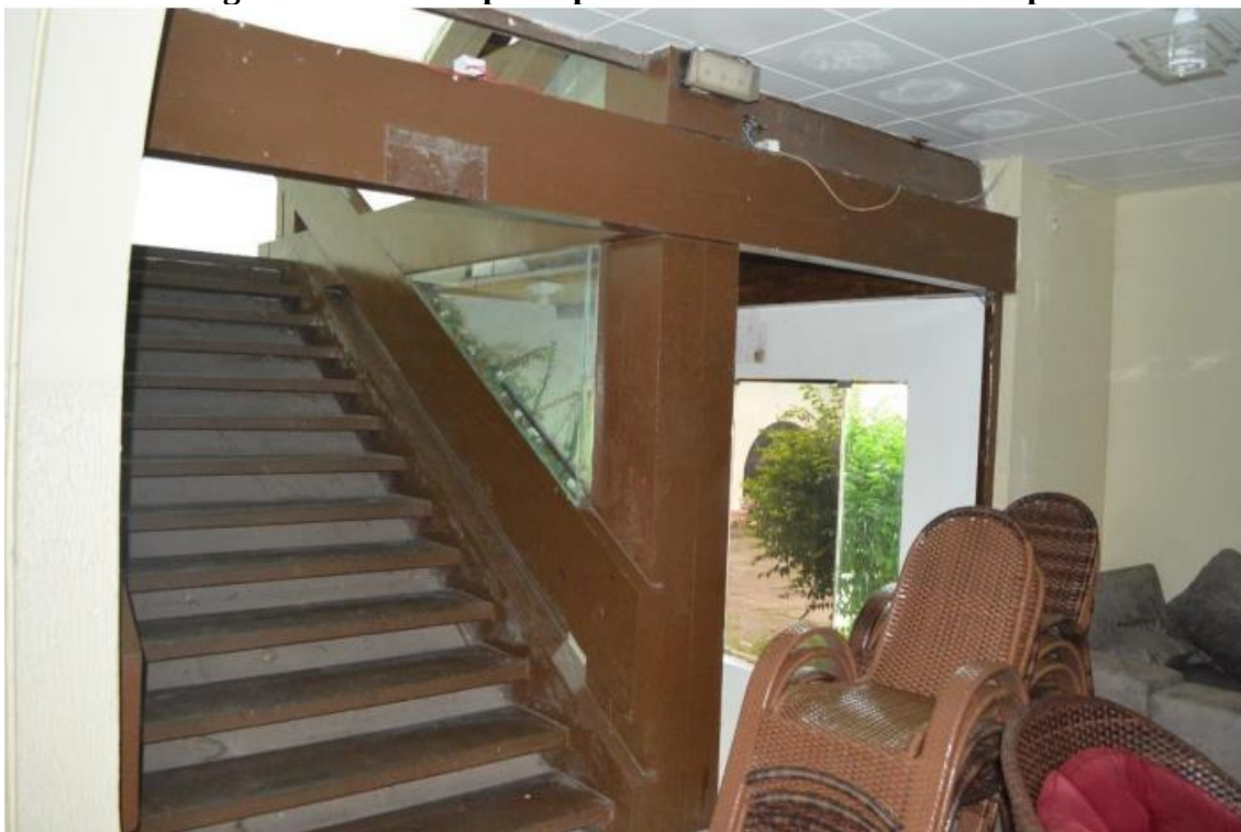
Figura 26 - Escada principal de madeira do Hotel Macapá
