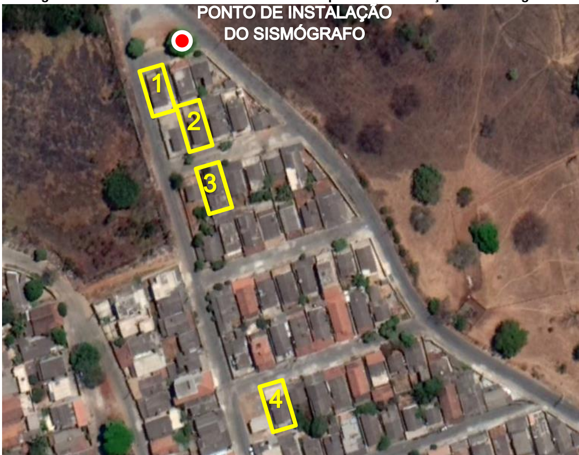
Figura 14 – Local dos imóveis vistoriados e o ponto de instalação do sismógrafo.
