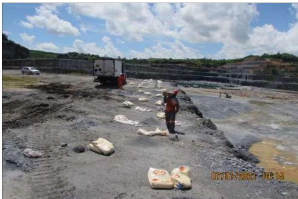
Figura 15 – Vista da extensão da bancada do desmorte realizado no dia 07/01/2021
