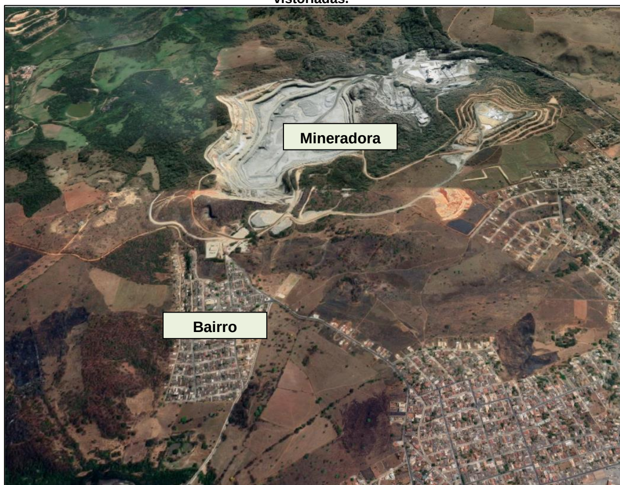
Figura 10 – Localizações da Mineradora e do bairro onde se encontram as edificações vistoriadas.
